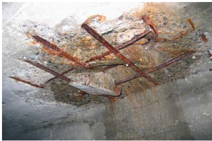
a. Corrosion
