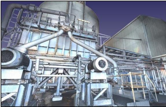
Figura 1: Exemplo de nuvem de pontos colorida
