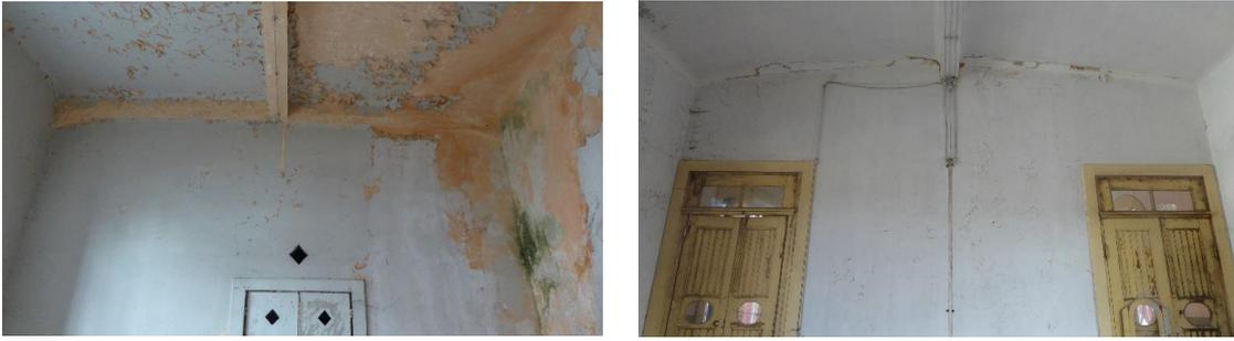
Figura 19: Inventariação, inspeção e diagnóstico - Fotografias de apoio à inspeção e diagnóstico evidenciando a infiltração de água pelos edifícios adjacentes e fissuras em elementos estruturais fruto da movimentação dos elementos estruturais que sustentam o edifício
