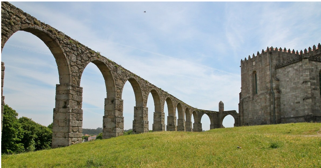
Fig. 10 – Troço final do Aqueduto de Santa Clara de Vila do Conde
