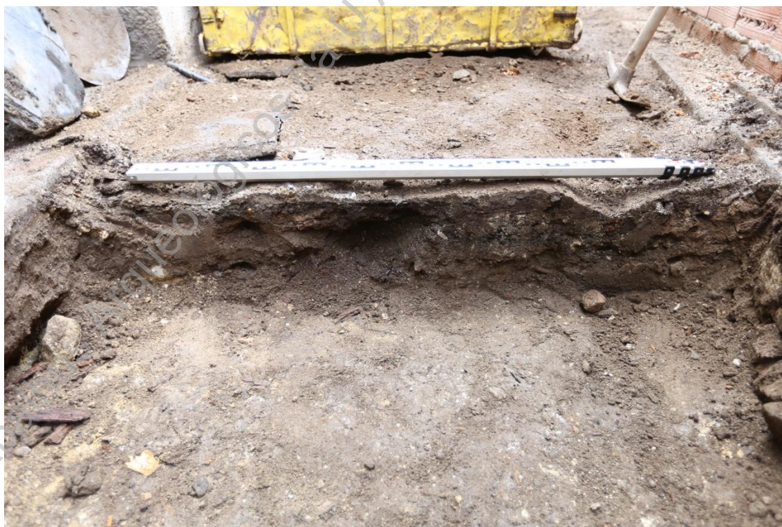
Foto 52 (IMG_2158) – Vista do corte para implantação de sapata 2 (O/E).
