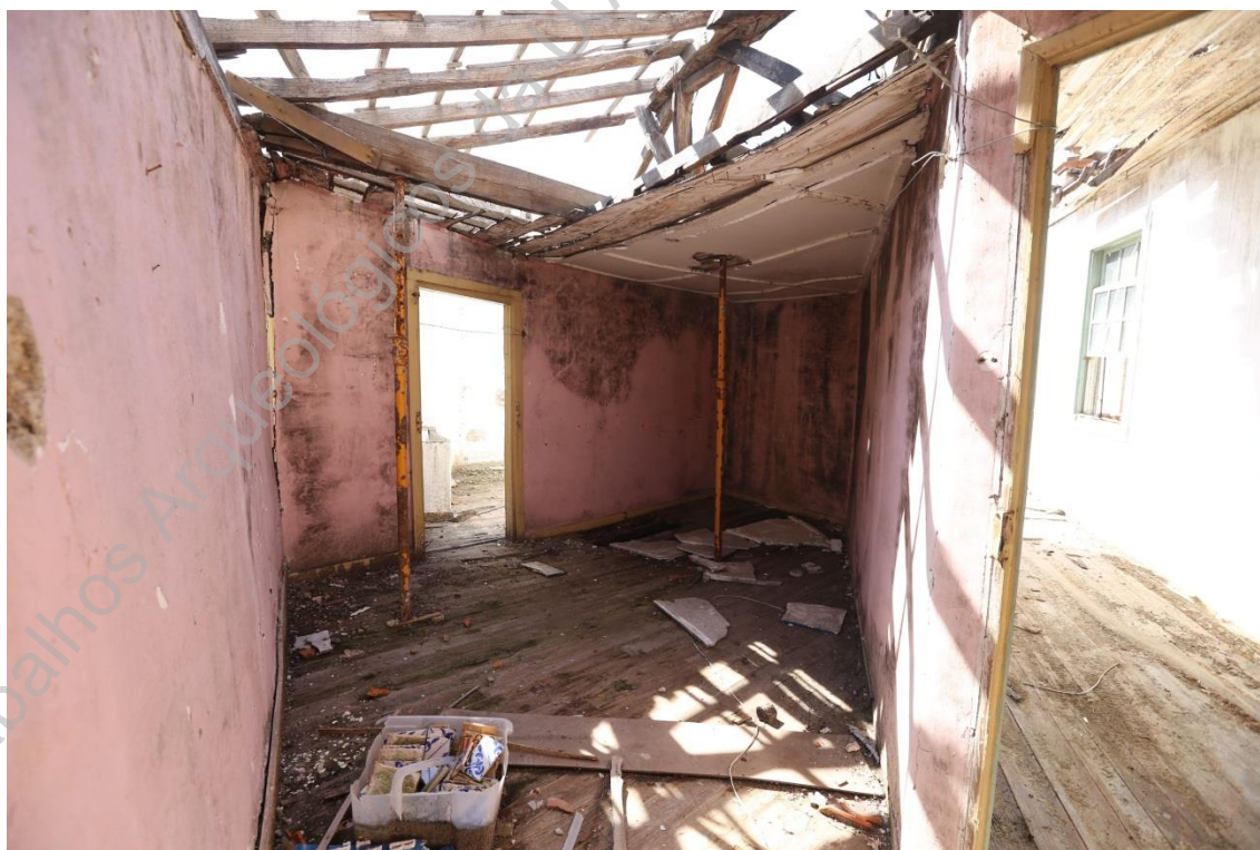
Foto 21 (IMG_1825) – Compartimento no piso 2 (E/O).
