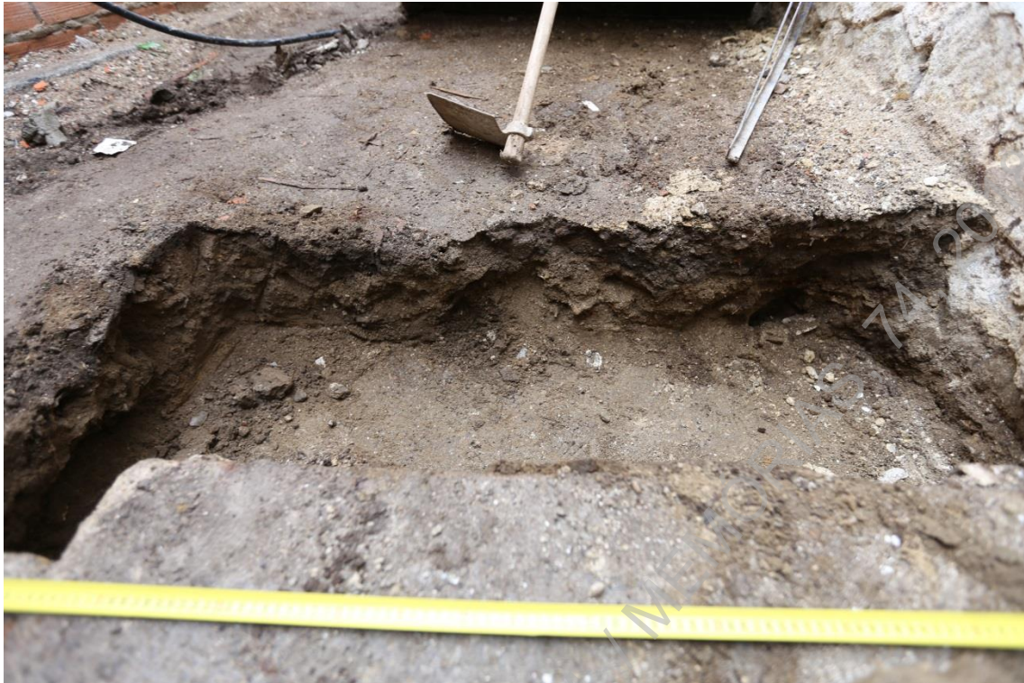
Foto 49 (IMG_2148) – Vista do corte para implantação de sapata 1 (E/O).
