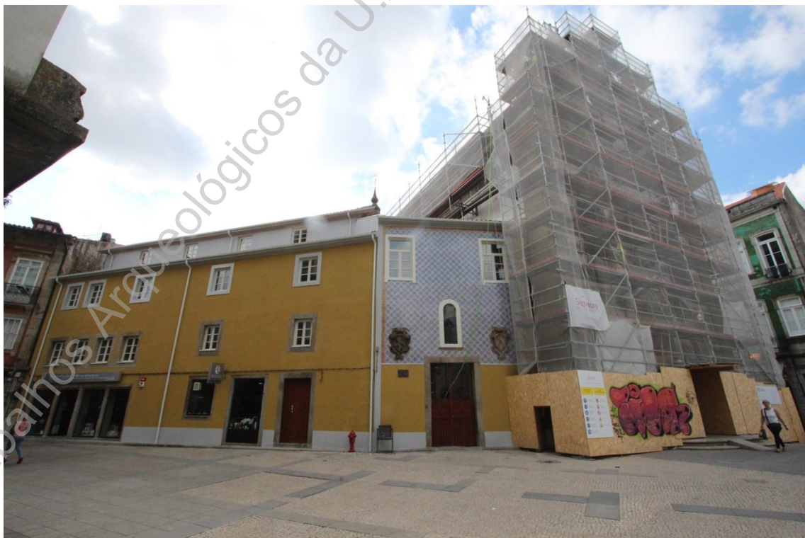
Foto 2 (IMG_8228) – Fachada principal do edifício contíguo à Igreja dos Terceiros após as obras (SE/NO).
