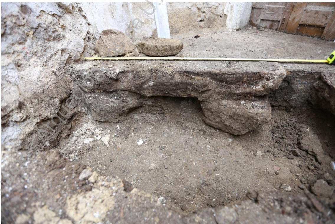
Foto 50 (IMG_2150) – Vista do corte para implantação de sapata 1 (O/E).
