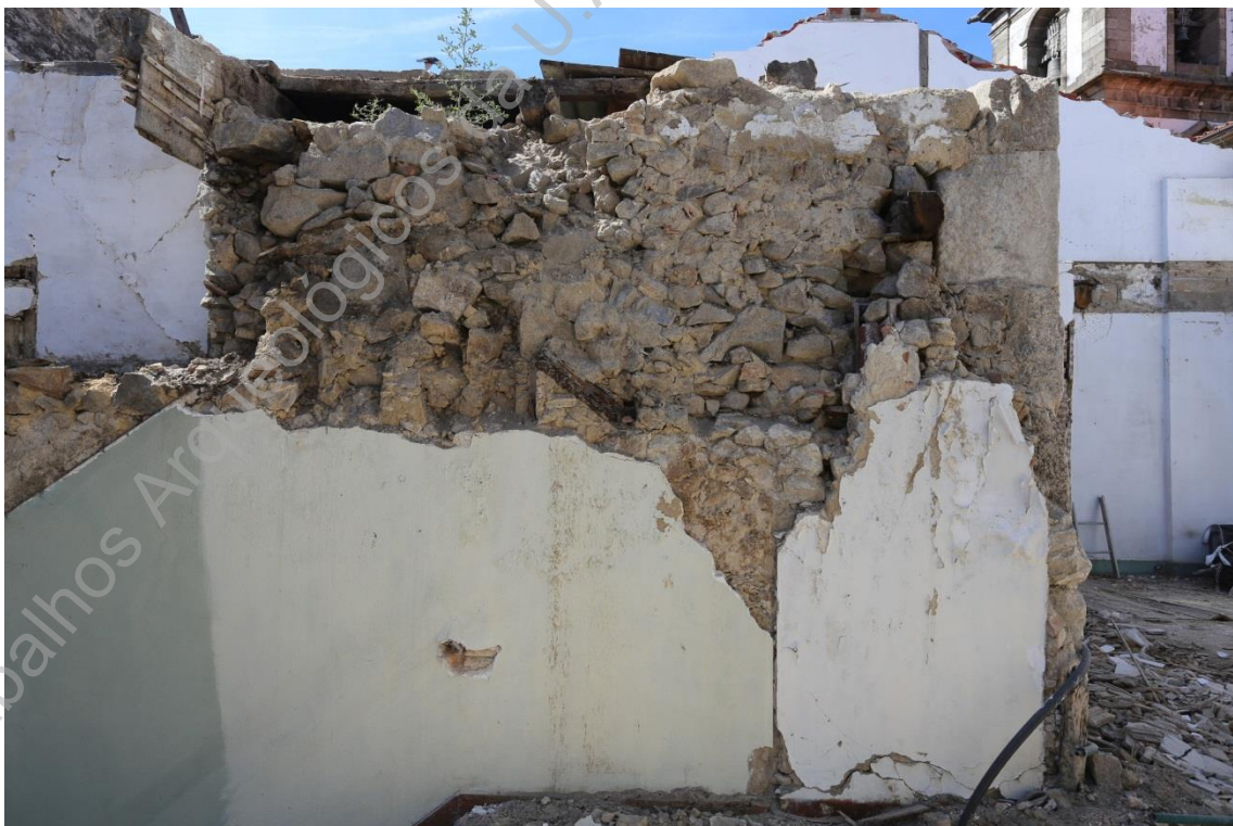
Foto 19 (IMG_1812) – Pormenor de parede no piso 2 (E/O).
