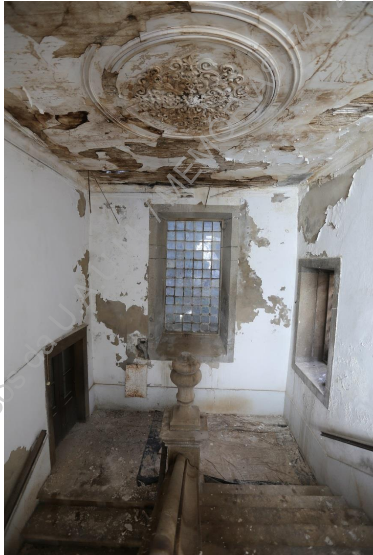
Foto 16 (IMG_1839) – Escadaria em granito que liga rés-do-chão, 1º e 2º piso (N/S).
