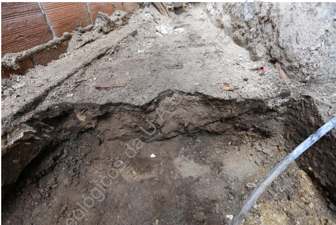
Foto 53 (IMG_2160) – Vista do corte para implantação de sapata 2 (E/O).
