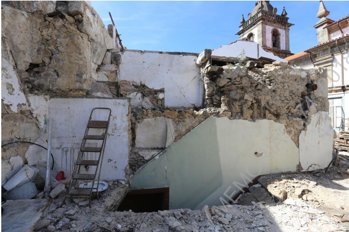
Foto 18 (IMG_1808) – Piso 2 durante os trabalhos de demolição (E/O).
