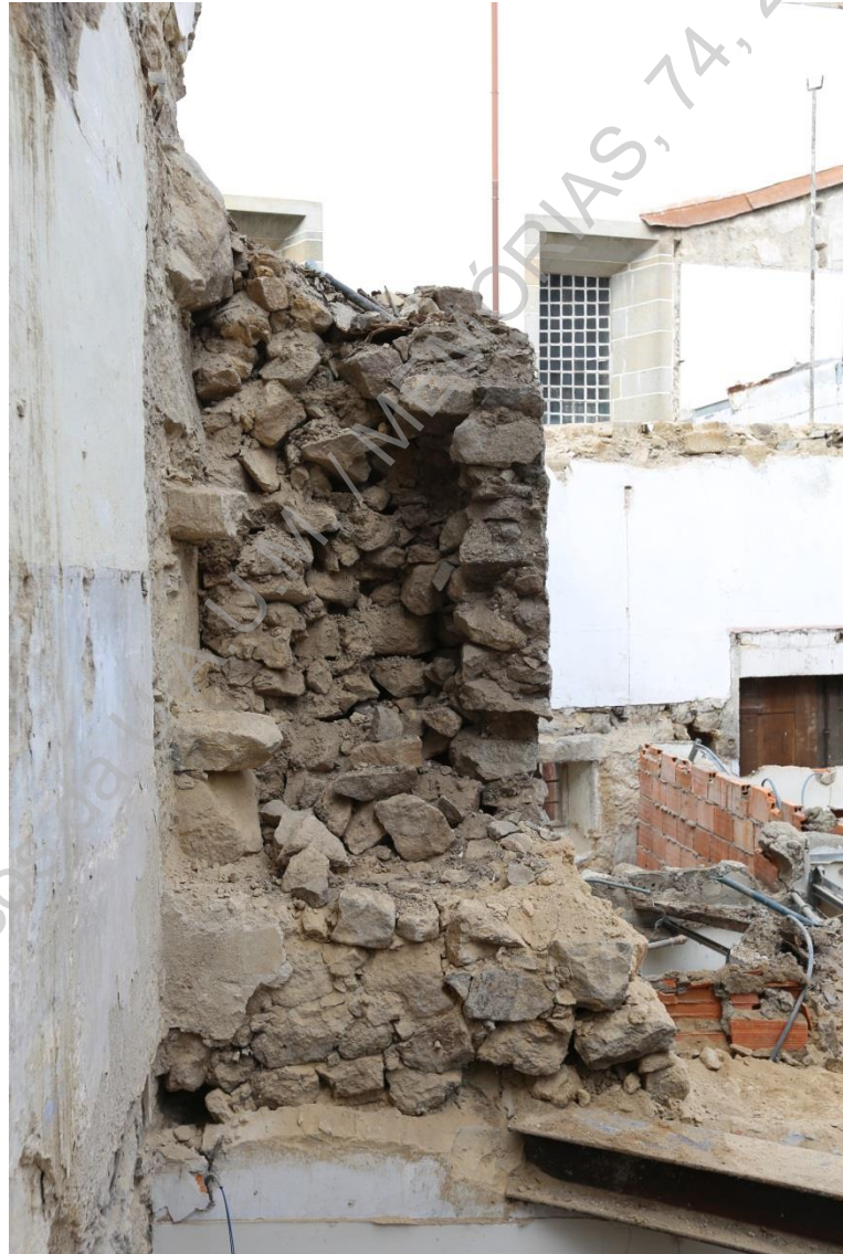
Foto 15 (IMG_2195) – Pormenor de muro de alvenaria no piso 1 durante a demolição (S/N).
