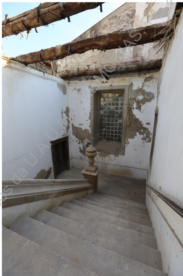
Foto 17 (IMG_1935) – Vão da escadaria após remoção de tetos de estuque (N/S).
