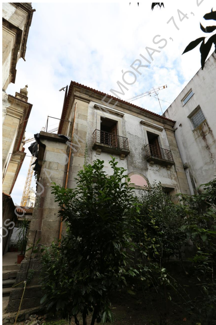
Foto 46 (IMG_2205) – Parede poente da sacristia, vista do jardim (O/E).
