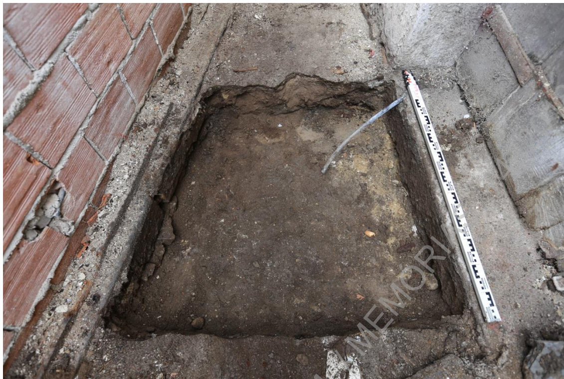
Foto 51 (IMG_2153) – Plano final de vala para sapata 2 (E/O).
