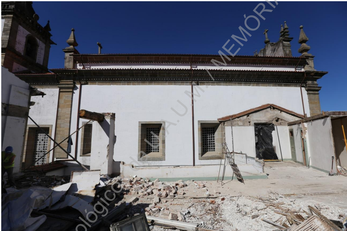
Foto 29 (IMG_2022) – Vista do piso 2 após demolição de parede norte (NE/SO).
