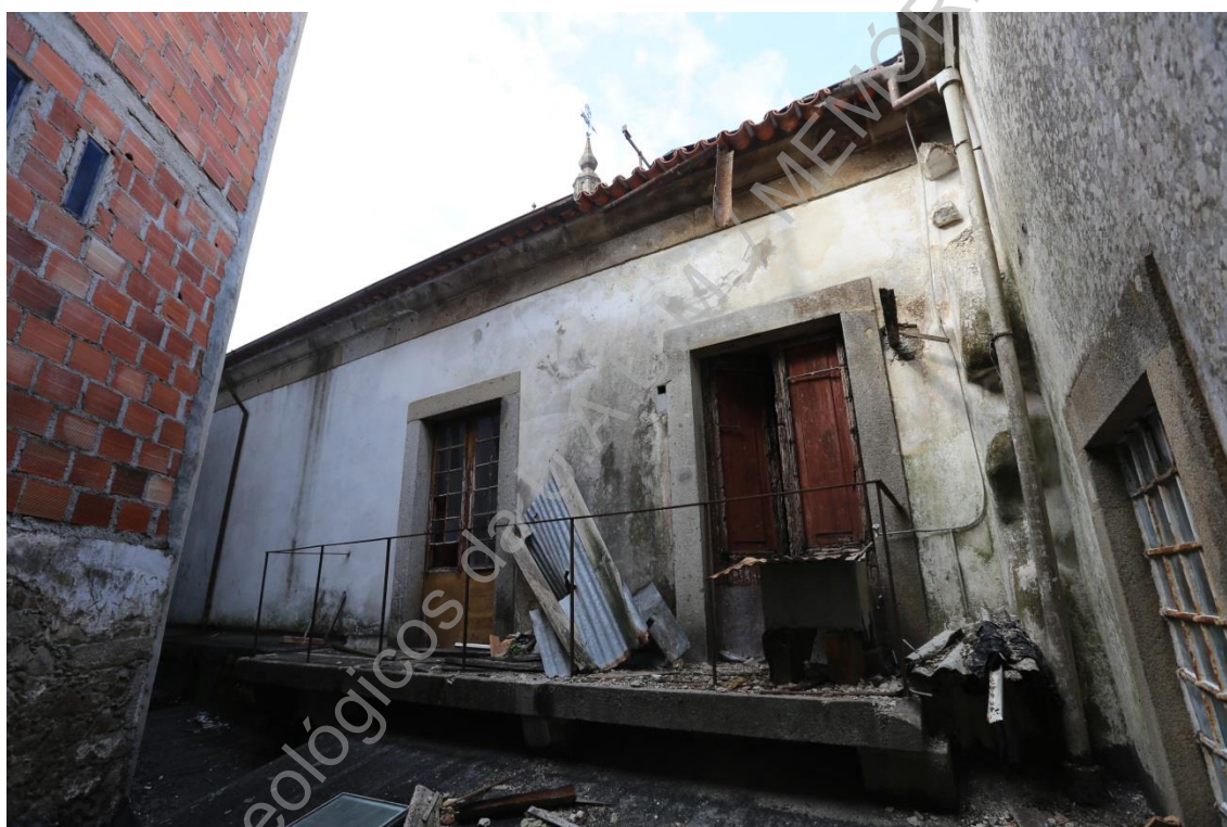
Foto 45 (IMG_1913) – Parede sul da sacristia (SO/NE).
