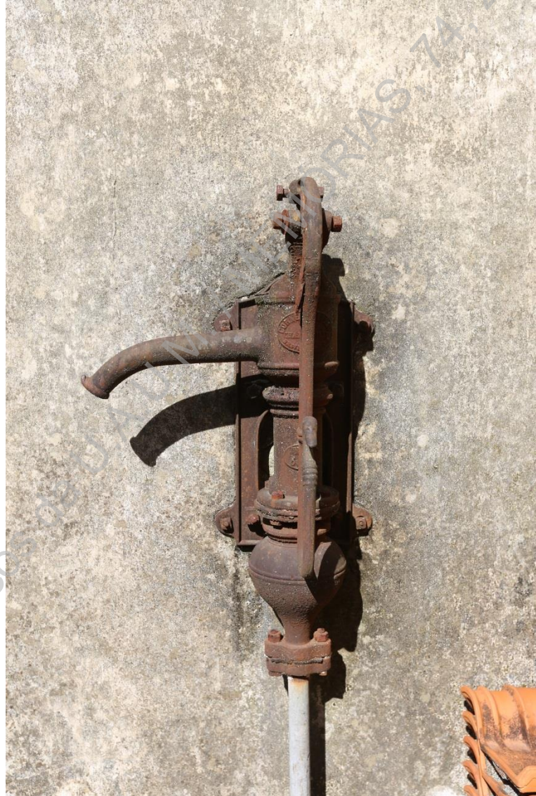
Foto 42 (IMG_1875) – Pormenor da bomba de água (S/N).
