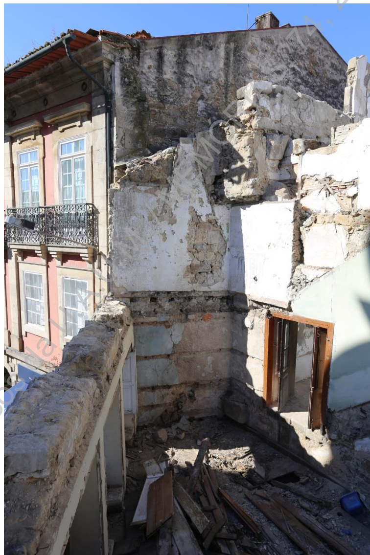
Foto 31 (IMG_2059) – Aspeto de paredes a poente após remoção dos travejamentos de madeira (NE/SO).
