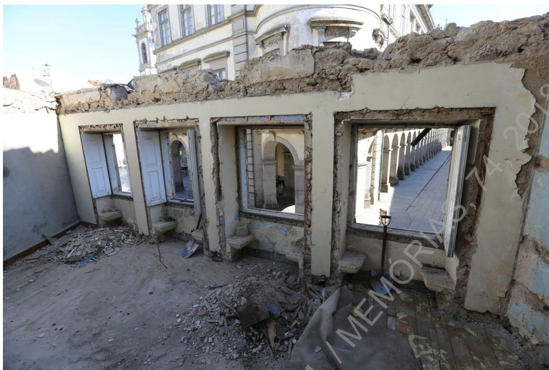
Foto 11 (IMG_2078) – Vista parcial de compartimento no piso 1 após remoção dos traveamentos (NO/SE).
