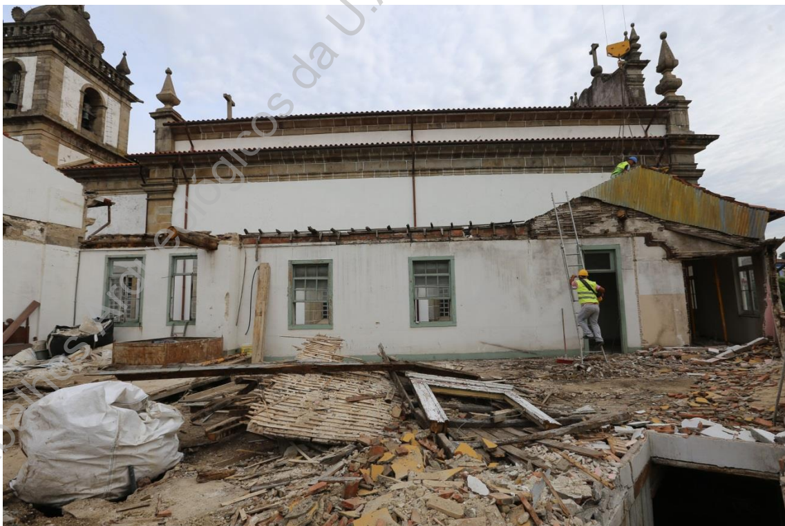
Foto 28 (IMG_1964) – Aspeto do piso 2 durante as demolições (S/N).
