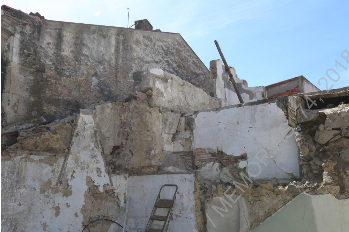
Foto 27 (IMG_1833) – Pormenor de paredes – pisos 2 e 3 – diferentes soluções construtivas (NE/SO).
