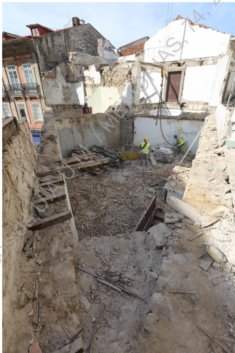
Foto 13 (IMG_2091) – Perspetiva das coroas dos muros e piso 1 durante as demolições (NE/SO).
