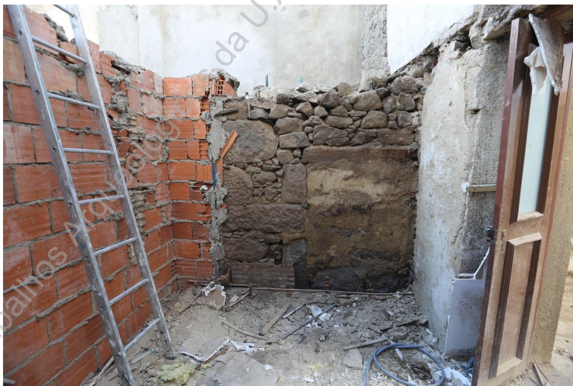
Foto 6 (IMG_2135) – Parede no rés-do-chão após remoção de placas de gesso cartonado que a cobriam (N/S).
