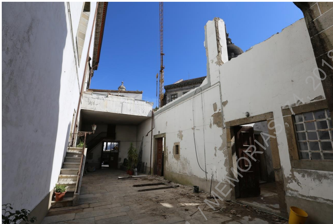
Foto 5 (IMG_2120) – Pátio interior – ligação entre o prédio e a igreja dos Terceiros (NO/SE).
