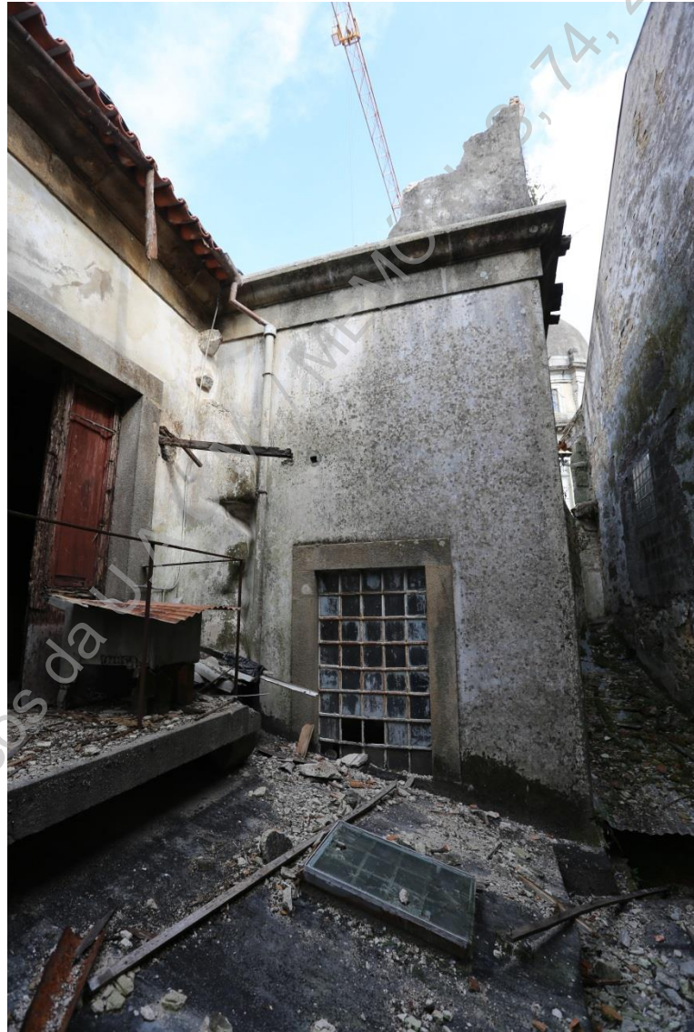
Foto 44 (IMG_1910) – Área exterior – parede norte da escadaria e parede sul da sacristia (SO/NE).
