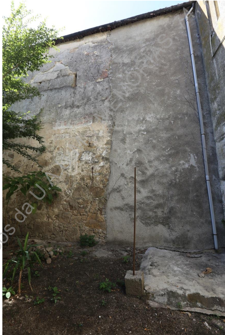
Foto 38 (IMG_1864) – Edifício que limita o jardim nas traseiras da sacristia da igreja dos Terceiros (N/S).
