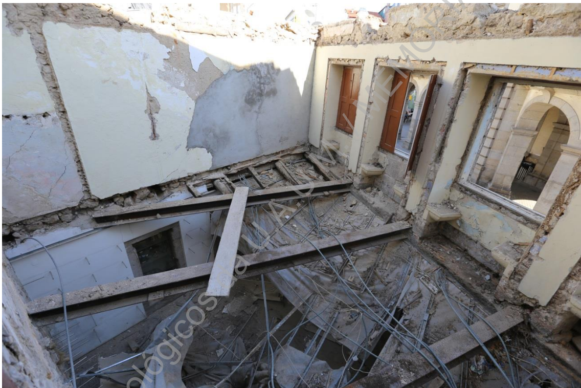
Foto 14 (IMG_2110) – Compartimento do piso 1 durante a remoção do soalho em madeira (NO/SE).
