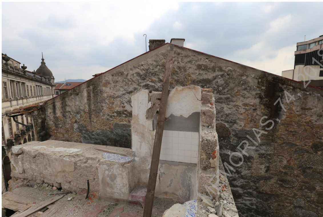
Foto 33 (IMG_1880) – Perspetiva do piso 3 durante dos trabalhos (N/S).
