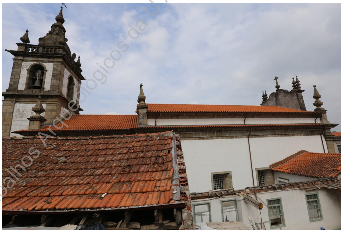
Foto 34 (IMG_1884) – Vista da obra e da igreja dos Terceiros a partir do piso 3 (E/O).
