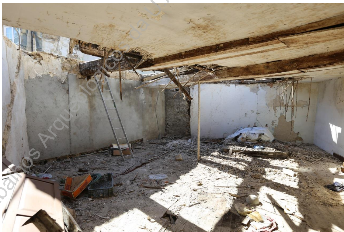
Foto 12 (IMG_2089) – Vista parcial de compartimento no piso 1 (NE/SO).
