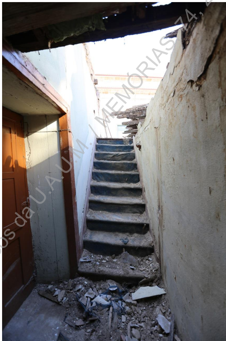
Foto 10 (IMG_1946) – Escadas em madeira – acesso entre 1º e 2º piso (S/N).
