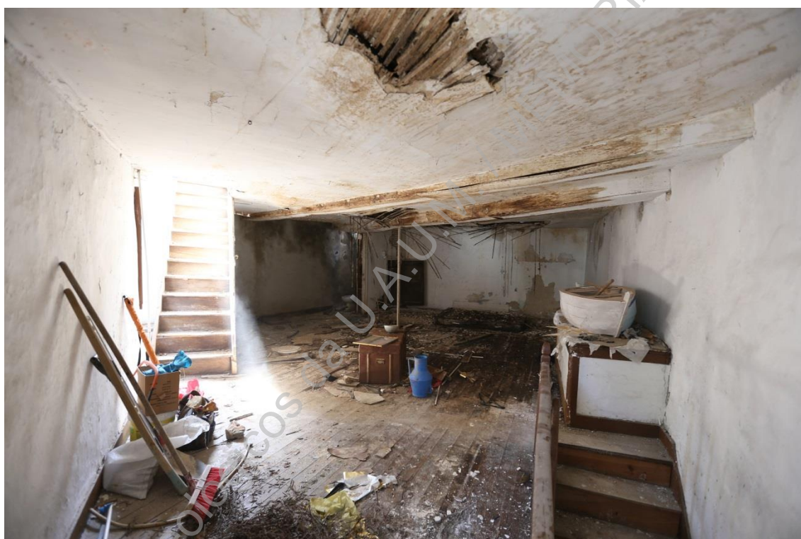
Foto 8 (IMG_1835) – Vista parcial de compartimento no piso 1 (NE/SO).
