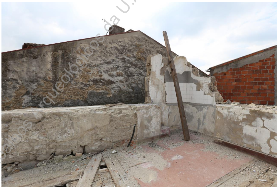
Foto 36 (IMG_1901) – Paredes parcialmente demolidas – piso 3 (NE/SO).
