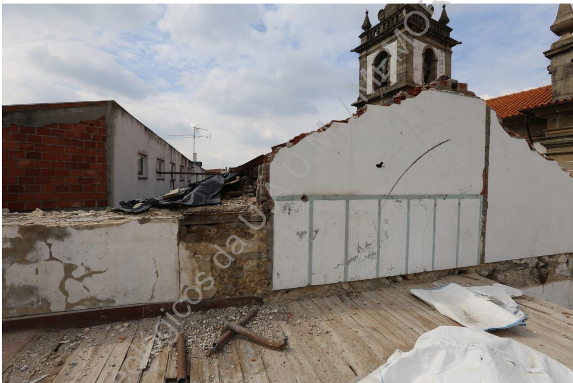
Foto 37 (IMG_1903) – Paredes parcialmente demolidas – piso 3 (E/O).
