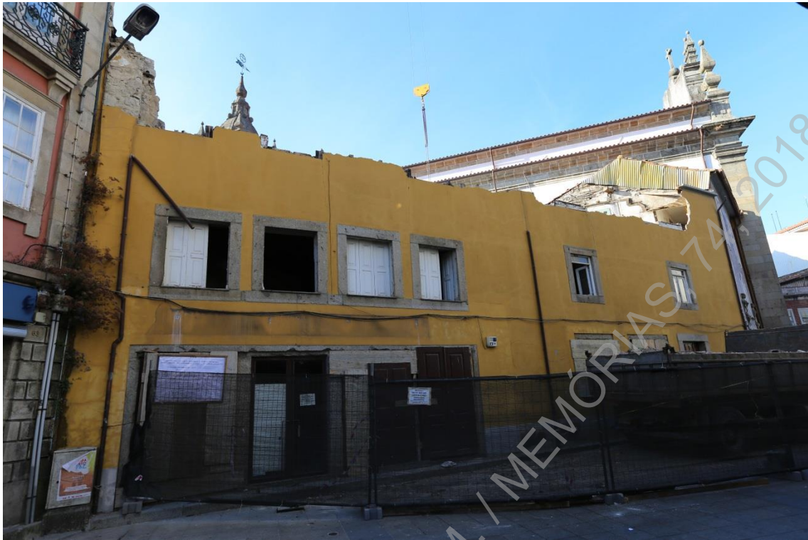
Foto 1 (IMG_1956) – Vista parcial da fachada durante a obra (SO/NE).
