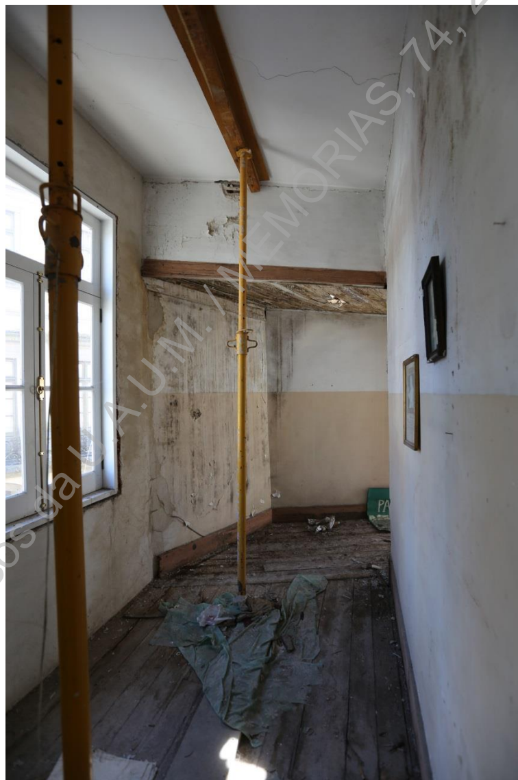
Foto 25 (IMG_1820) – Corredor no piso 2 (S/N).
