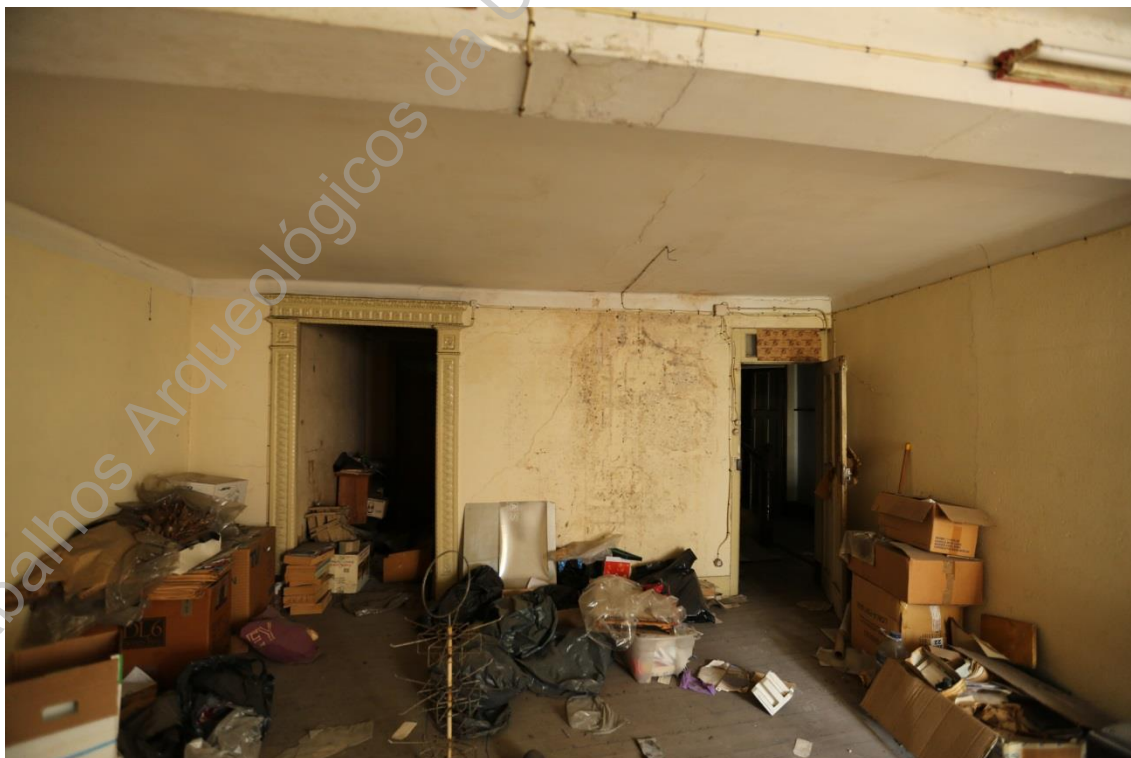
Foto 8 (Z45A7883) – Vista parcial de compartimento no piso 1 (O/E).
