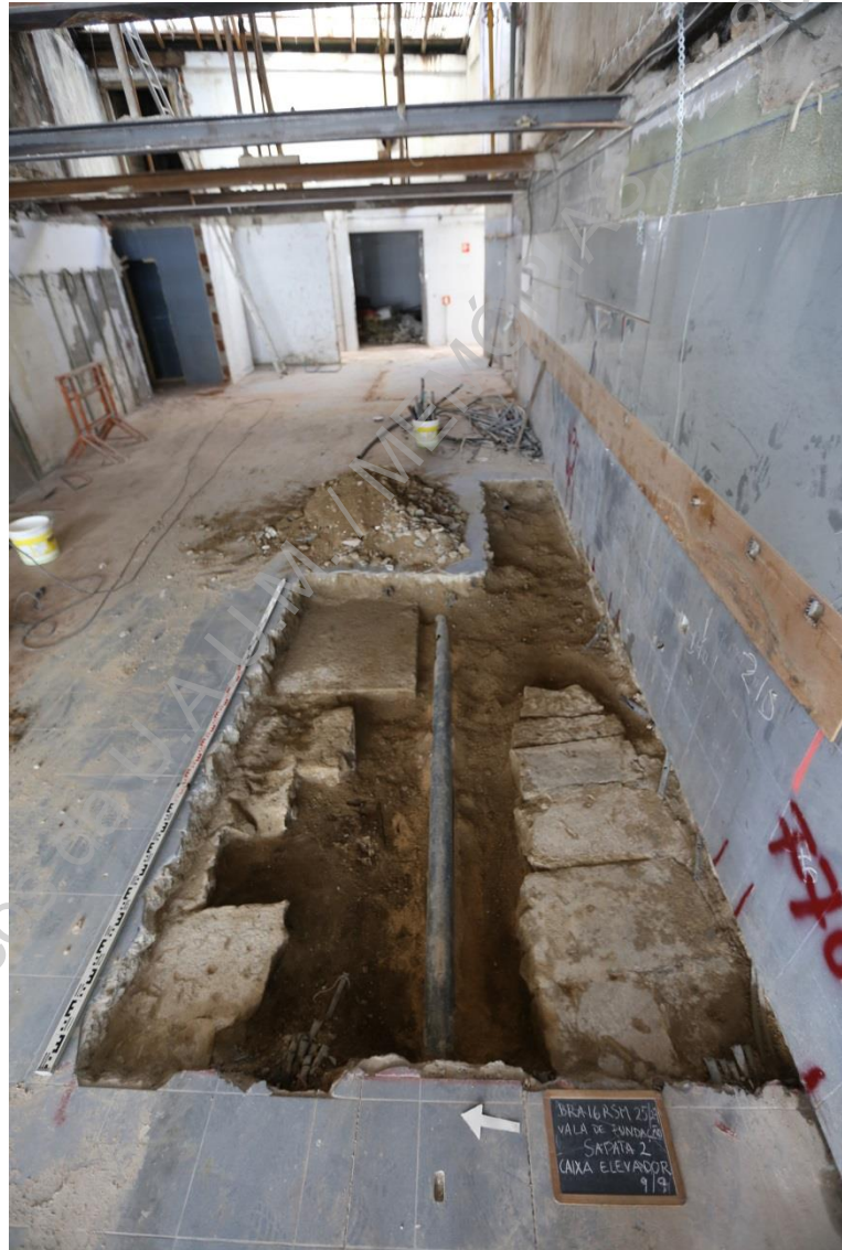
Foto 33 (IMG_1670) – Primeira fase de escavação da vala para a sapata 2 (O/E).
