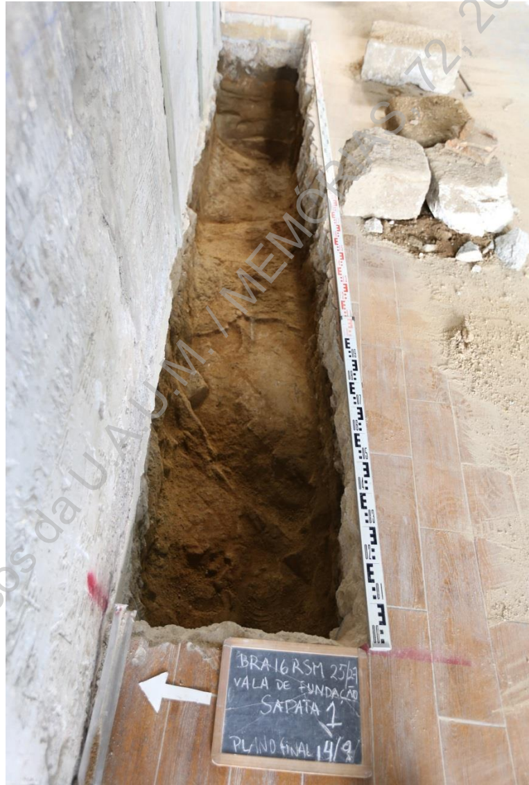
Foto 28 (IMG_1720) – Segunda fase de escavação da sapata 1 (O/E).
