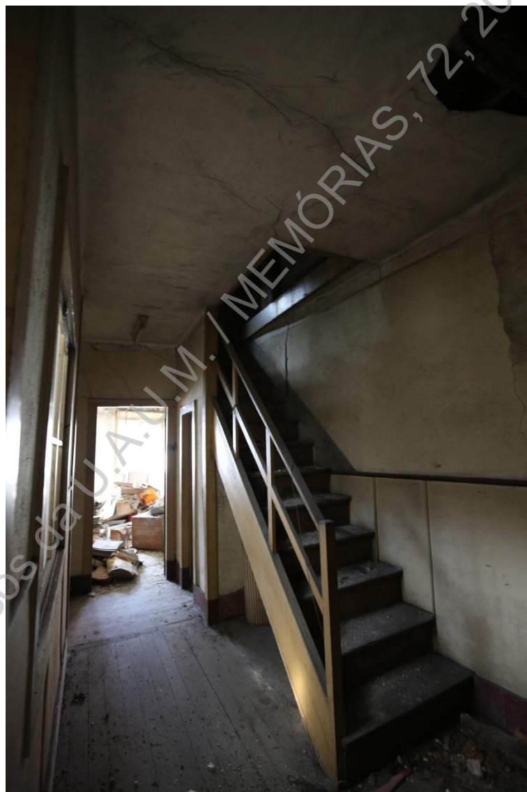
Foto 22 (Z45A7927) – Corredor e escada de acesso ao sótão (E/O).
