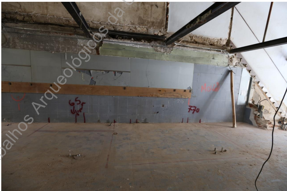
Foto 32 (IMG_1619) – Área de implantação da sapata 2/caixa do elevador (N/S).
