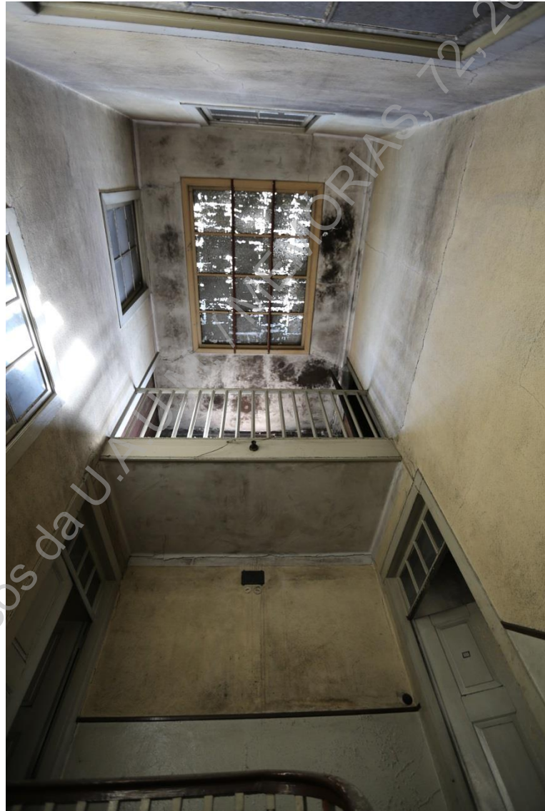
Foto 15 (Z45A7910) – Vista parcial do vão de escadas e claraboia do prédio (N/S).
