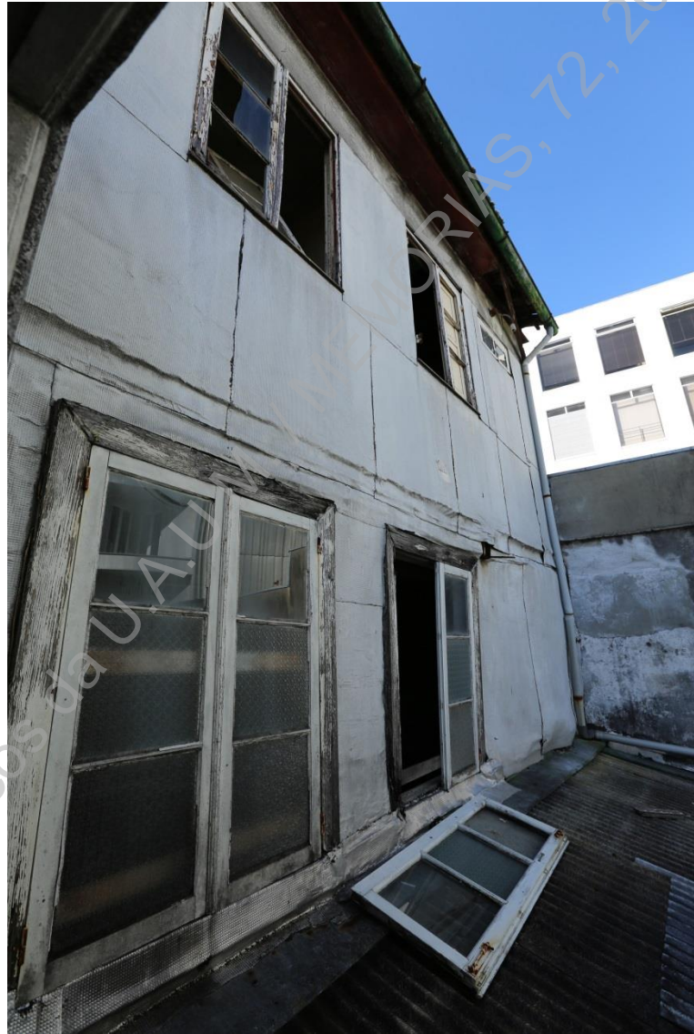
Foto 14 (Z45A7903) – Aspeto da fachada tardoz do prédio vista do piso 2 (SE/NO).
