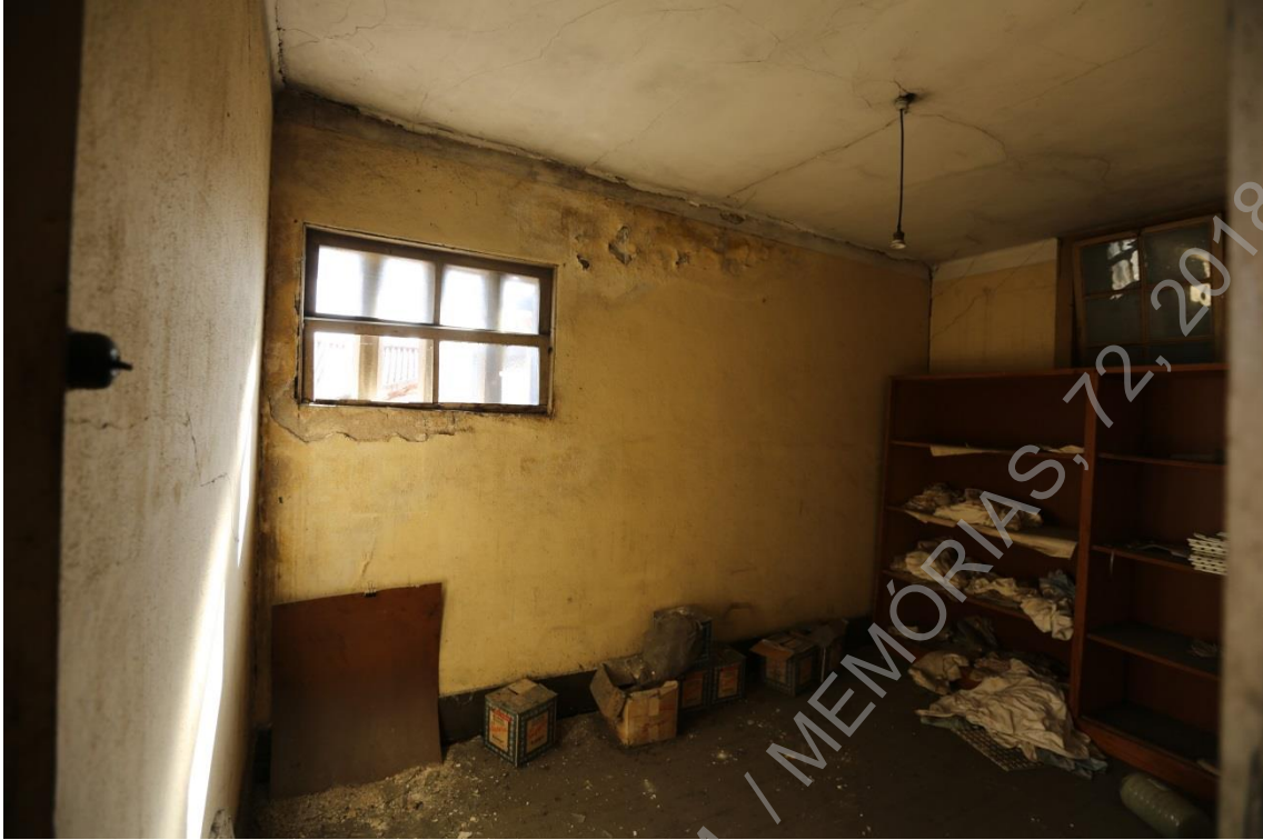
Foto 18 (Z45A7934) – Vista parcial de compartimento no piso 3 (NE/SO).
