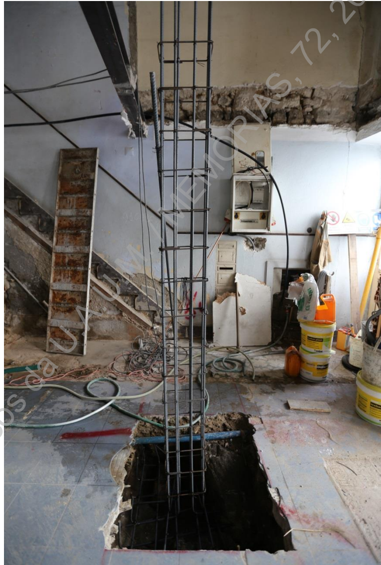
Foto 43 (IMG_2063) – Colocação do ferro para betonagem da sapata 4 (N/S).
