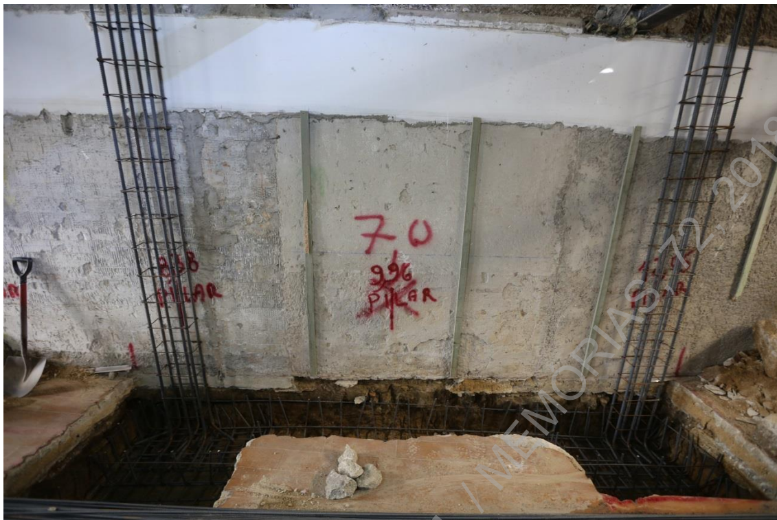
Foto 31 (IMG_2068) – Armação de ferro para betoneira da sapata 1 (S/N).
