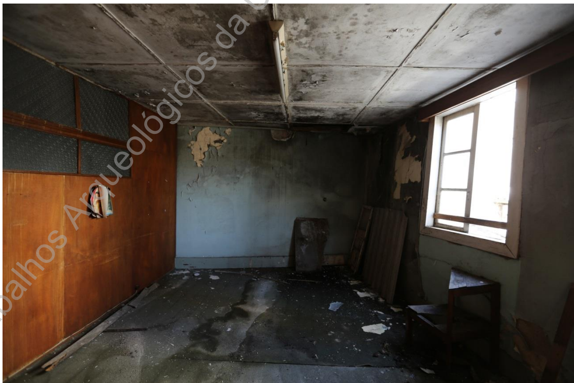
Foto 12 (Z45A7899) – Vista parcial de compartimento no piso 2 (S/N).
