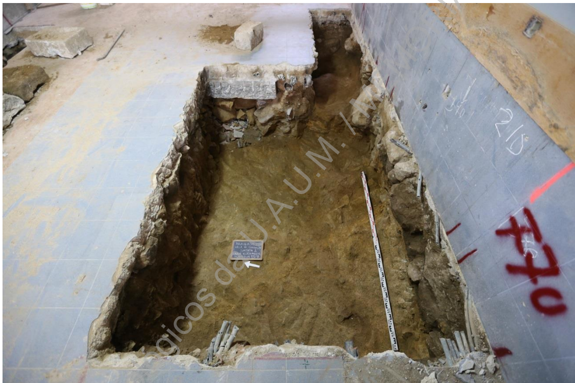
Foto 34 (IMG_1714) – Aspeto final da escavação para implantação da sapata 2 (O/E).
