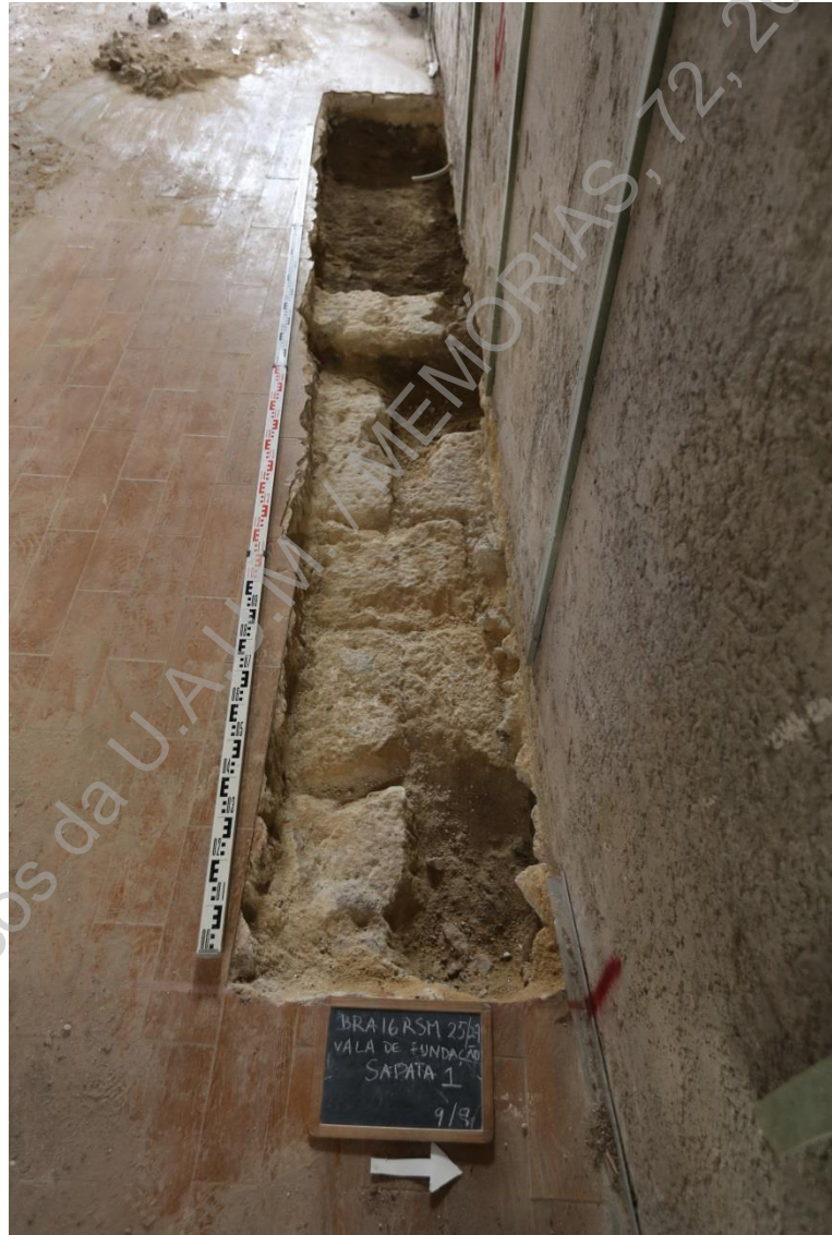
Foto 27 (IMG_1665) – Primeira fase de escavação da sapata 1 (E/O).
