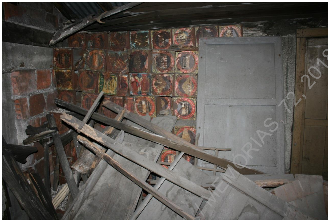
Foto 23 (IMG_2988) – Perspetiva do interior do sótão (O/E).
