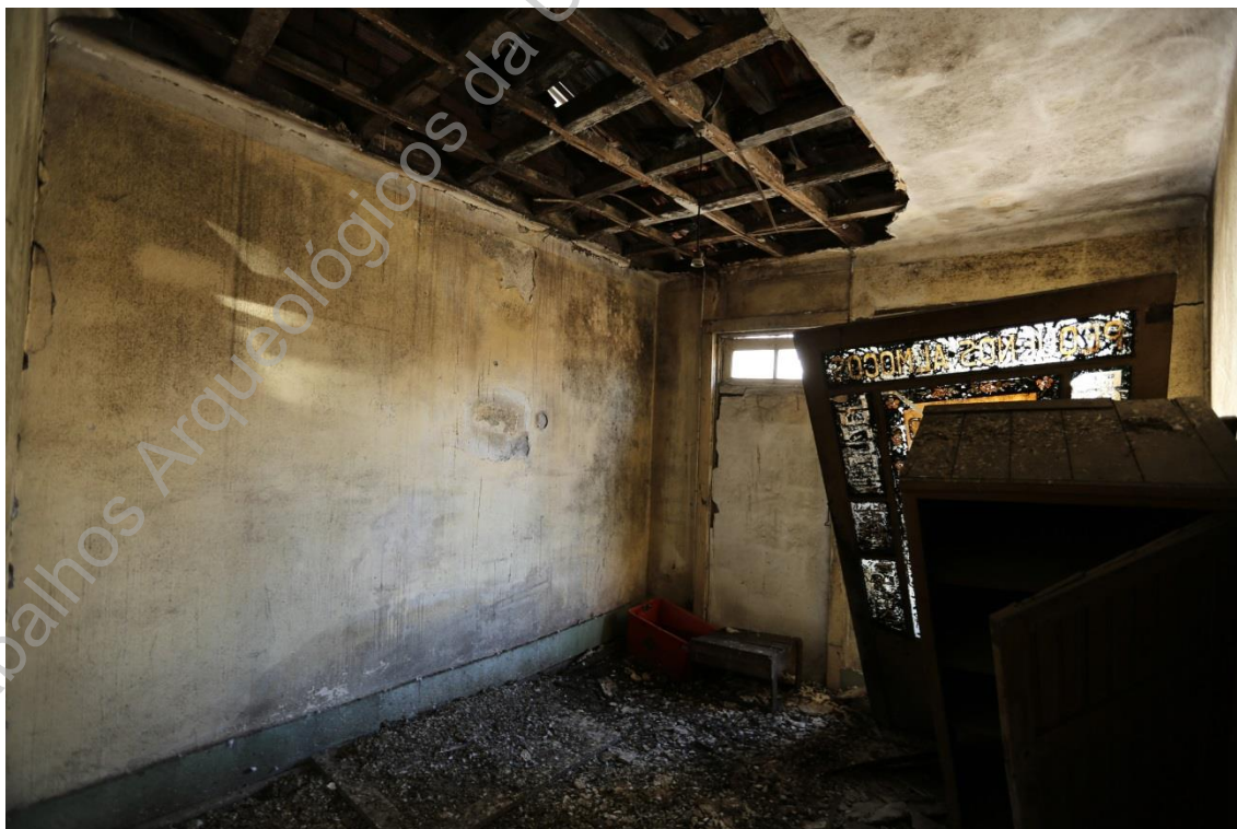
Foto 17 (Z45A7932) – Vista parcial de compartimento no piso 3 (E/O).
