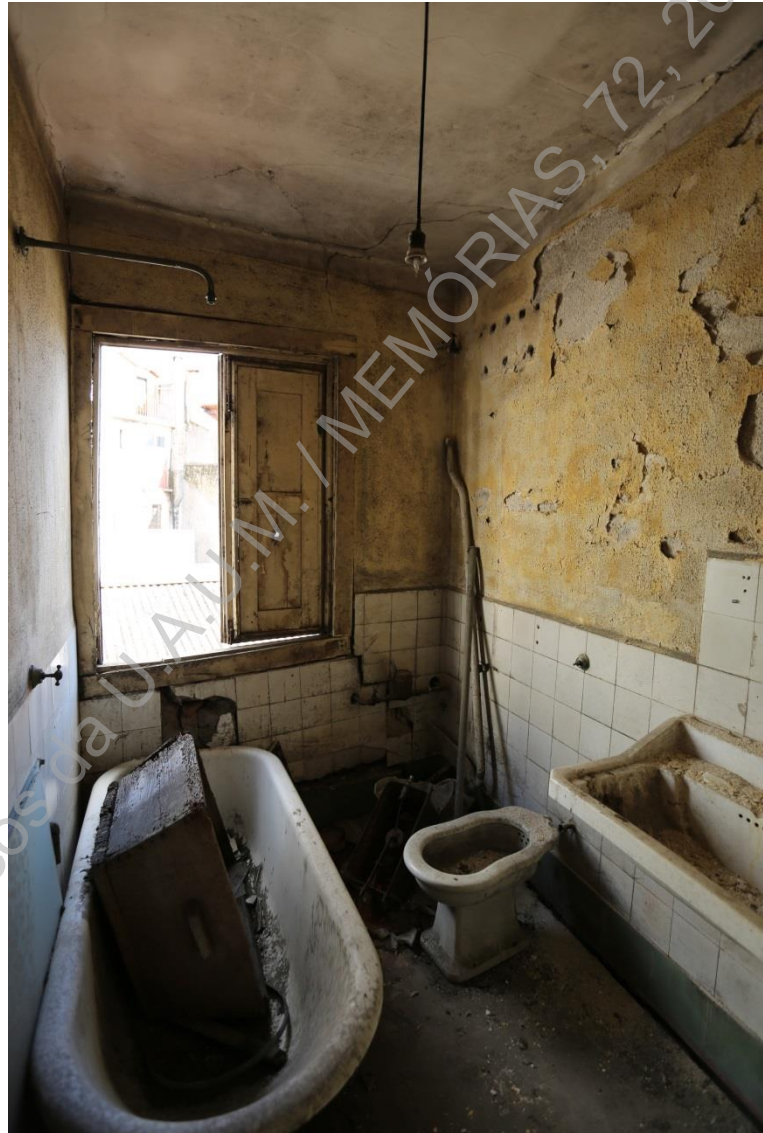
Foto 21 (Z45A7944) – Aspeto de quarto de banho no piso 3 (NO/SE).
