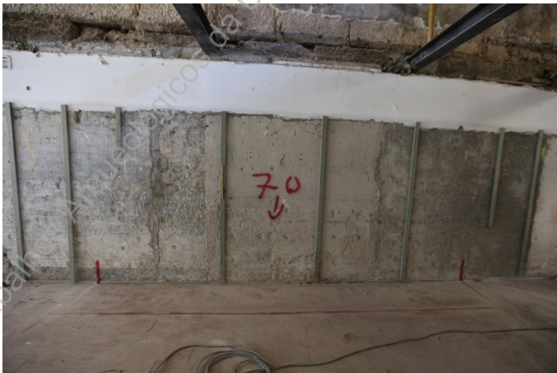
Foto 26 (IMG_1620) – Área de implantação da sapata 1 (S/N).
