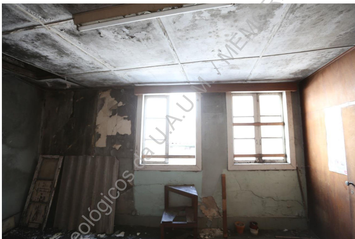
Foto 13 (Z45A7906) – Vista parcial de compartimento no piso 2 (E/O).
