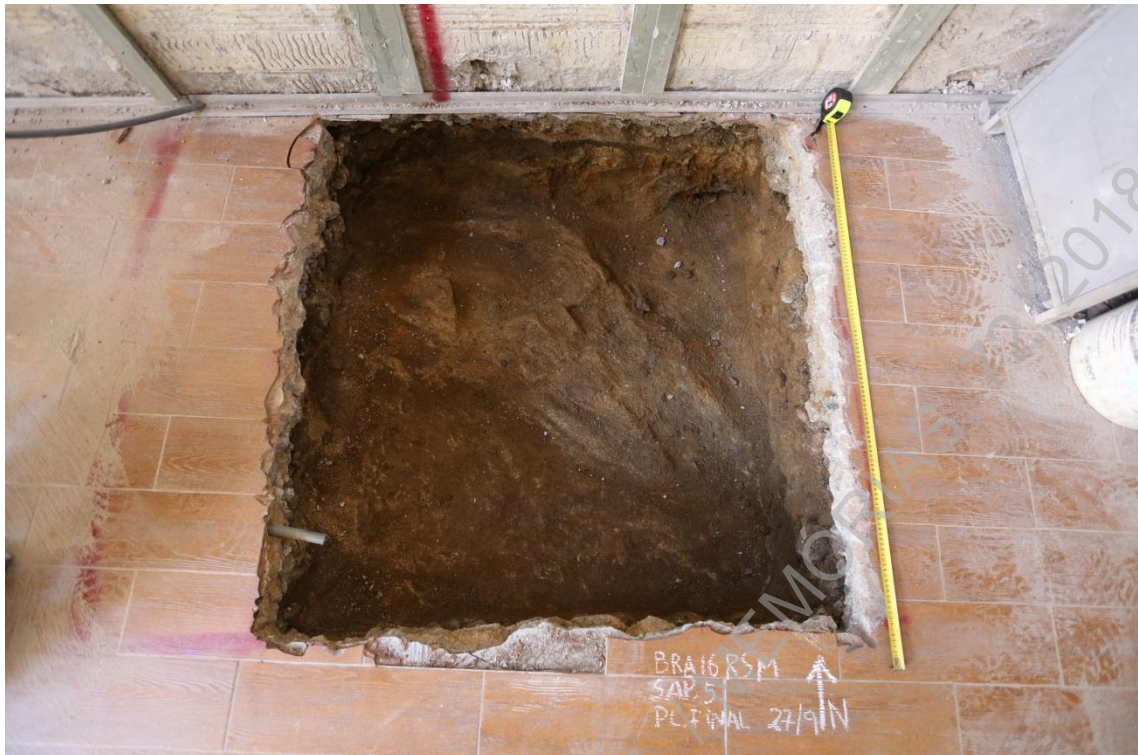
Foto 44 (IMG_1990) – Aspeto final da escavação da vala para a sapata 5 (S/N).
