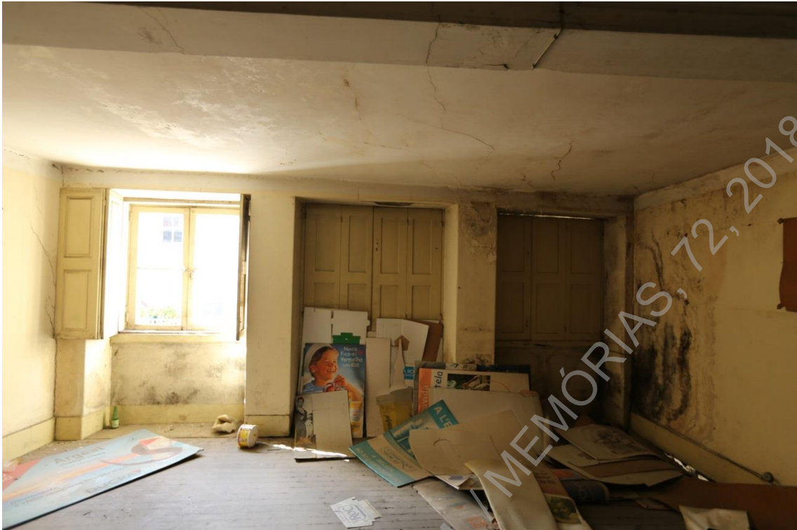
Foto 9 (Z45A7879) – Vista parcial de compartimento no piso 1 (E/O).
