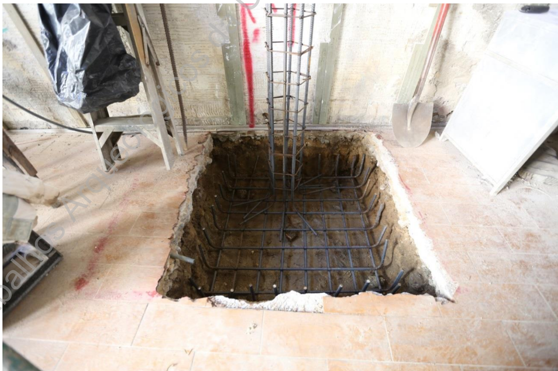
Foto 45 (IMG_2066) – Colocação do ferro para betonagem da sapata 5 (S/N).
