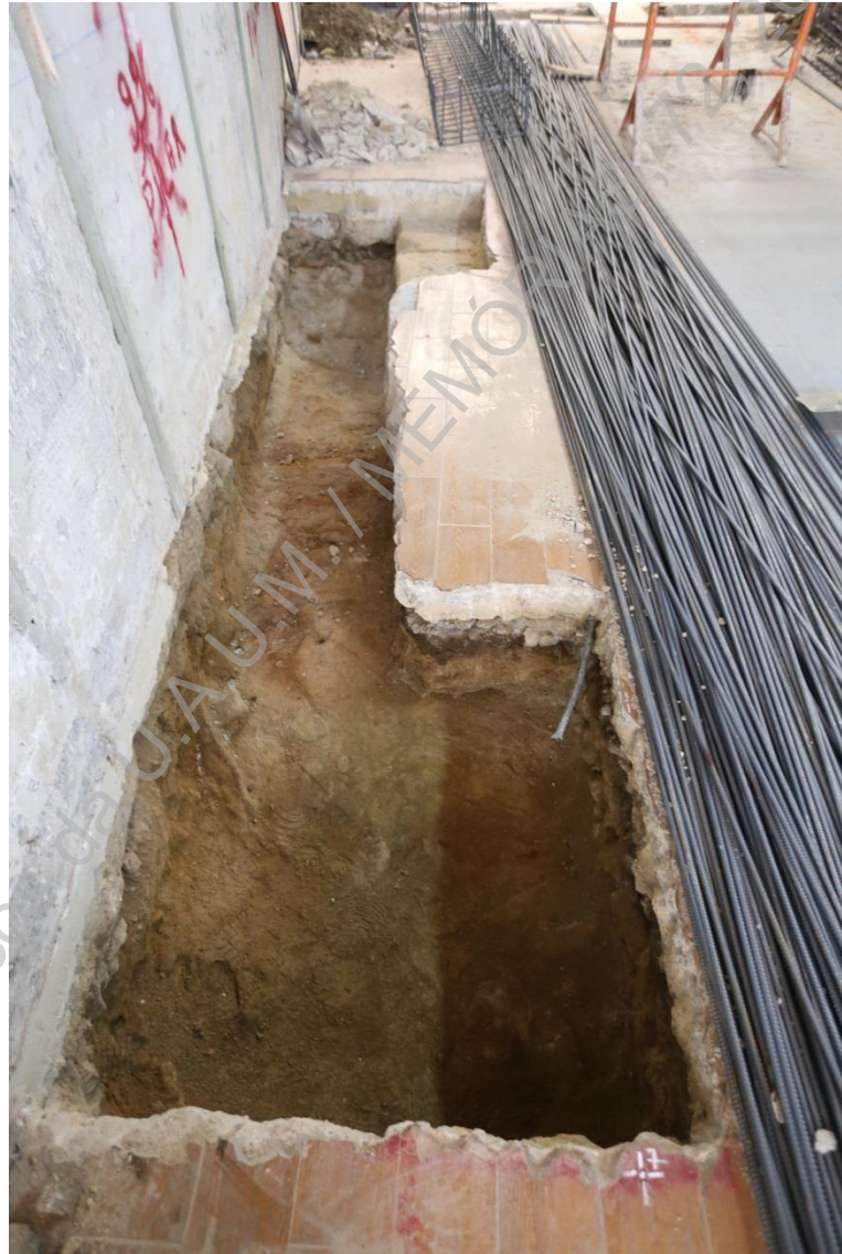
Foto 29 (IMG_2000) – Alargamento da vala para a sapata 1 - aspeto final (O/E).
