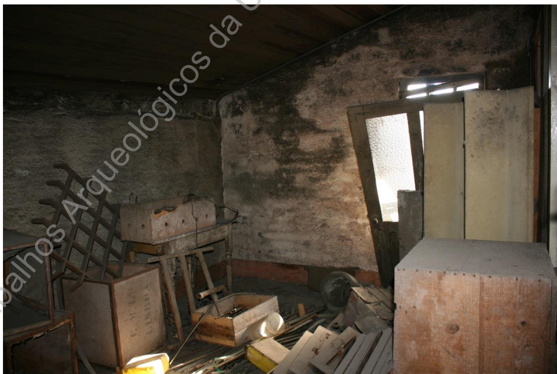
Foto 24 (IMG_2989) – Perspetiva do interior do sótão (NO/SE).
