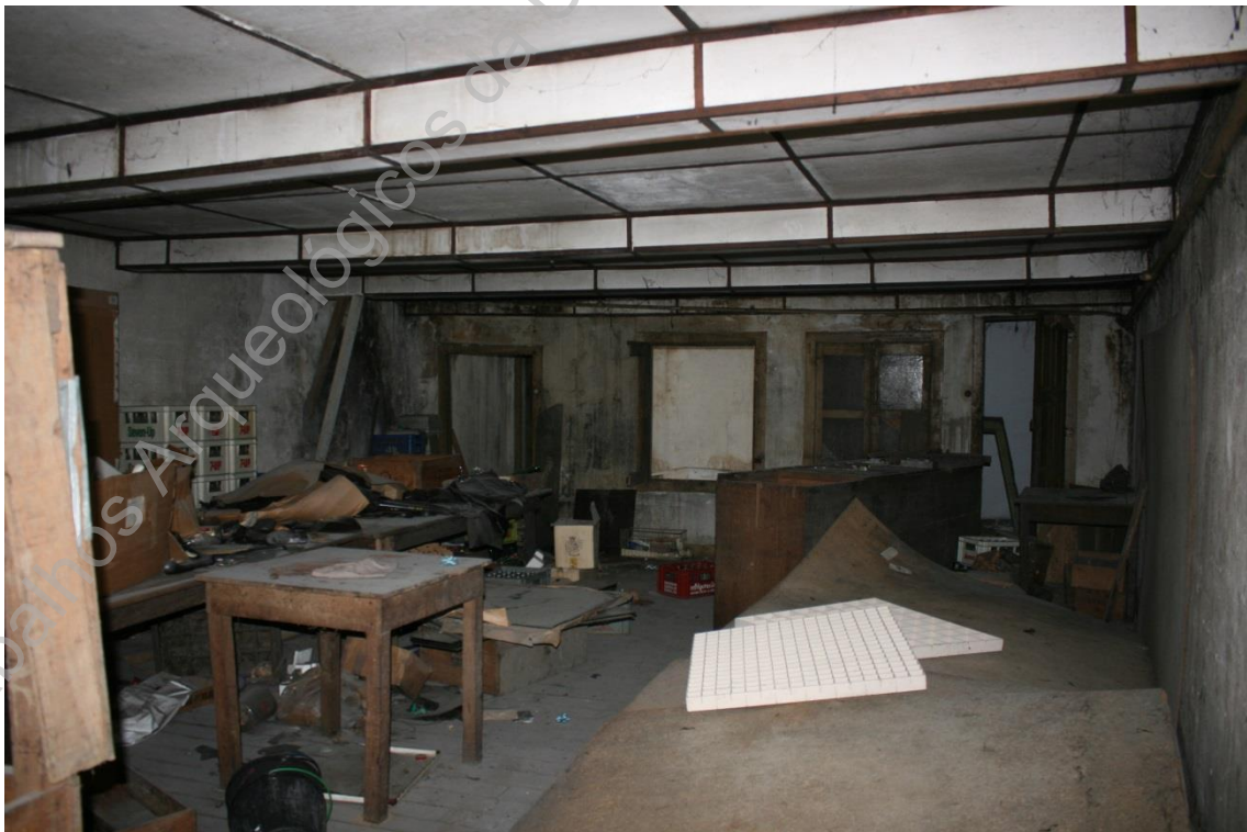
Foto 10 (IMG_2981) – Vista parcial de compartimento no piso 1 (O/E).
