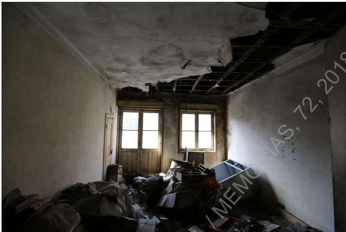
Foto 16 (Z45A7917) – Vista parcial de compartimento no piso 3 (E/O).
