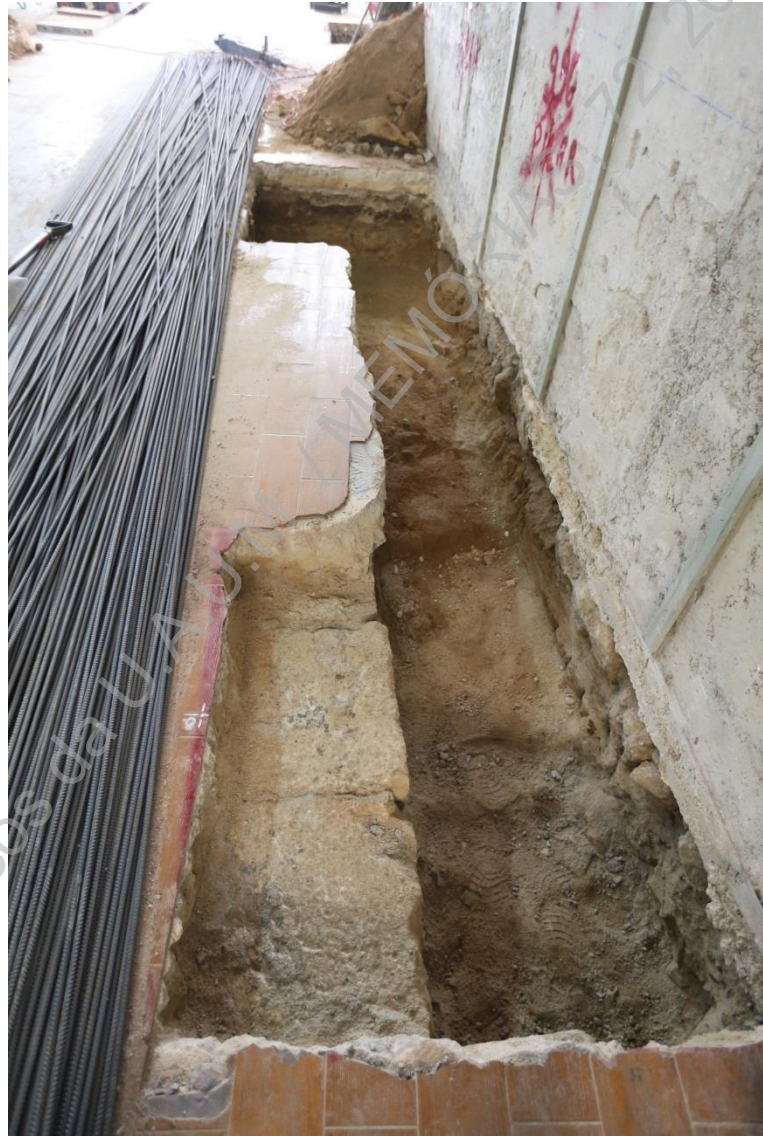
Foto 30 (IMG_2005) – Alargamento da vala para sapata 1 - aspeto final (E/O).
