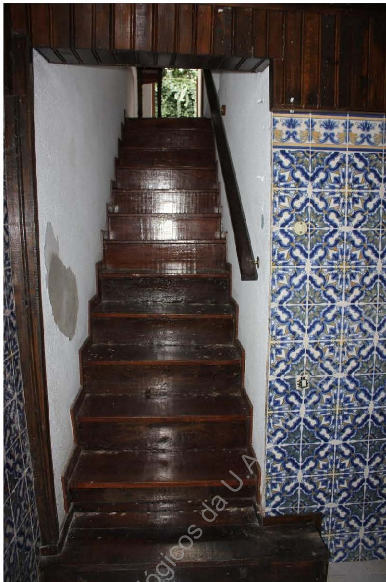
Foto 6. Lanço de escada para o primeiro piso e terraço exterior.
