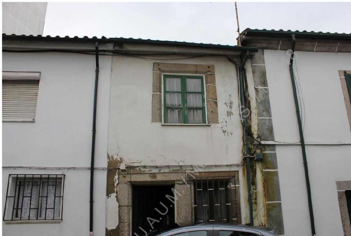
Foto 1. Fachada Norte do edifício nº34 da rua de São Sebastião.
