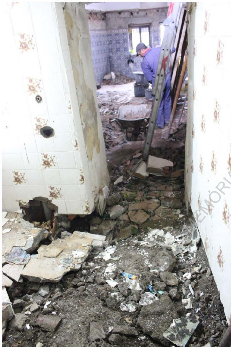
Foto 13. Trabalhos de limpeza após a demolição.
