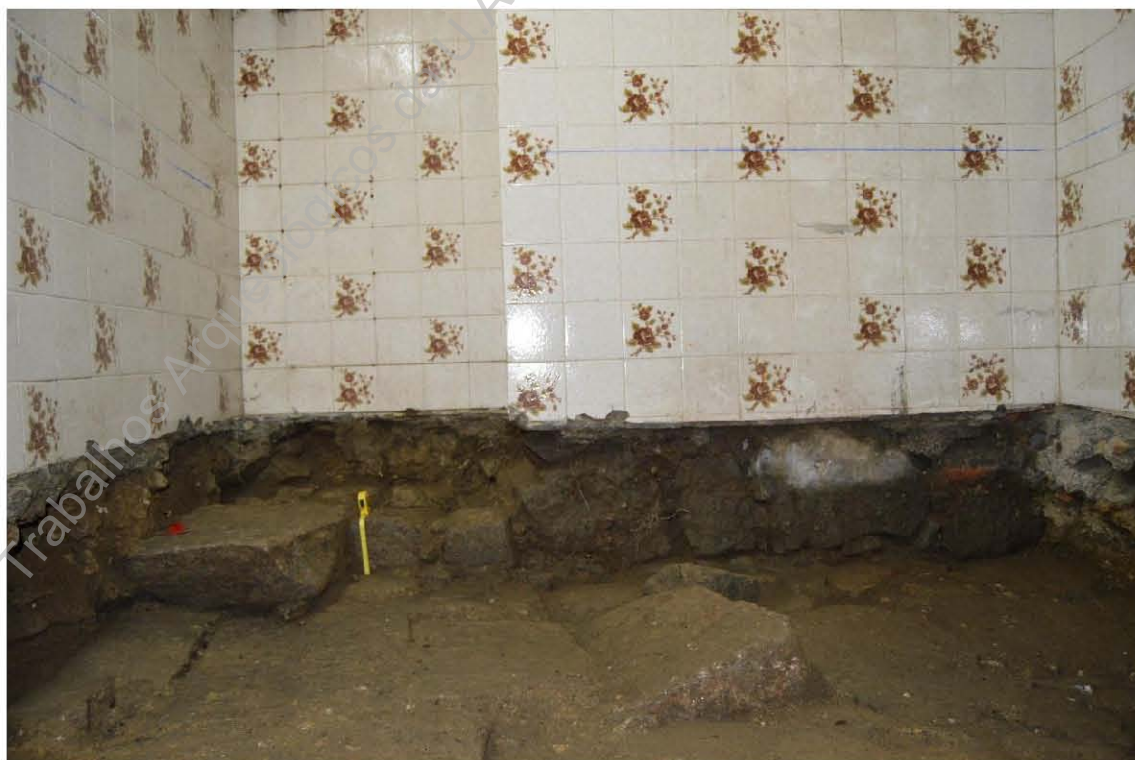
Foto 39. Compartimento 2, plano 2, alçado Norte do muro UE014 e alicerce UE033.
