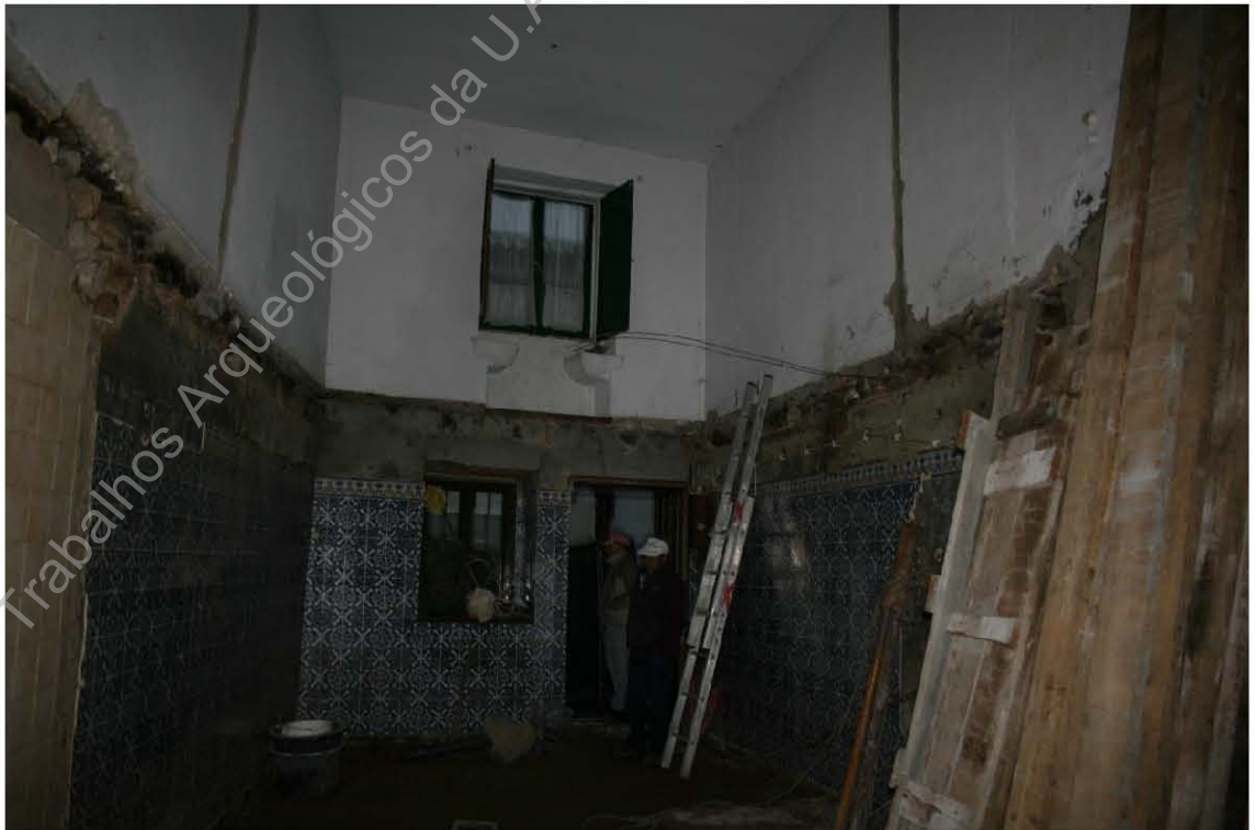
Foto 16. Aspeto geral após a demolição do piso superior e paredes divisórias.
