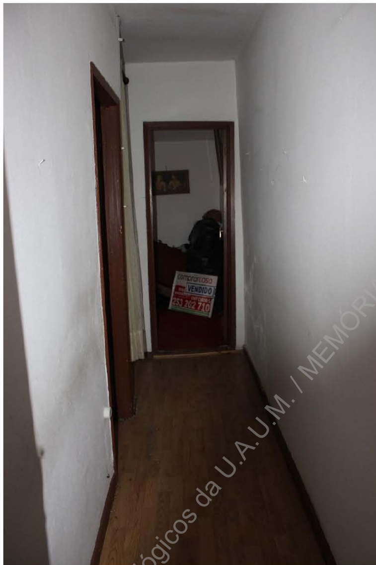
Foto 9. Corredor de acesso aos quartos primeiro piso.
