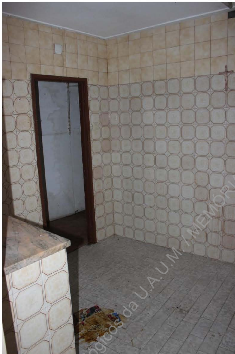
Foto 4. Casa de banho do rés-do-chão.
