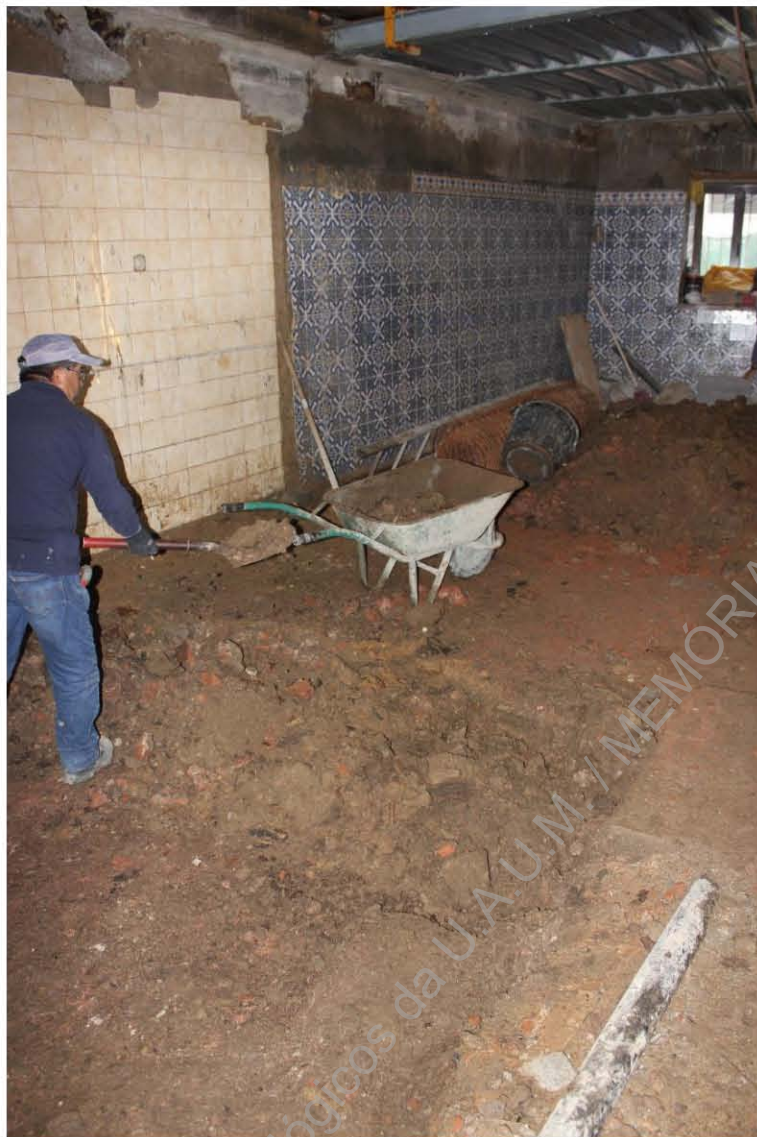
Foto 22. Compartimento 1, desaterro manual para ensoleiramento, vista de SE/NW.
