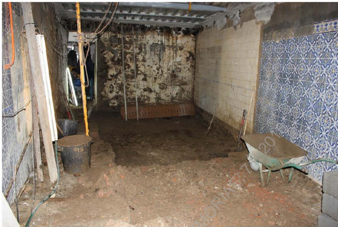
Foto 23. Compartimento 1, desaterro manual para ensoleiramento, vista N/S.
