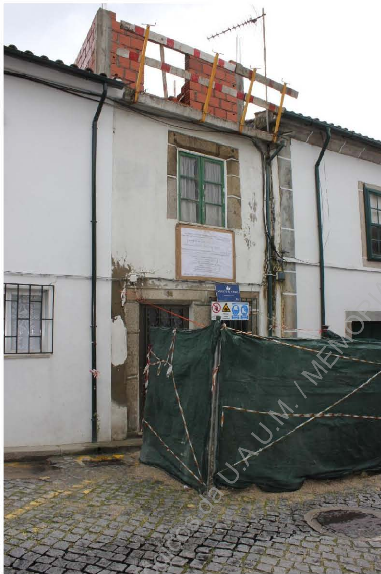
Foto 21. Aspeto geral da fachada no decorrer da obra.
