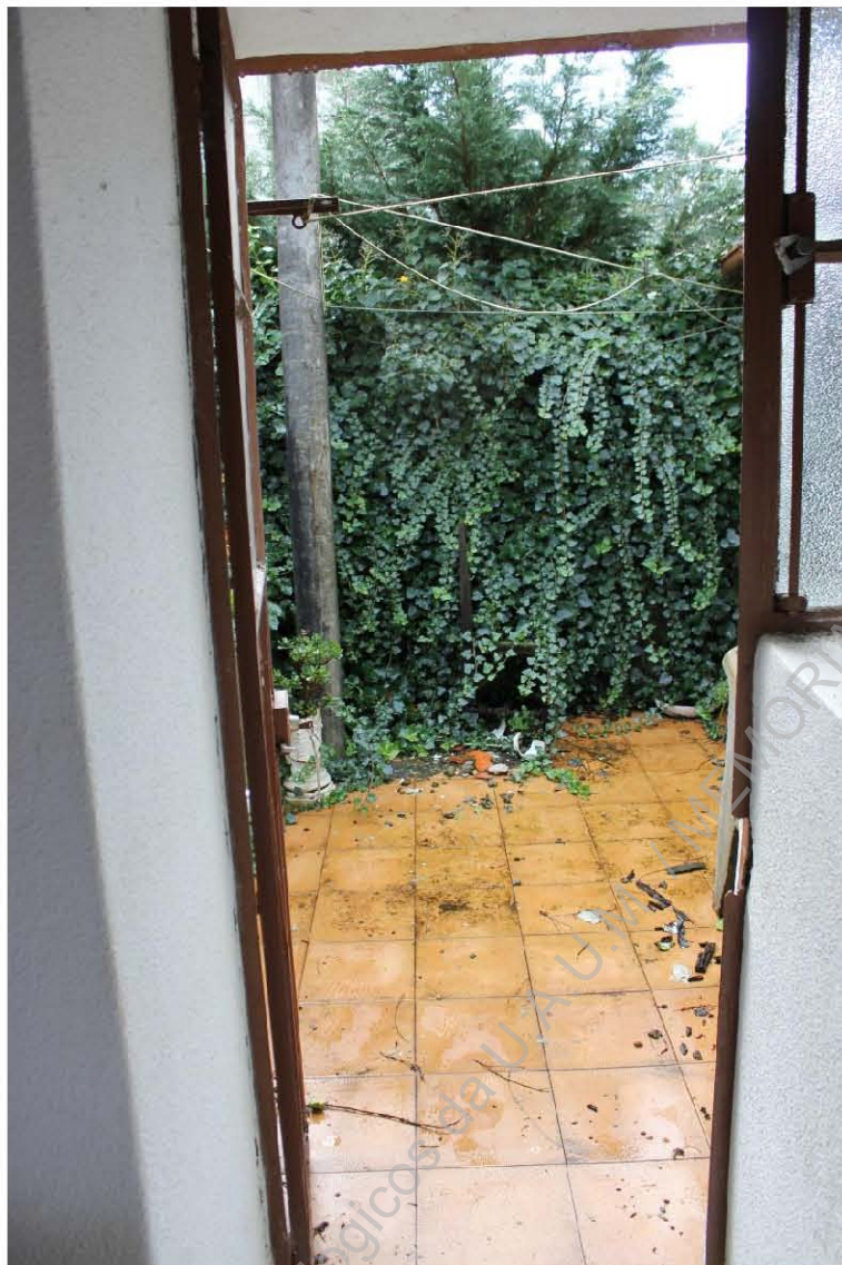
Foto 7. Terraço exterior, primeiro piso.
