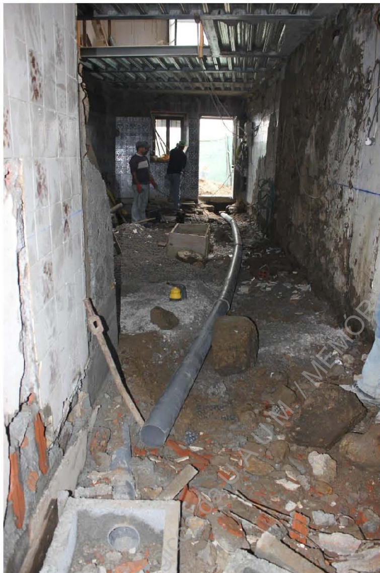
Foto 51. Colocação do sistema de escoamento de águas pluviais.
