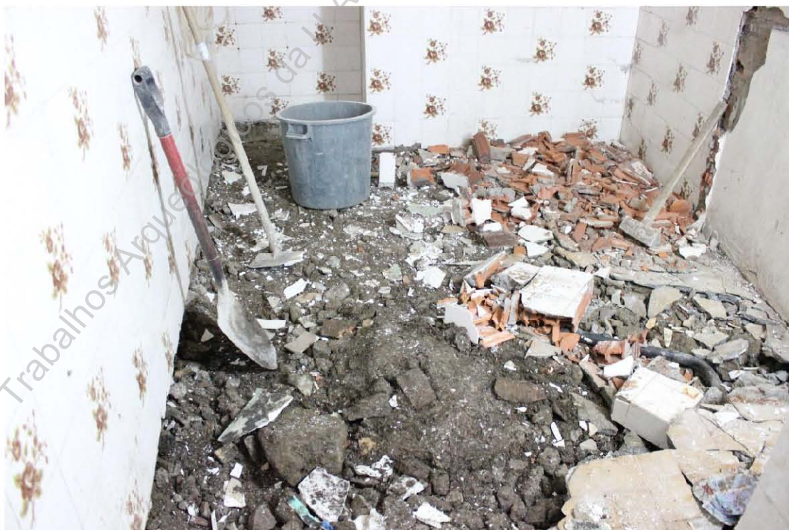
Foto 12. Demolições do primeiro piso.
