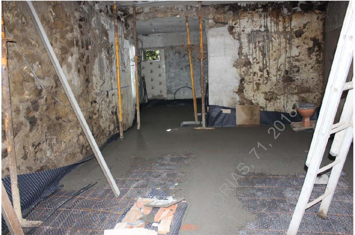
Foto 52. Colocação de pavimento acima dos vestígios encontrados.
