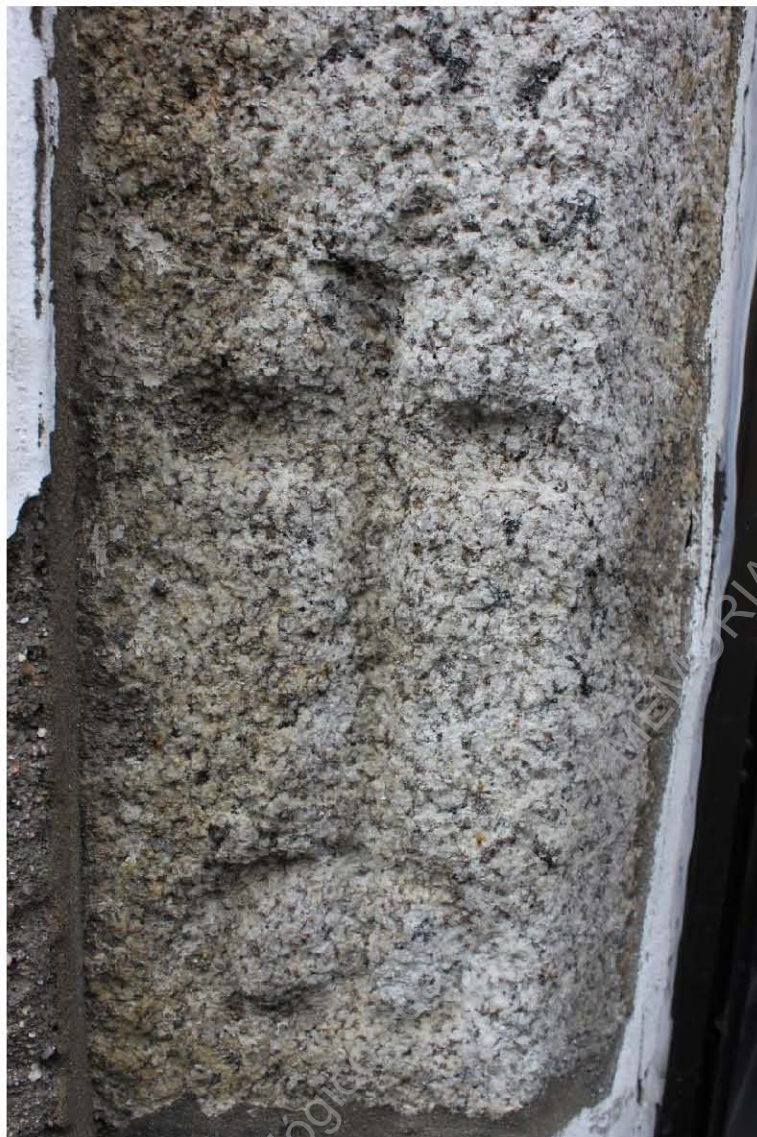
Foto 2. Pormenor da ombreira este da porta de acesso principal, com cruz gravada.
