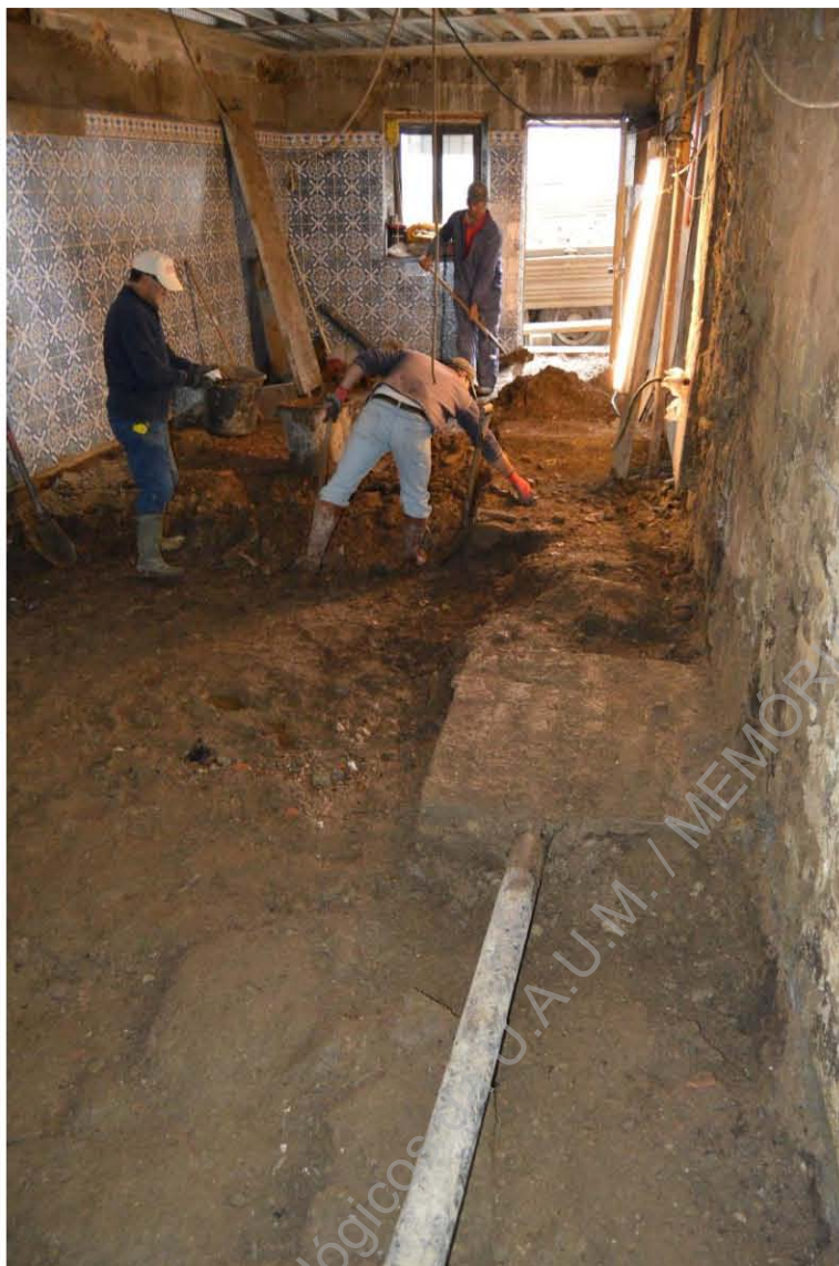
Foto 24. Compartimento 1, desaterro manual para ensoleiramento, vista S/N.
