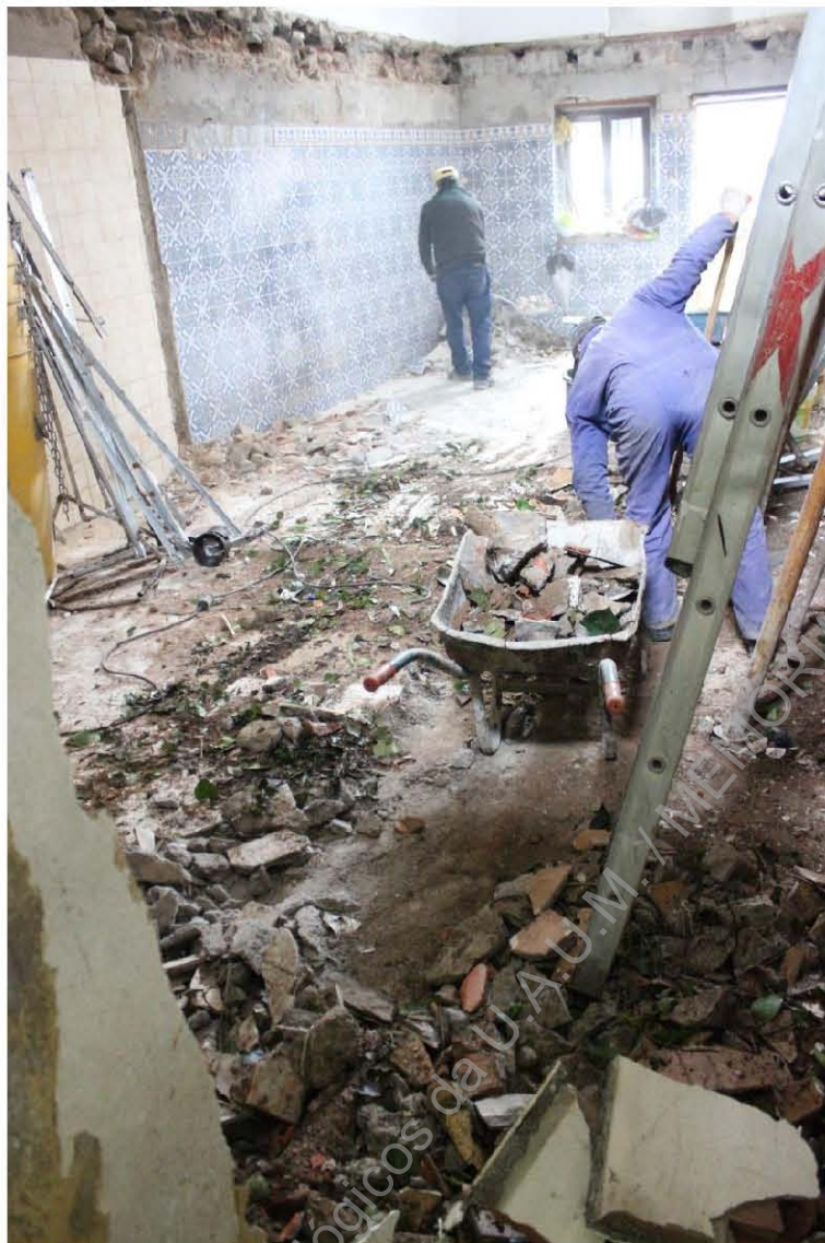
Foto 14. Trabalhos de limpeza após a demolição.
