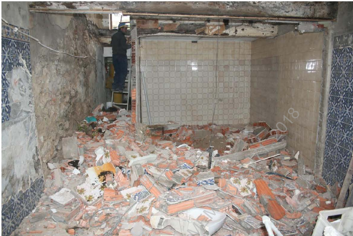
Foto 11. Demolições das paredes divisórias do primeiro piso.
