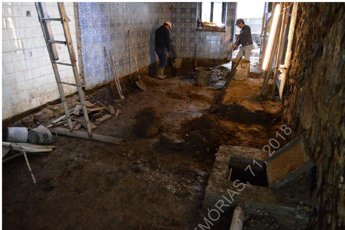
Foto 25. Compartimento 1, desaterro manual para ensoleiramento, vista S/Norte.
