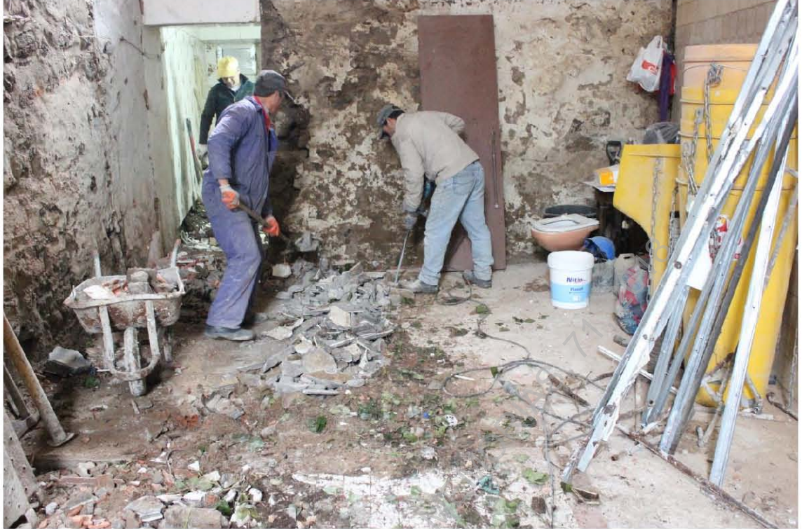
Foto 15. Remoção do pavimento do rés-do-chão.
