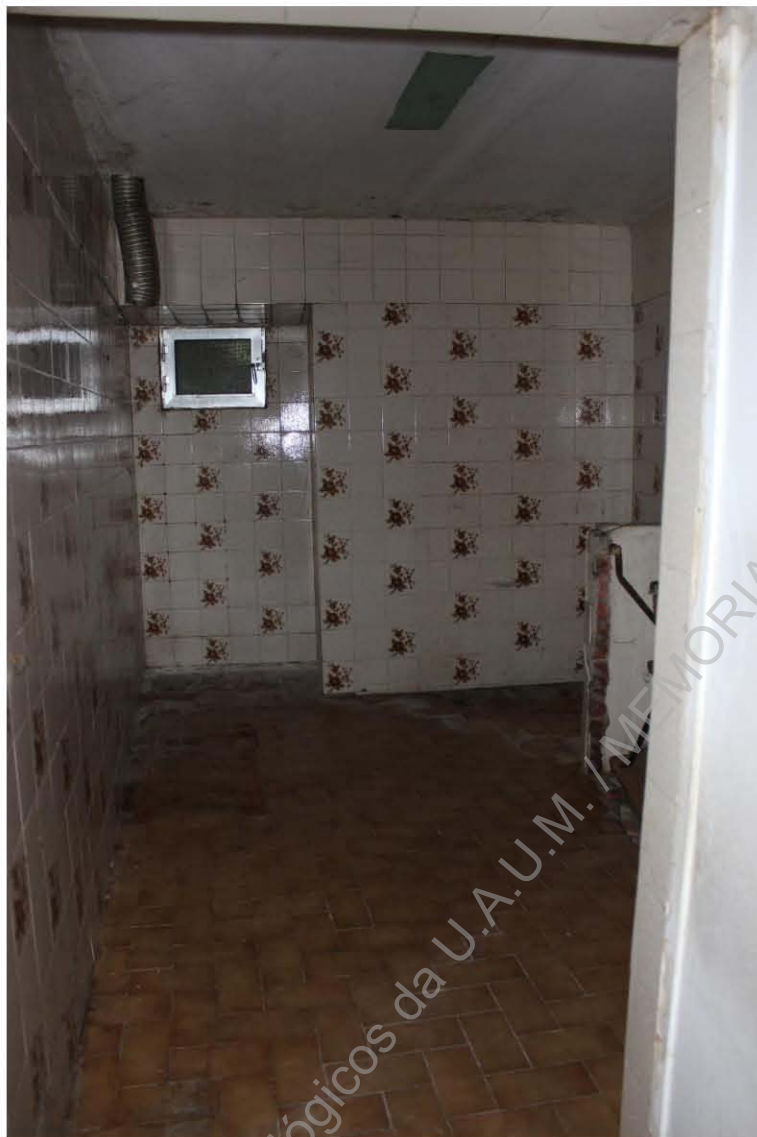
Foto 5. Cozinha no rés-do-chão.
