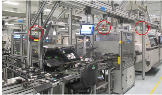
Figura 51 - Torres de iluminação em CBA
