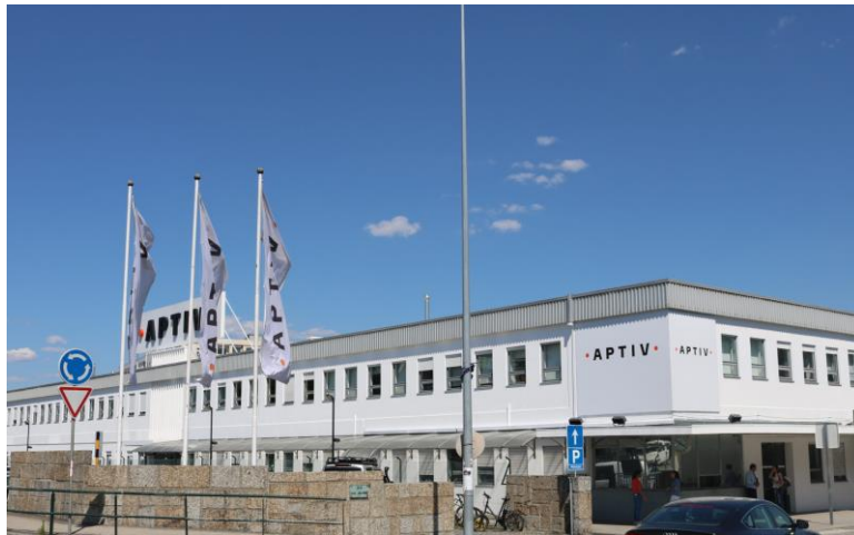
Figura 13 - Instalações da Aptiv em Braga
