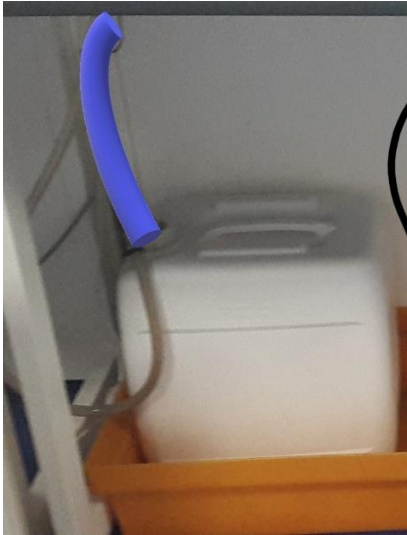
Figura 35 - Exterior da hotte da drenagem
