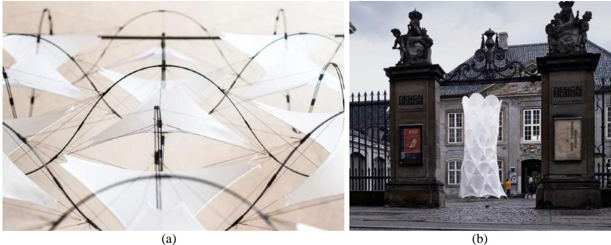
Figura 13: (a) Estrutura experimental 'Form Follows Tension'; (b) Torre experimental de integração entre membrana e estrutura ativa em flexão.
