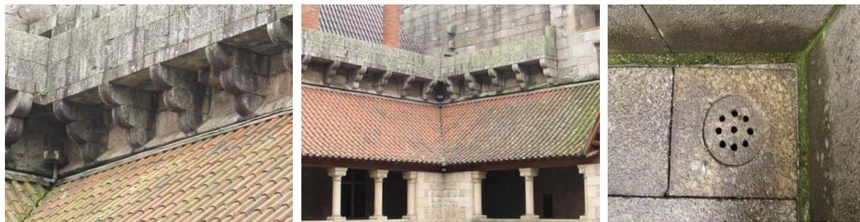
Figura 114: (a) Saída da água pluvial para o alpendre de uma água do claustro; (b) Queda de água para o pátio central; (c) Drenagem da água nos quatro cantos do pavimento do pátio central.
