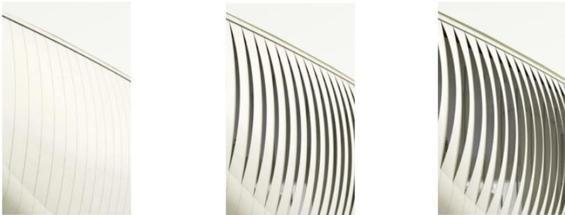
Figura 25: Imagens do processo de movimento da fachada através da flexão dos elementos.
