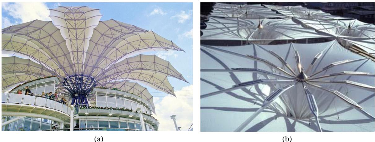
Figura 47: (a) Estrutura conversível em membrana do Pavilhão da Venezuela Expo 2000; (b) Estrutura metálica para mobilidade estrutural tipo Umbrella.
