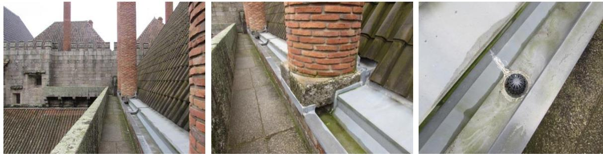
Figura 113: (a) Balcão junto a cobertura do primeiro pavimento; (b) Drenagem da água pluvial nos telhados; (c) Queda da água pluvial para o alpendre de uma água do claustro.
