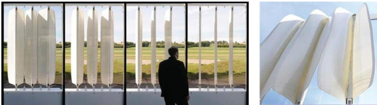
Figura 43: Exemplo de elemento arquitetônico de estrutura ativa em flexão feito em GFRP.
