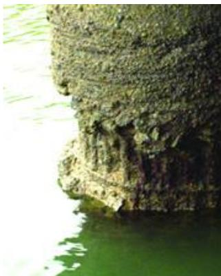
Figura 2.5 – Corrosão da armadura de estrutura inserida em ambiente marinho devido à ação de cloretos. Disponível em: <http://www.metacaulim.com.br/impermeabilizantes-metacaulim-hp-ultra.html> (acesso em 25/02/2016).
