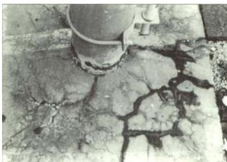
Figura 2.6 – Bloco de fundação deteriorado por ação de íons sulfatos.
