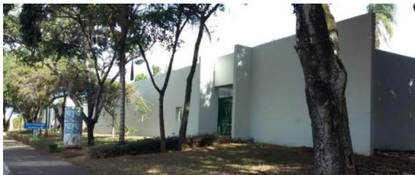
Figura 7. FE5, parcial da fachada NE. Foto: Christine Lucas, 2016.
