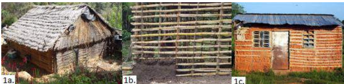
Figura 1. Técnica construtiva denominada “bahareque de bambu”. 1a. Bahareque apenas em bambu. 1b. Bahareque com vedação em argila. 1c. Bahaque com vedação em barro vermelho. Fonte: Yosoyxinka, 2016.
