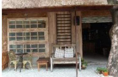
Figura 11: Reutilização de material na fachada da lanchonete
