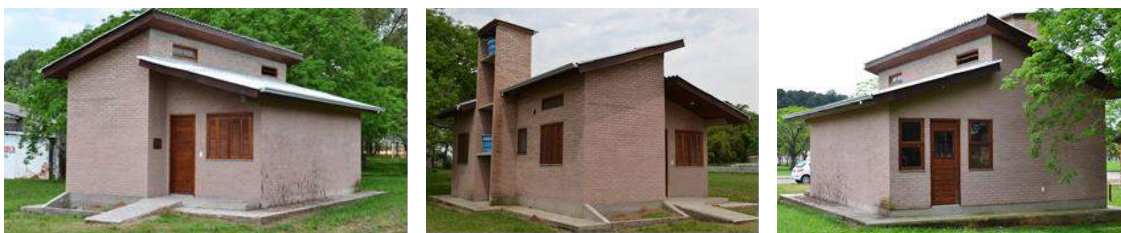
Figura 1. Fachadas da Casa Popular Eficiente. Fonte: autores, 2015
