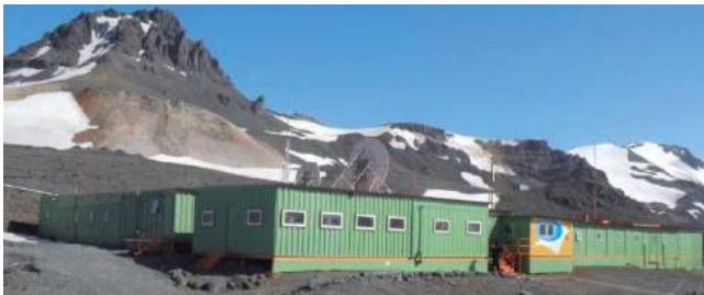
Figura 1. Vista externa frontal da EACF em janeiro de 2012.
