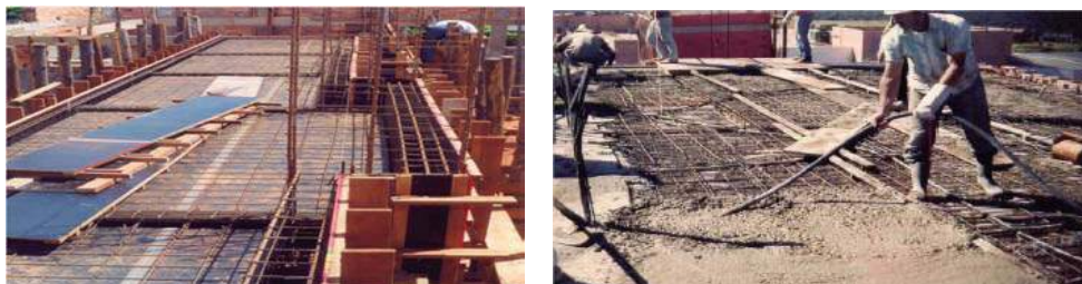
Figura 1. Preparação de laje maciça de betão, em construção (esquerda); betonagem de laje maciça (direita) (Fonte: o autor)
