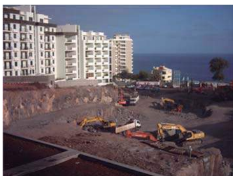
Figura 4.1 – Escavação onde foram utilizados explosivos e máquinas de escavação/demolição.
