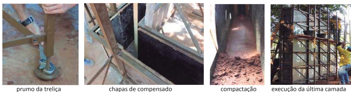
Figura 2. Formas metálicas treliçadas para produção de paredes de taipa.
