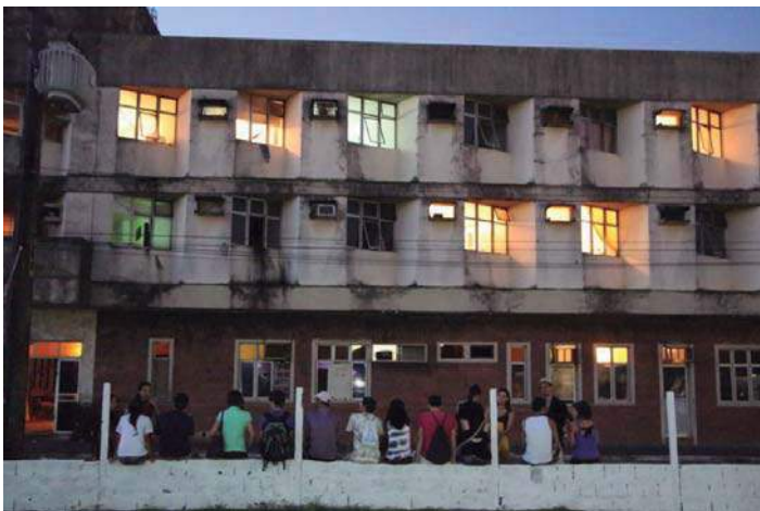
Figure 1. Fotografia externa do Edifício Tropicana. Acervo pessoal
