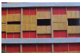
Detalhes das janelas do Edifício Louveira, RJ, com controle da insolação.
