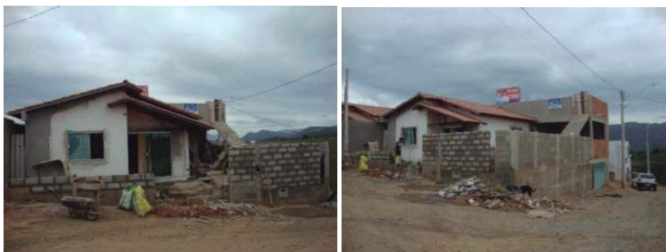
Figura 6. À esquerda, reformulação da fachada através da inserção de novas esquadrias e pintura. À direita, construção de novos cômodos, principalmente garagem.
