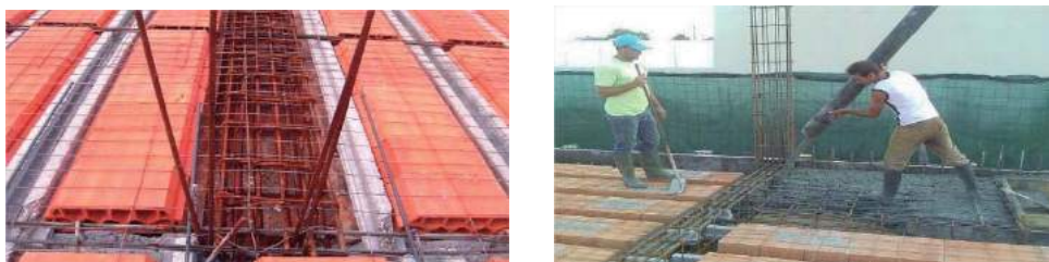
Figura 2 – Execução de laje aligeirada em construção (esquerda); betonagem de laje aligeirada (direita) (Fonte: o autor)
