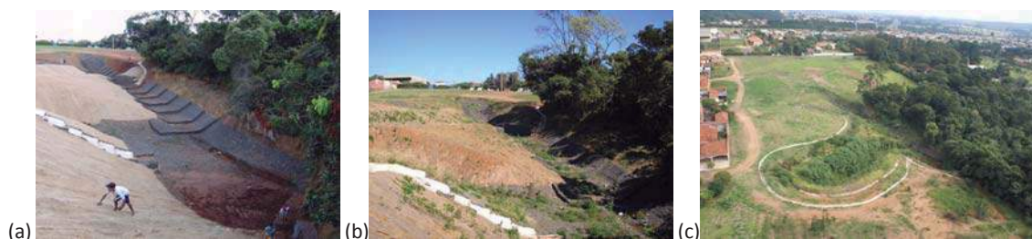
Figura2. (a) Estabilização das encostas e escadas para dissipar a energia das águas pluviais e evitar erosões na área verde existente à jusante (b) Renaturalização da nascente do córrego S. Rafael poucas semanas depois do final da obra (c) Vista aérea da renaturalização da nascente do S. Rafael, cerca de um ano após a obra
