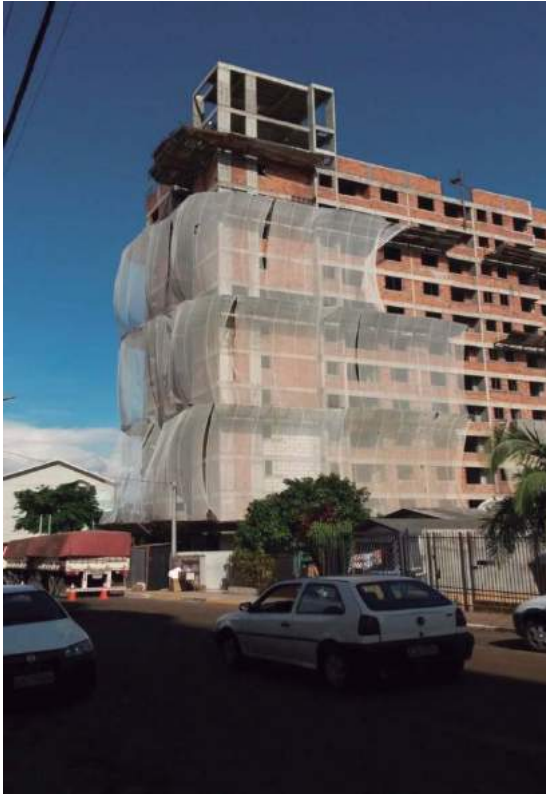
Figura 1: Construção Residencial Vertical onde foram realizadas as medições- Obra 1. Fonte: Leonardo Romitti.
