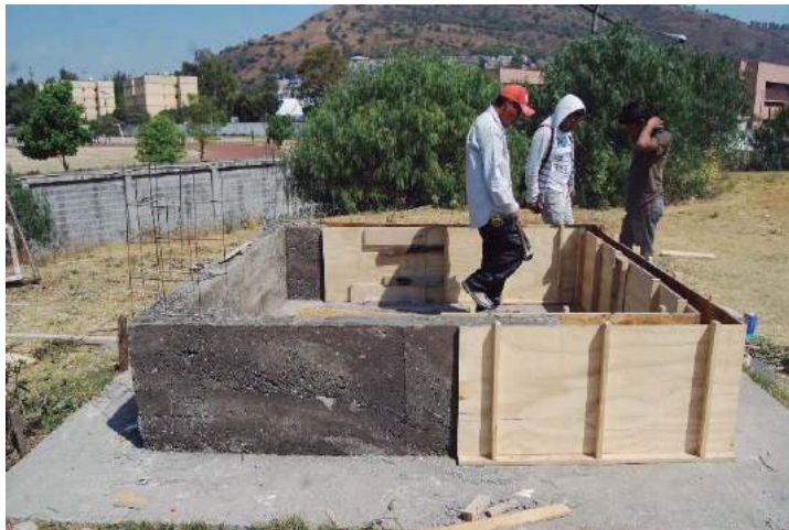
Figura 5. Armado del encofrado para cerrar la primera hilada. (Foto: L. Guerrero)
