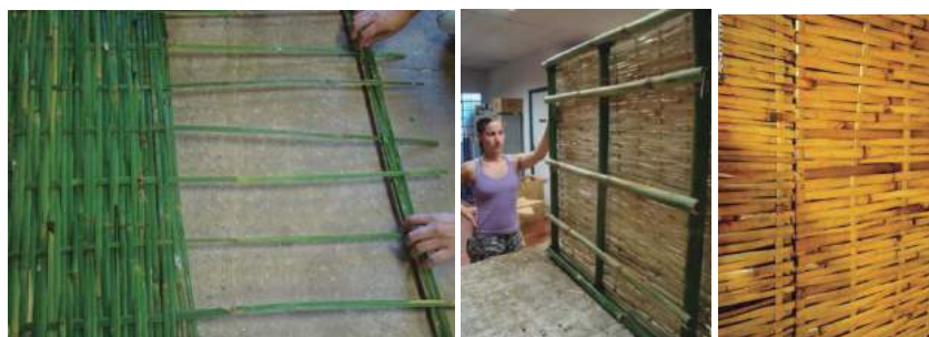
Figura 7. Etapas de trançado das ripas e montagem do painel in loco .
