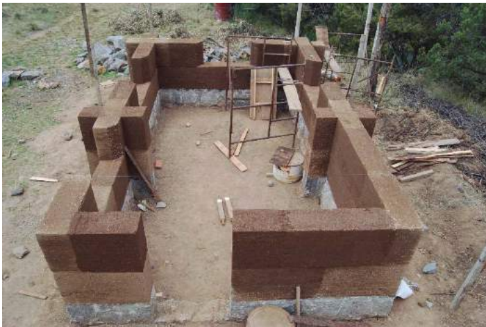
Figura 2. Construcción de una casa de TVC diseñada por la Arq. Alejandra Caballero. Tlaxcala, México. (Foto: L. Guerrero)
