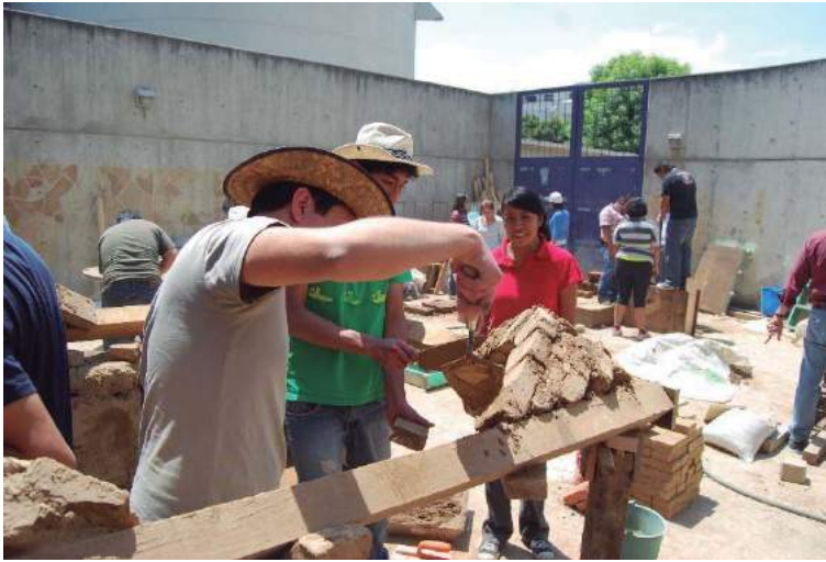
Figura 4. Estudiantes construyendo con tierra en el Laboratorio de Materiales de la UAM-X. (Foto: L. Guerrero)
