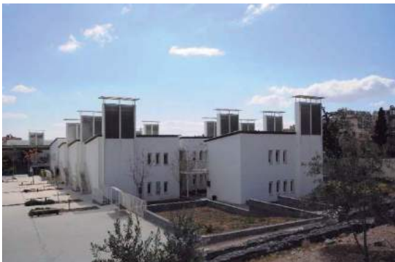
Figura 5. Vista geral dos blocos de sala de aula (AKDN 2013).
