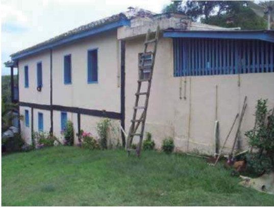
Figura 01. Casarão do Sr. Helio Gringa (Ibatiba) mostrando a cozinha aos fundos. Fonte: Silveira, 2012.
