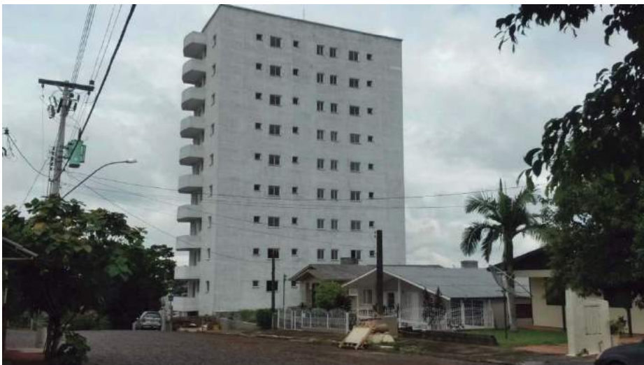
Figura 4: Construção Residencial Vertical onde foram realizadas as medições- Obra 2. Fonte: Leonardo Romitti.
