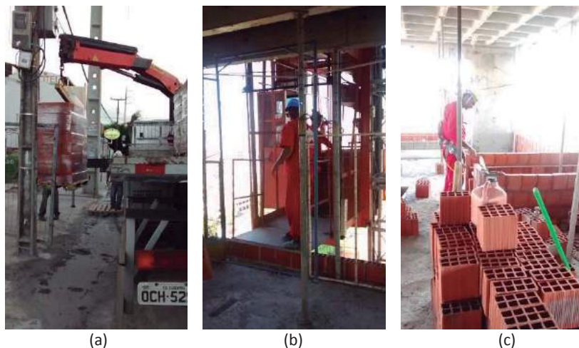
Figura 5. (a) Interferência de instalações. (b) Transporte dos blocos. (c) Pavimento sem paletes.
