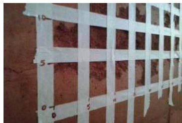
execução de grid com fita crepe
