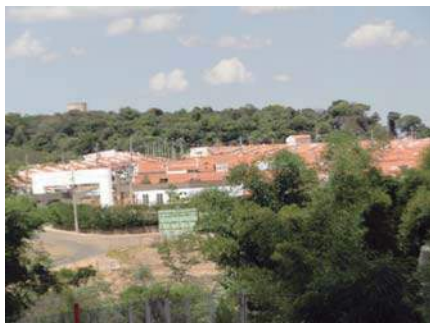
Figura 1. Cercamento de APPs em área urbana de São Carlos – SP.
