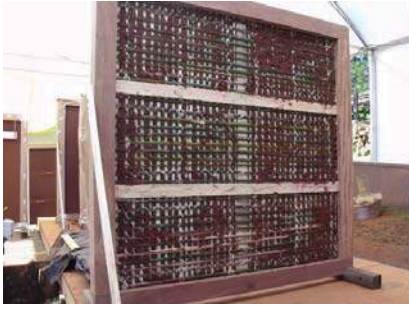
Figura 3. Barro que extravasa pelo verso da parede. Foto: Akemi Ino, 2013.
