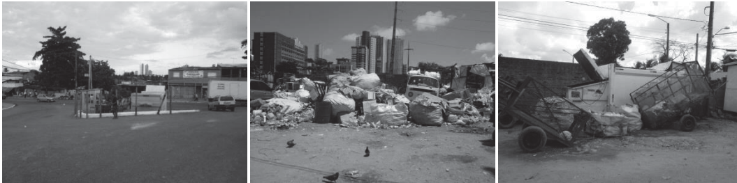
Figura 4. Vista do PRR Bomba do Hemetério. Figura 5. Deposição irregular de resíduos no terreno ao lado - PRR Boa Viagem. Figura 6. Vista do PRR Imbiribeira.
