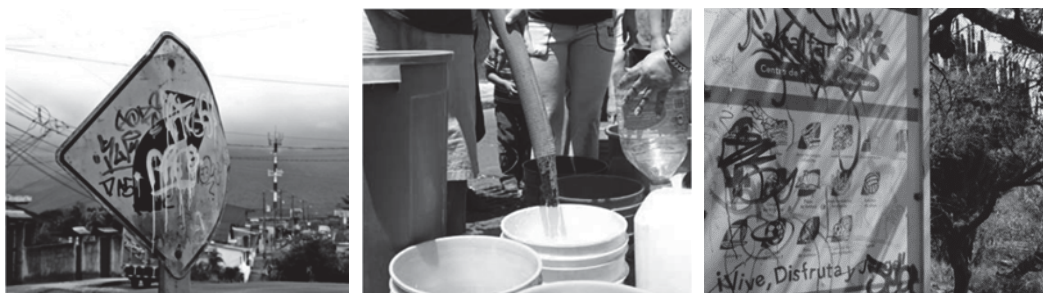
Figura 7. Descuido de infraestructura, mobiliario y equipamiento urbano.
