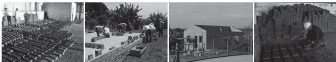
Figura 5. Processo construtivo das unidades habitacionais e de produção dos adobes. Fonte: Grupo HABIS (2004).
