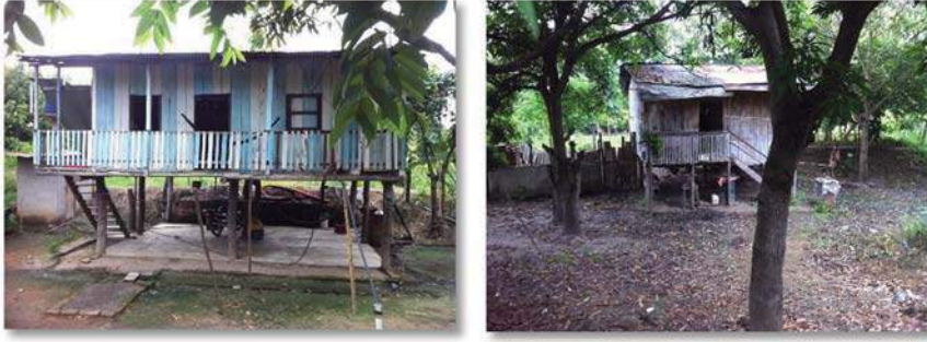
Figuras 7-8. Construcción elevada del suelo de distintas construcciones en zonas de clase pobre. [Fuente: Imágenes de R. Cordero].
