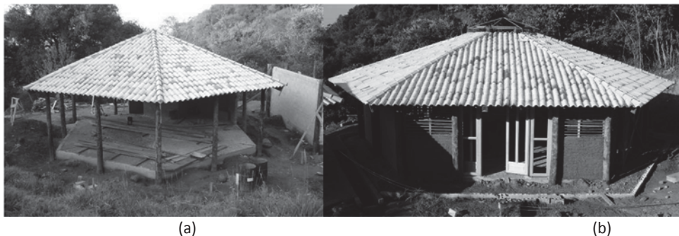
Figura 3. (a) Estrutura em eucalipto e cobertura em telha de barro da administração. (b) Painéis sendo barreados na sala de eventos
