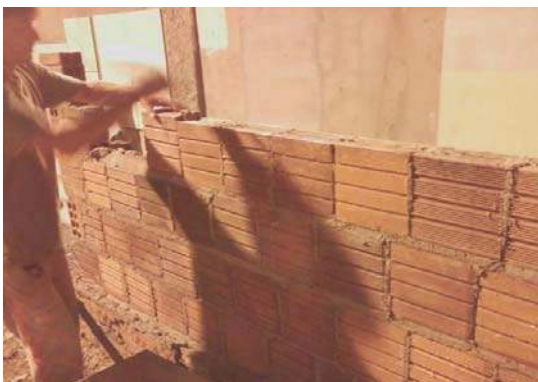
Figura 5 – parede de blocos 6 furos
