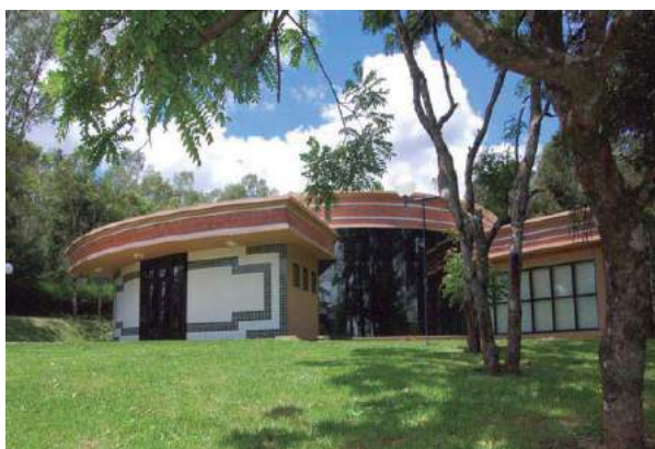
Figura 2 - Edifício MUZAR, fachada Sudoeste.
