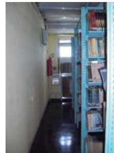
Figura 7: Validade da carga vencida. Fonte: Santos et al, 2014. Figura 8: Extintor localizado no 3º andar. Fonte: Santos et al, 2014. Figura 9: Extintor atrás das estantes. Fonte: Santos et al, 2014.
