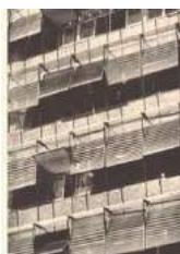
Detalhe da janela do Edifício Marquês de Herval, RJ, com controle para ventilação e insolação.
