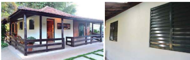
Figura 9. Estado atual externo da moradia
