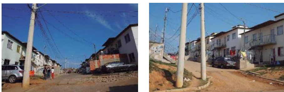
Figuras 1 e 2 – Vista interna do Condomínio (Fonte: os autores).
