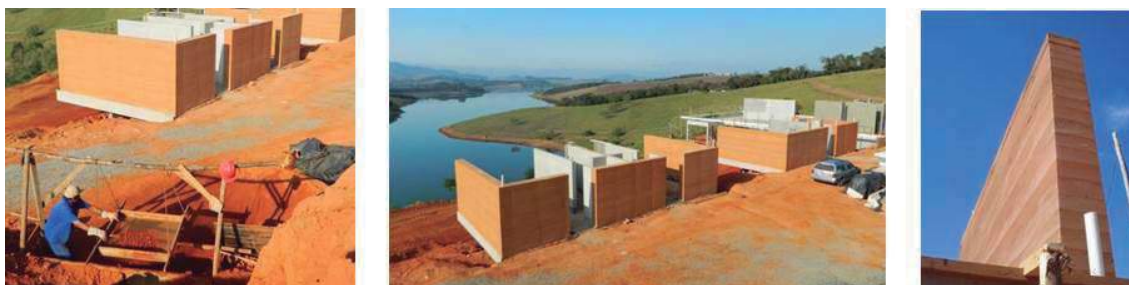
Figura 1. Processo de peneiramento e algumas paredes da Casa BJA. Figura 2. A relação entre a taipa de pilão e a paisagem natural exuberante em Joanópolis-SP e Figura 3. Detalhe de uma das paredes monolíticas e a tubulação de água independente da parede de taipa. Projeto: Escritório Bernardes & Jacobsen Arquitetura. Execução: TAIPAL Construções. Créditos: Hoffmann, Márcio Vieira. 2013
