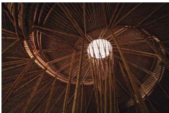
Figura 2. Estrutura de bambu no teto do edifício central (AKDN 2010).
