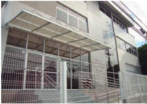
Figura 1: fachada principal da clínica (fonte acervo pessoal do autor)
