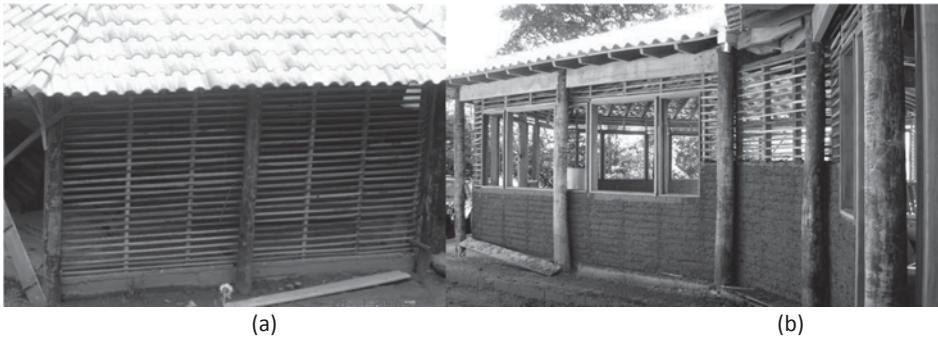
Figura 6. (a) Entramado das vedações. (b) Barreamento do restaurante
