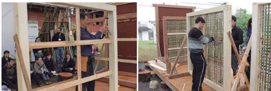
Figura 1. Kinzo Nakao executando a trama auxiliar. Foto: Seiji Yoneda, 2013. Figura 2. Amarração da malha de preenchimento. Foto: Seiji Yoneda, 2013.
