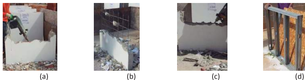
Figura 8 – Paredes em processo de desmontagem: (a) SVVIE CONV; (b) SVVIE CONC; (c) SVVIE ALES; (d) SVVIE STFR.
