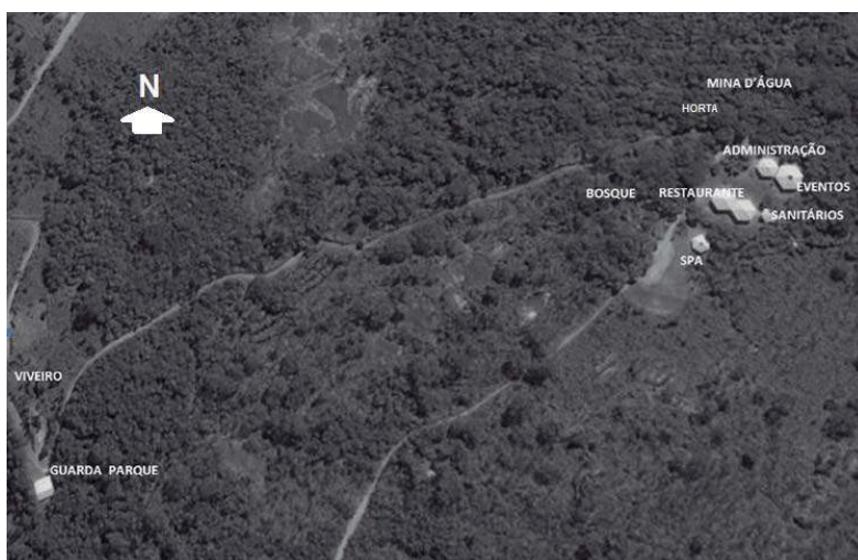
Figura 1. Vista geral das edificações (Google, 2007).
