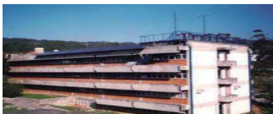
Módulos na cobertura na UFSC,1997.
