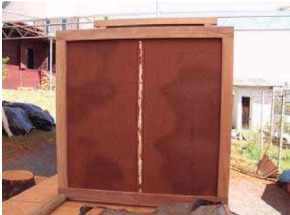
Figura 4. Primeira camada concluída, após secagem parcial e retração da argila. Foto: Akemi Ino, 2013.
