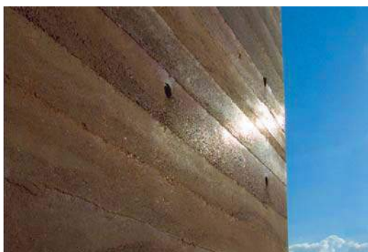
Figura 1: Parede construída com a técnica de taipa de pilão numa casa em São Paulo. Suas camadas simulam os horizontes do solo, formados pelo intemperismo secular.
