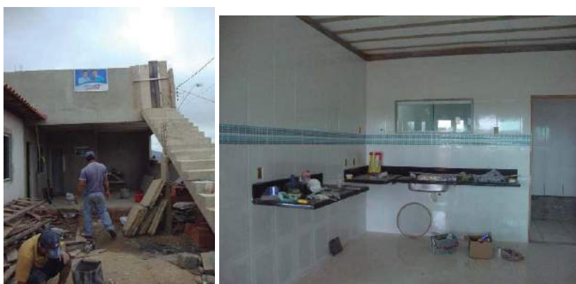
Figura 7. À esquerda, exemplo de expansão vertical para construção de área de lazer. À direita, modificação nas instalações hidrossanitárias, louças e metais do banheiro e cozinha utilizando novos materiais de acabamento.
