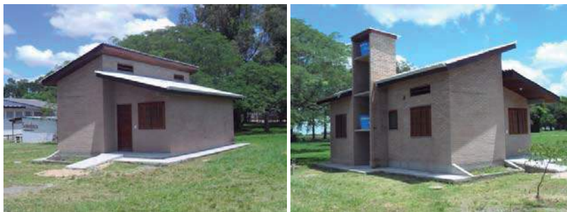
Figura 1 – Fachada Norte e Oeste. (Fonte: Vaghetti et al.,2013). Figura 2 - Fachada Norte e Leste. (Fonte: Vaghetti et al.,2013).
