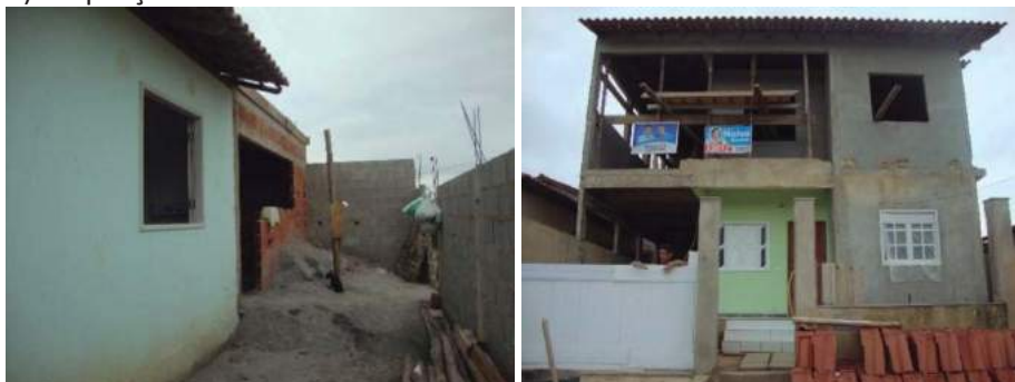
Figura 5. À esquerda, obras em andamento para a ampliação na cozinha e na área de serviço. À direita, crescimento vertical da unidade.
