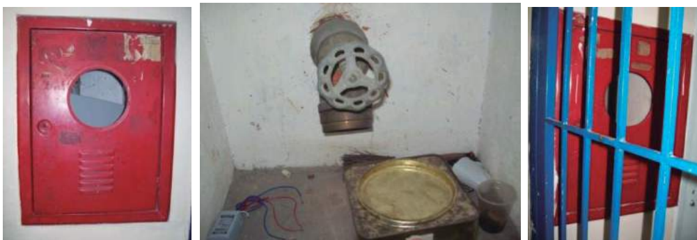
Figura 10: Caixa de hidrante - térreo: Madeira no Interior. Fonte: Santos et al, 2014. Figura 11: Interior do hidrante no 5º andar. Fonte: Santos et al, 2014. Figura 12: Hidrante trancado. Fonte: Santos et al, 2014.
