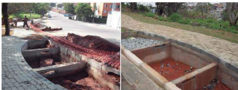
Figura 5. Fotos da obra. (PMSP/DEPAVE, 2012).
