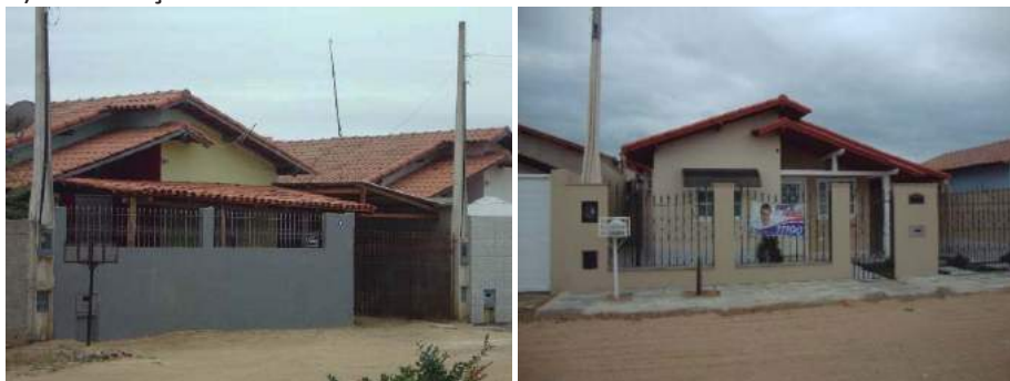
Figura 4. À esquerda, construção de muro e inserção de gradil não previsto no projeto e à direita, troca de cores e revestimento.
