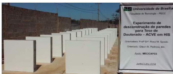
Figura 6 – Paredes construídas segundo os SVVIEs pesquisados
