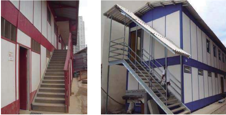
Figure 2 e 3. Instalação provisória – Fase 2: madeira (esquerda) e madeira com estrutura em aço (direita).
