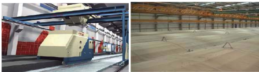
Figura 3. Caçamba alimentando extrusora (esquerda); cura a vapor (direita) (Fonte: Elematic, 2007; Catoia, 2011)
