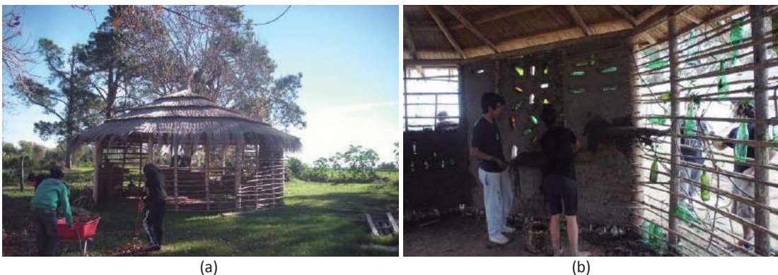
Figura 4. (a) Durante la construcción (González-Lazzarini) (b) En plana tarea (González-Lazzarini)
