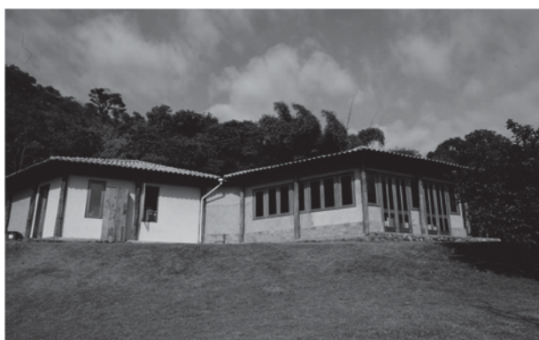
Figura 5. Restaurante executado em taipa de mão (à direita) e área da cozinha, executada em bloco de concreto (à esquerda).
