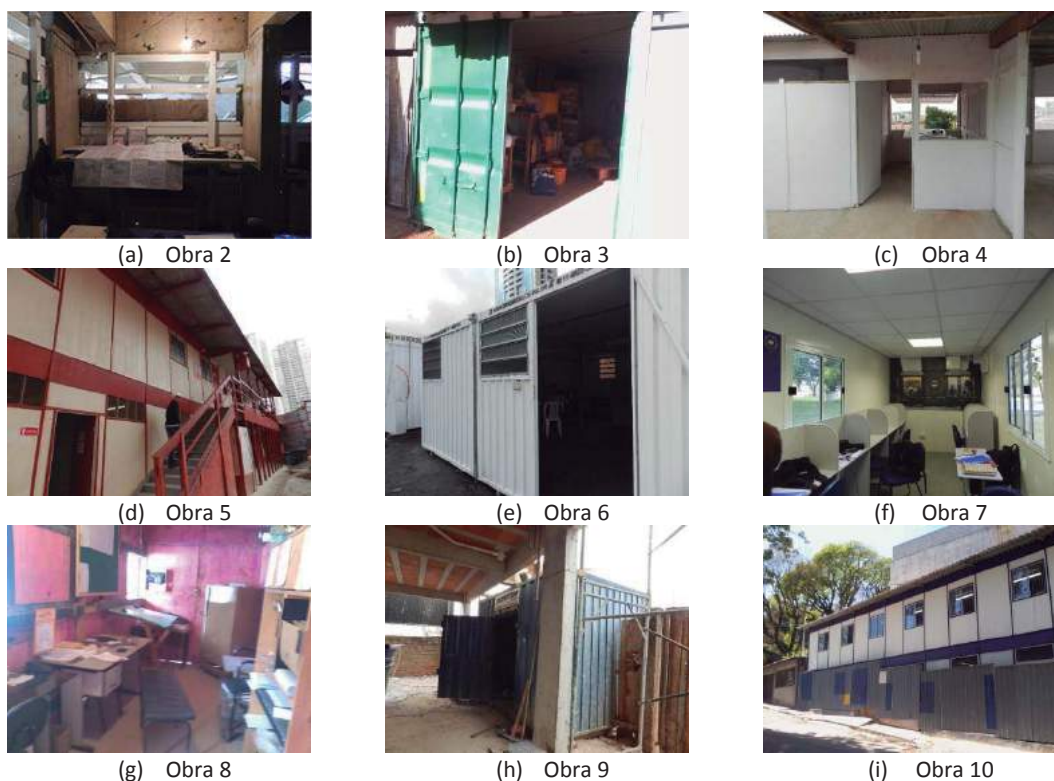
Figura 1. Vista geral das instalações provisórias para escritórios nos canteiros de obra pesquisados.
