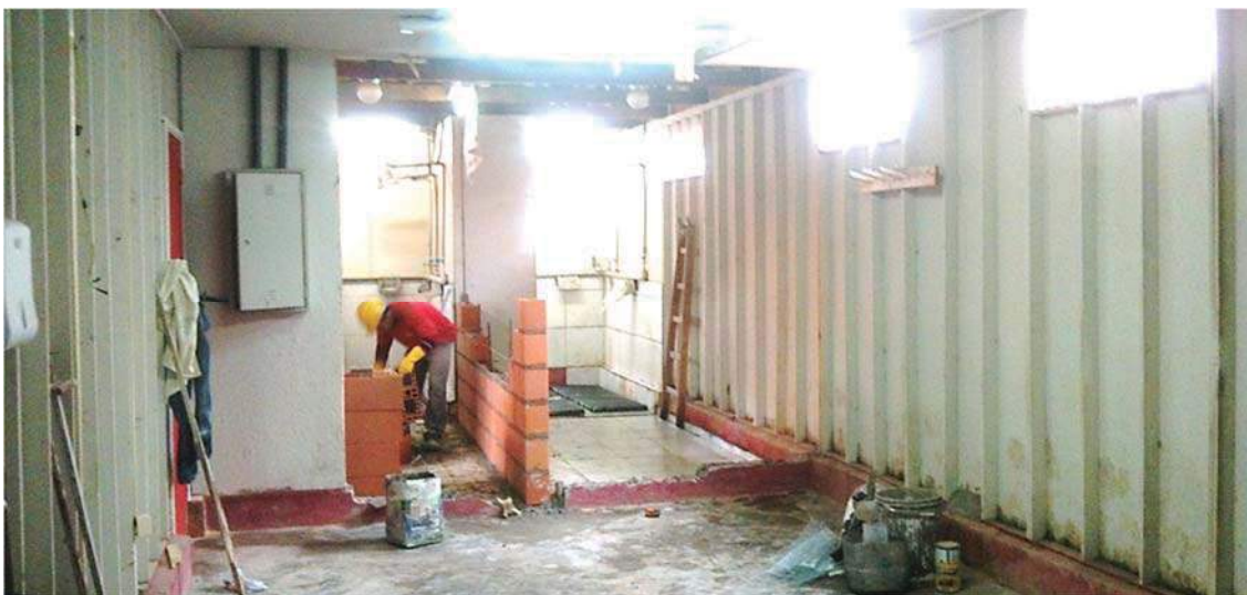
Figure 4. Obra para ampliação de banheiros em uma instalação provisória em madeira.
