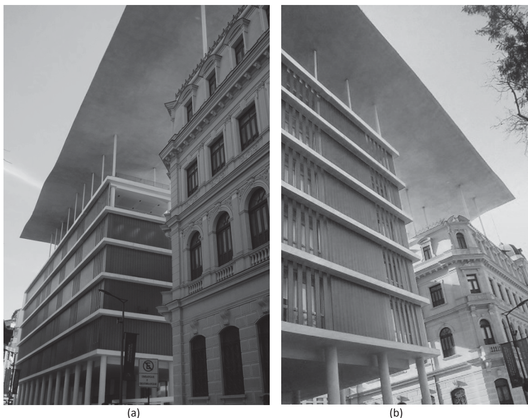
Figura 1. (a) MAR – Retrofit de três edificações existentes (b) Detalhe da cobertura do conjunto
