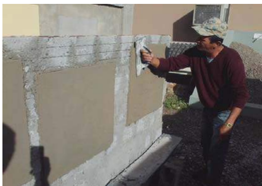
Figura 6 – parede com as argamassas aplicadas
