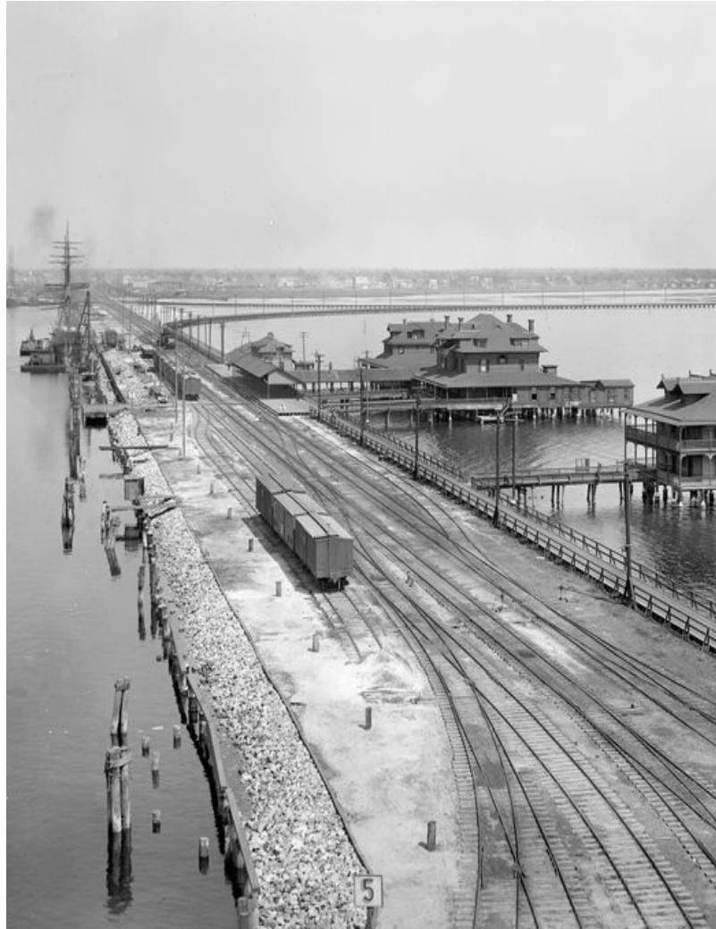
Imagem 73 - Vias sobre Enrocamento
