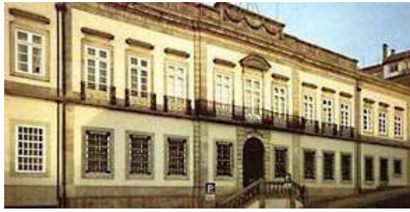
Figura 1.1. Edifício do Instituto dos Vinhos do Douro e do Porto, I.P., no Porto.
