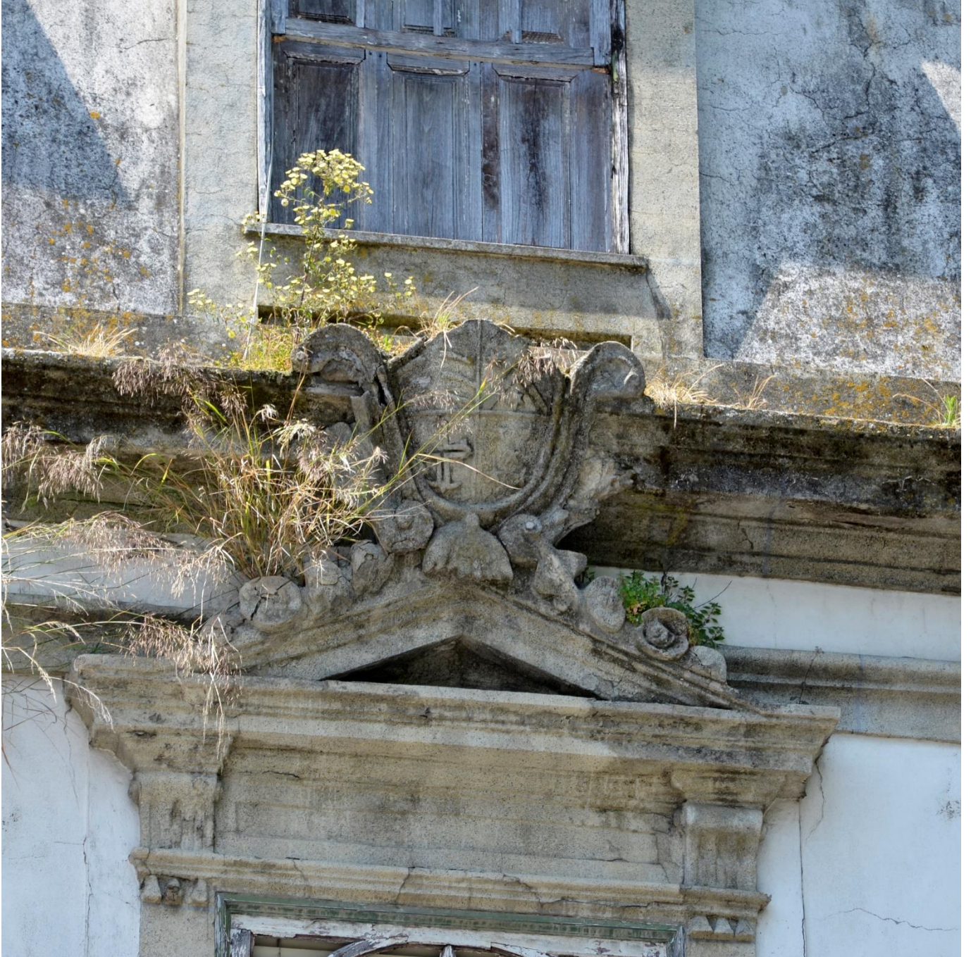
Ilustração XV | Pormenor da fachada Sul
