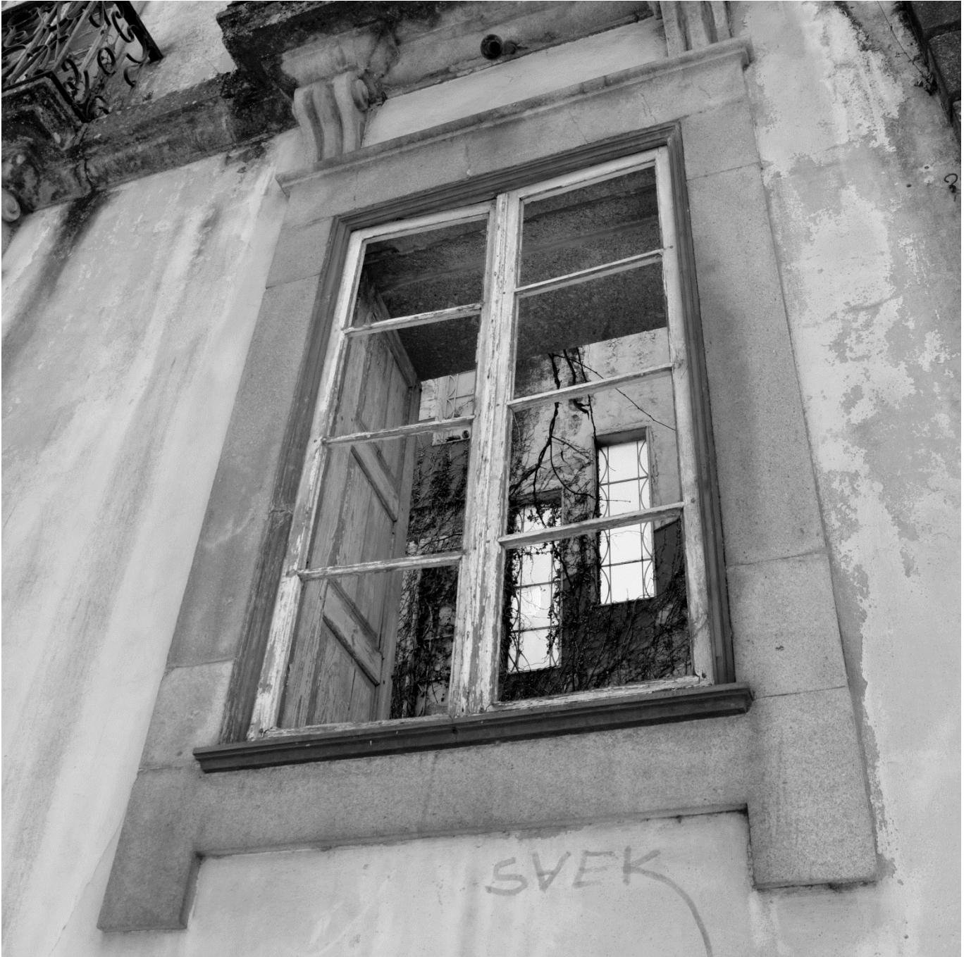
Ilustração II | Pormenor da fachada Norte
