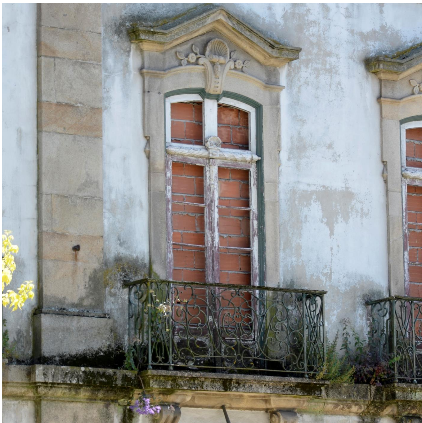
Ilustração XXVIII | Pormenor do vão da fachada Norte
