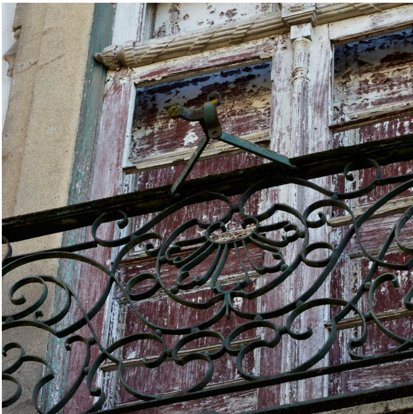
Ilustração XXIX | Guardas metálicas da fachada Sul
