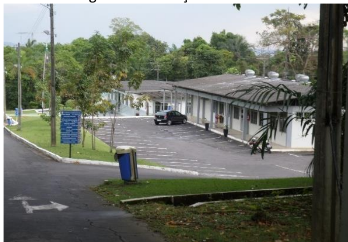
Figura 4: Instalações do 4º CTA
