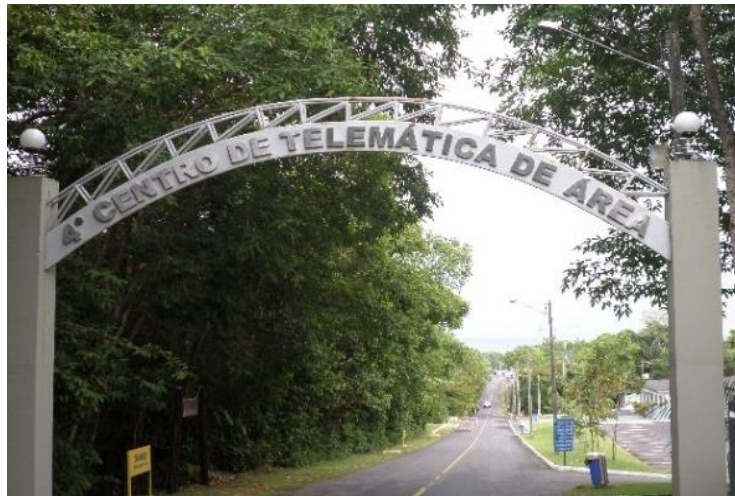
Figura 3: Portal de Entrada do 4º Centro de Telemática de Área.
