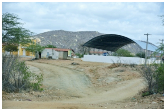
Figura 46 - Centro da comunidade com estrada principal
