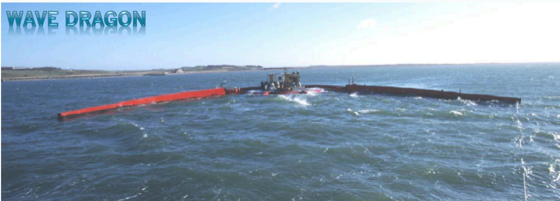
Fig. 2.14 - Wavedragon. Central piloto no local de teste em Nissum Bredning/Dinamarca numa zona marítima protegida no mar do Norte, a uma profundidade de 6 m.
