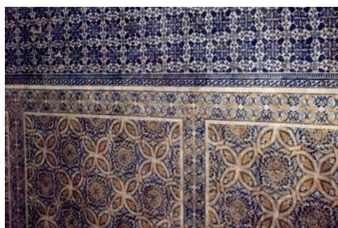
(b) Revestimento em azulejos na superfície interior das paredes
