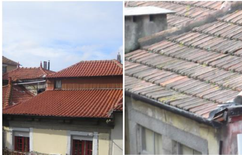
Figura 6.20 (Esquerda) – Revestimento em telha de canal; Figura 6.21 (Direita) – Revestimento em telha de marselha (Fonte: Teixeira, 2013a)
