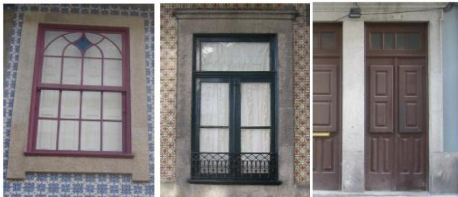
Figura 6.12 (Esquerda) – Janela de peito de guilhotina (Fonte: Teixeira, 2013a); Figura 6.13 (Centro) – Janela de peito de batente com grade (Fonte: Teixeira, 2013a); Figura 6.14 (Direita) – Porta de duas folhas com bandeira envidraçada (Fonte: Teixeira, 2013a)
