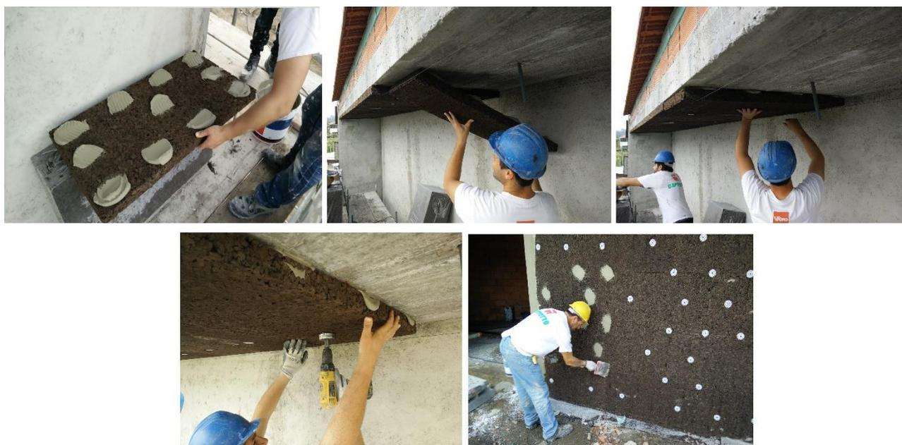
**Figura 80 - Sequência de aplicação da fixação mecânica**
