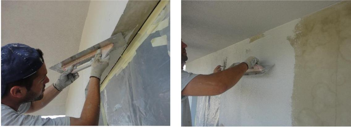
**Figura 85 - Aplicação do Visolplast RSTF**
