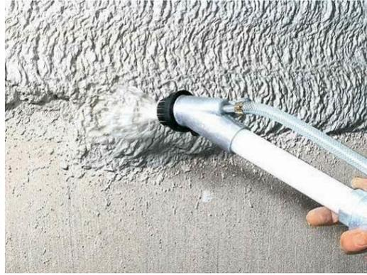
**Figura 35** - Aplicação de reboco isolante
