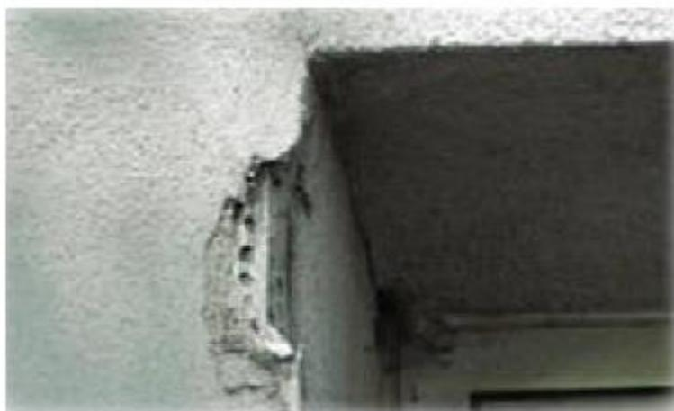
**Figura 104** - *Degradação do revestimento das cantoneiras de reforço*
