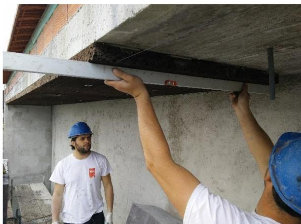
**Figura 79** - *Verificação do nivelamento do sistema através de um nível de bolha de ar*
