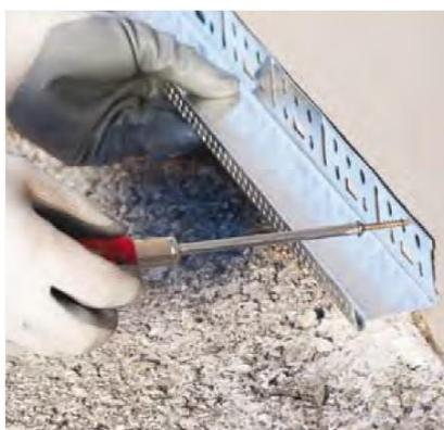
**Figura 70 - Colocação do perfil de arranque**
