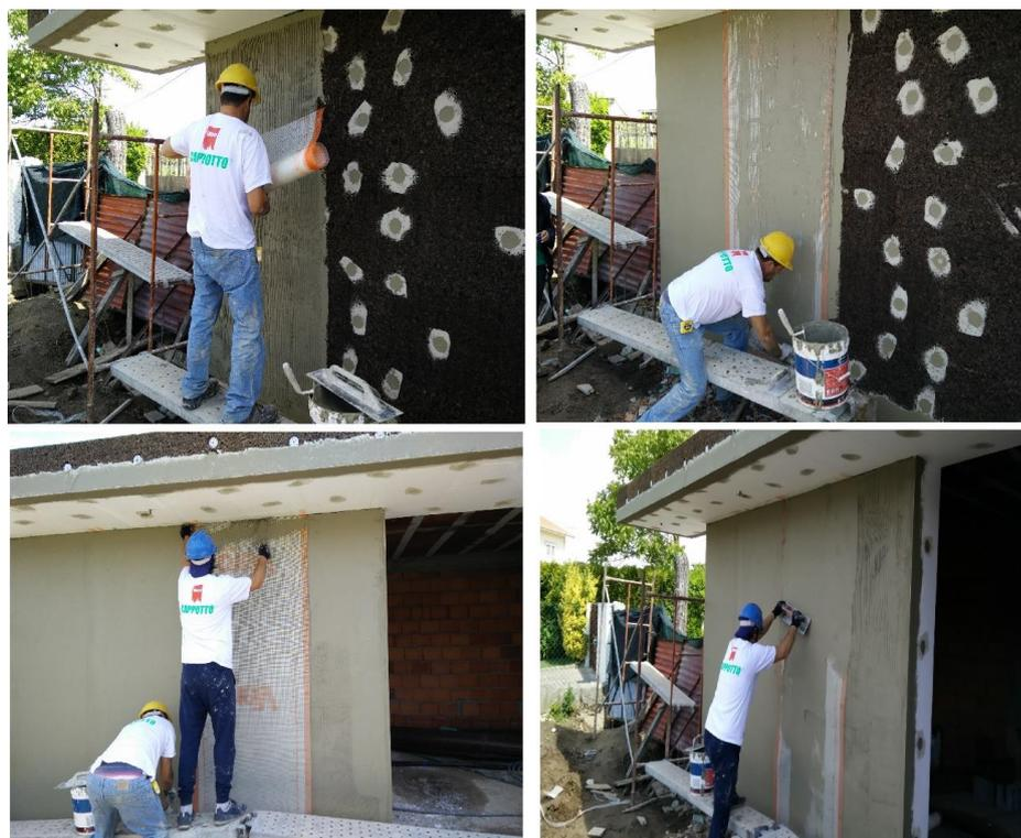
**Figura 84 - Sequência de aplicação da camada de base**
