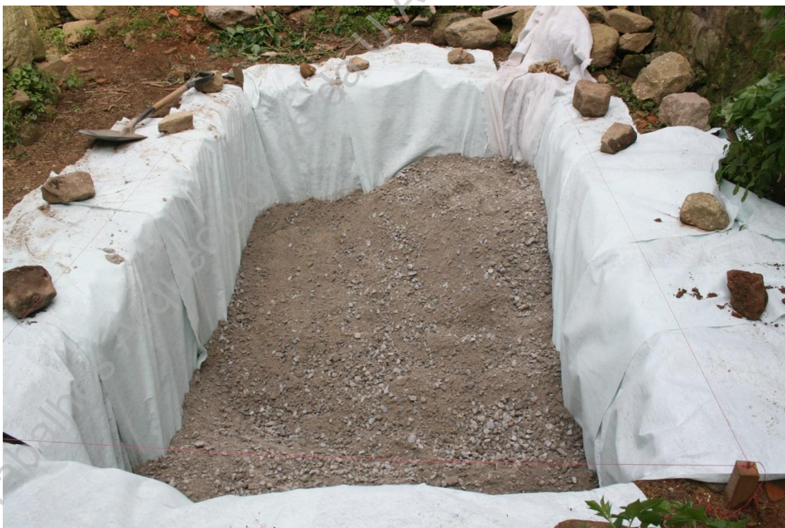
Foto 58 (BRA15RVP 1-3_IMG_7093) – Cobertura com brita sobre geotêxtil da sondagem 2.
