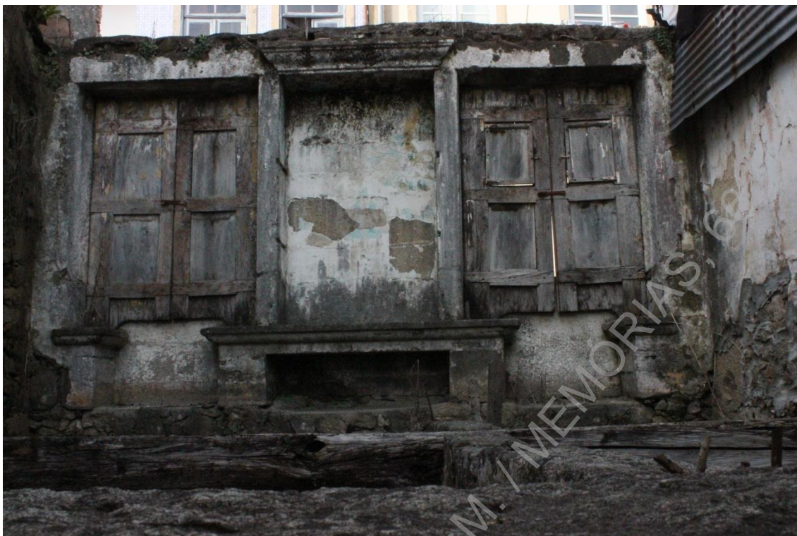
Foto 1 (BRA15RVP 1-3_IMG_2918) – Fachada.
