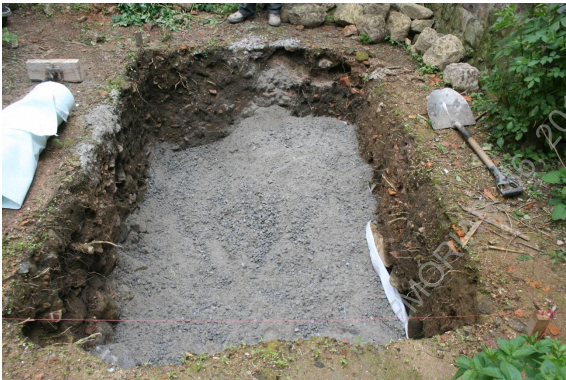
Foto 57 (BRA15RVP 1-3_IMG_7081) – Cobertura com brita sobre geotêxtil da sondagem 2.
