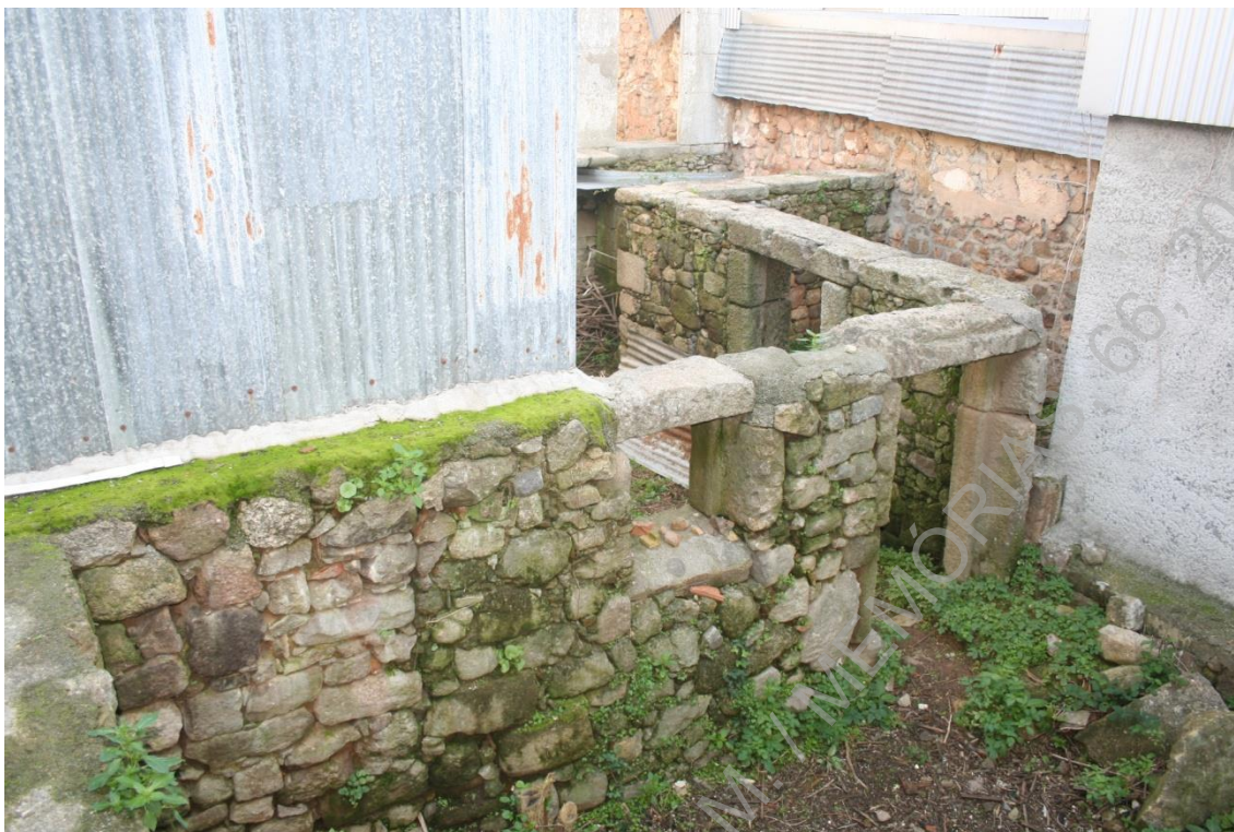
Foto 3 (BRA15RVP 1-3_IMG_5810) – Alçado oeste da UE023 e Alçado sul da UE024.
