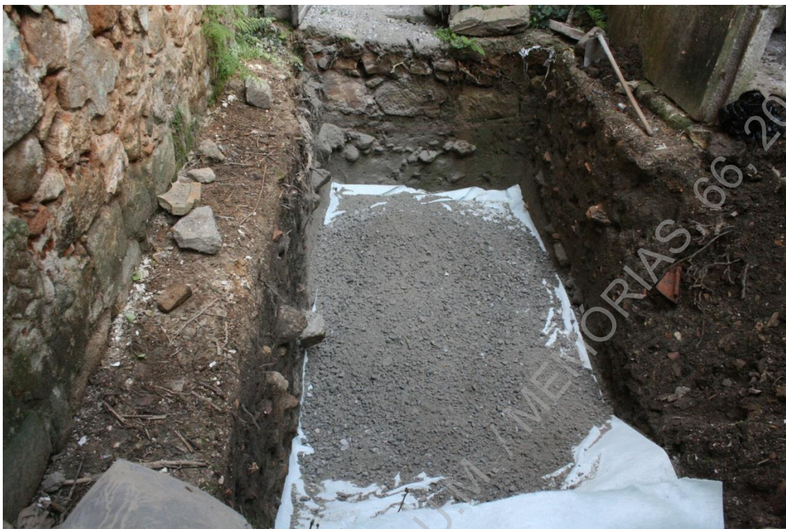
Foto 55 (BRA15RVP 1-3_IMG_7062) – Cobertura com brita sobre o geotêxtil da sondagem 1.
