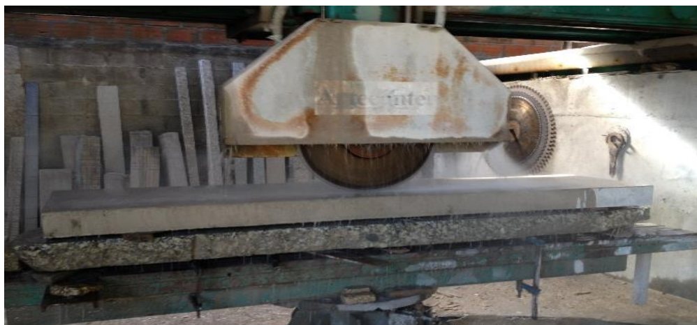
Figura 3.20 - Abertura de ranhuras onde os laminados de CFRP são introduzidos, de acordo com a técnica NSM.
