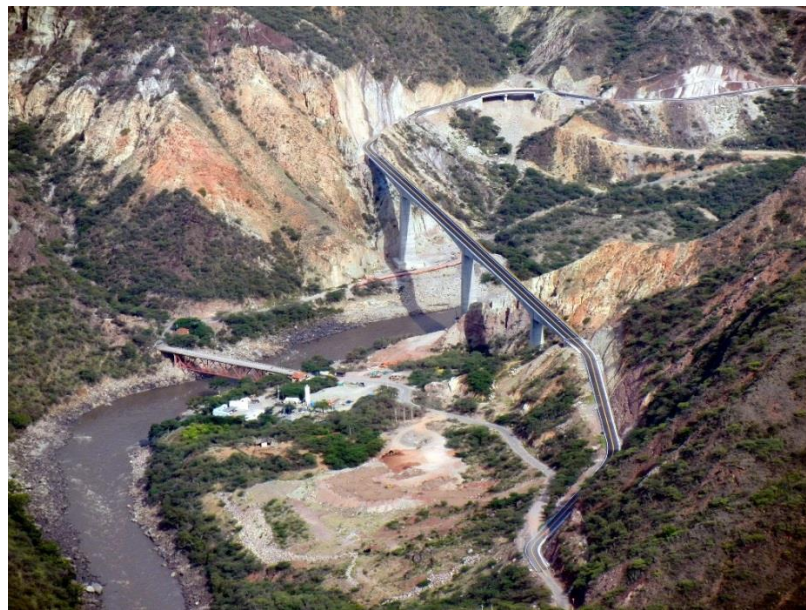
Figura 13. Vista aérea Nuevo Puente Gómez Ortiz a la derecha y antiguo puente a la izquierda. Vanguardia Liberal.
