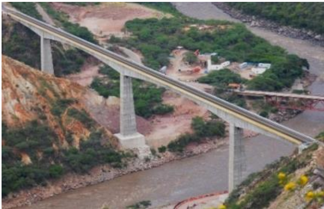
Figura 19. Puente Gómez Ortiz. Autor
