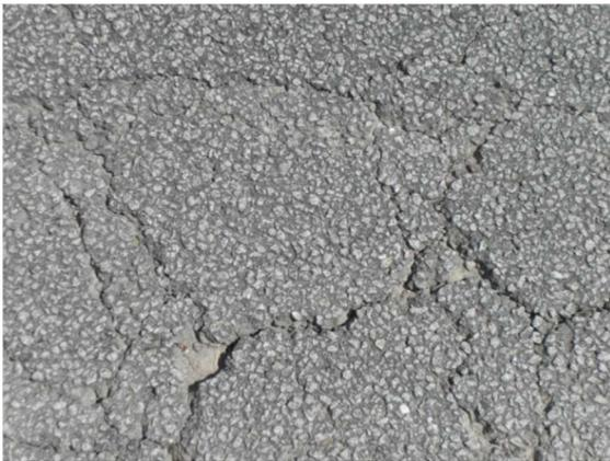
Figura 15 – Pavimento MBB com pele de crocodilo
