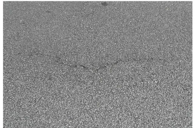
Figura 16 – Pavimento MBMB com fendilhamento
