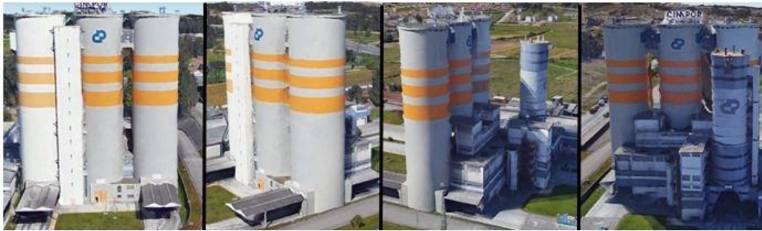
Figura 32 - Silos Maia: Montagem panorâmica
