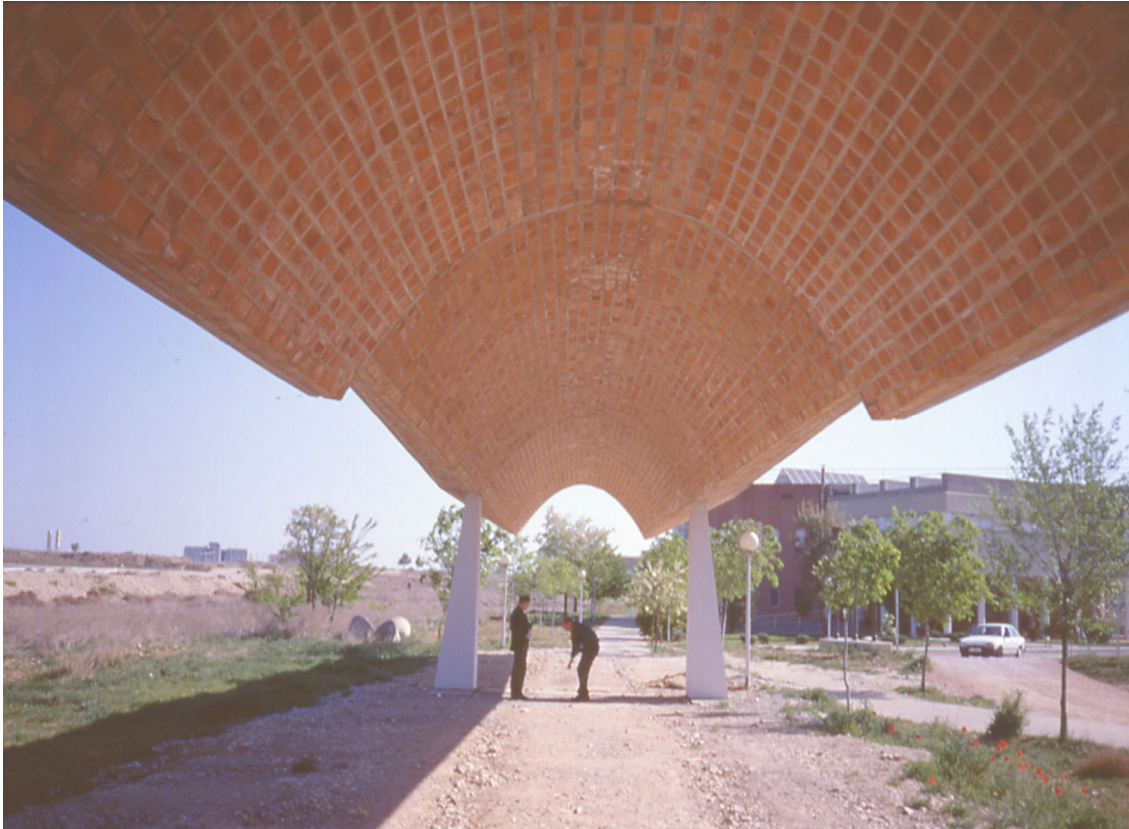
Figura 2 – Construção de casca em alvenaria cerâmica armada, inspirada no trabalho de Dieste, na Espanha.
