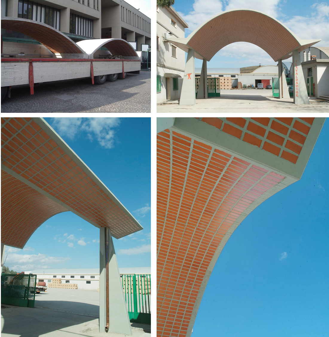
Figura 9 – Casca, recentemente construída em Itália, aplicando-se a metodologia desenvolvida no projecto ISO-BRICK, no qual este trabalho está incluído.
