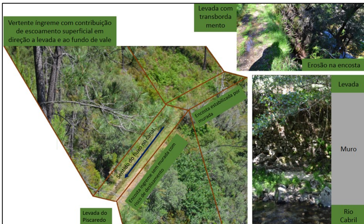
Figura 5. A levada na encosta com setores com e sem medidas de contenção para erosão
