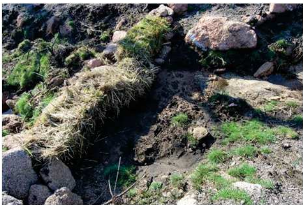
Figuras 5 e 6. Material acumulado nas barreiras de palha e de restos de pinheiros e caruma.
