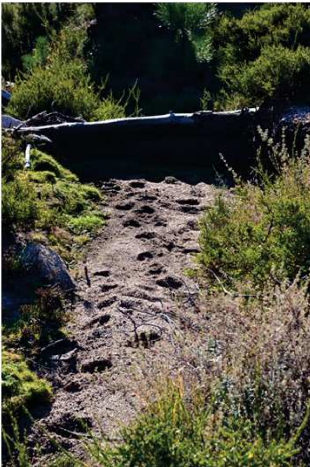
Figura 4. Material acumulado na barreira de troncos.
