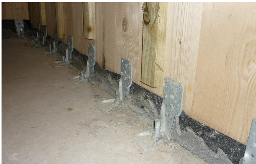
Figura 4.7 – Ligações com espaçamento entre 300-500mm.
