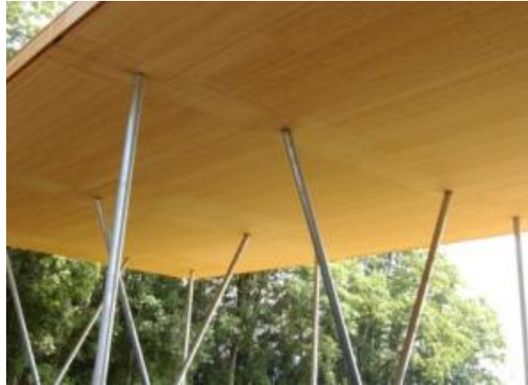
Figura 4.13 – Lajes CLT e pilares
