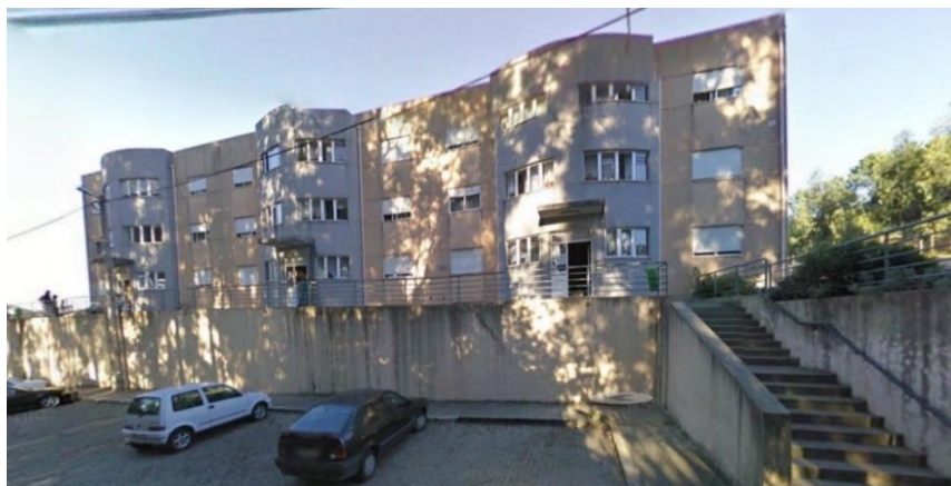
Figura 12 - Fachada principal do Edifício Engenheiro Mota Pinto
