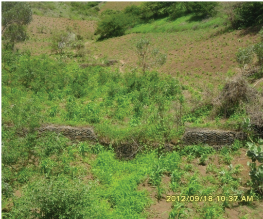
Fot. 8 - Pequeno dique de contenção da erosão na zona de Pinha (Fonte: F. Sanches, 2012).
