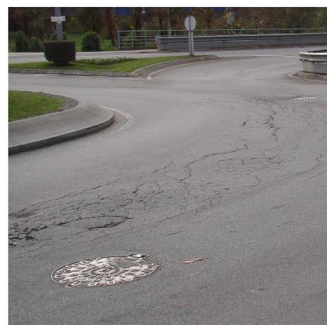
Figura 2.1 – Exemplo do estado avançado de degradação observado num número significativo de pavimentos rodoviários atuais.
