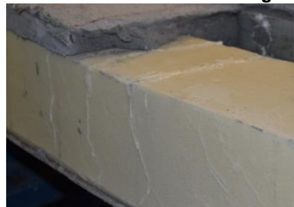
e) Crushing of PU foam
