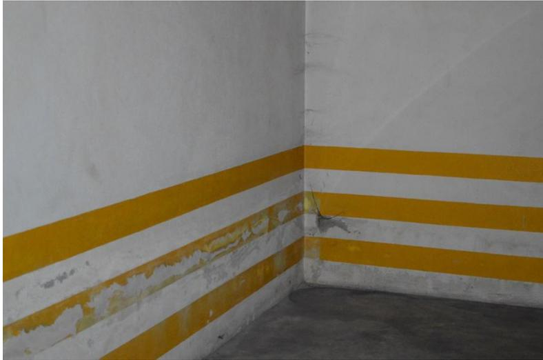
Figura 3 - Parque de estacionamento do Mercado, Estado de conservação dos revestimentos
