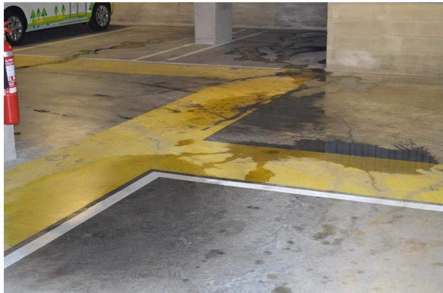
Figura 5 - Parque de estacionamento da Avenida Dom Afonso III, Estado de conservação dos pavimentos (B)
