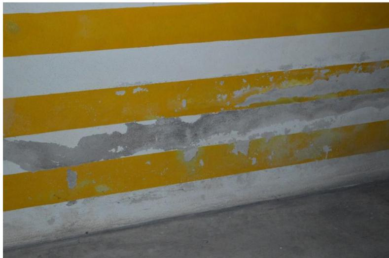
Figura 2 - Parque de estacionamento do Mercado, Estado de conservação dos revestimentos
