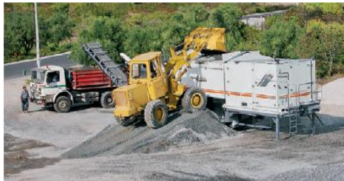
Figura 2.4 – Exemplo de reciclagem a frio em central móvel (Wirtgen, 2012)
