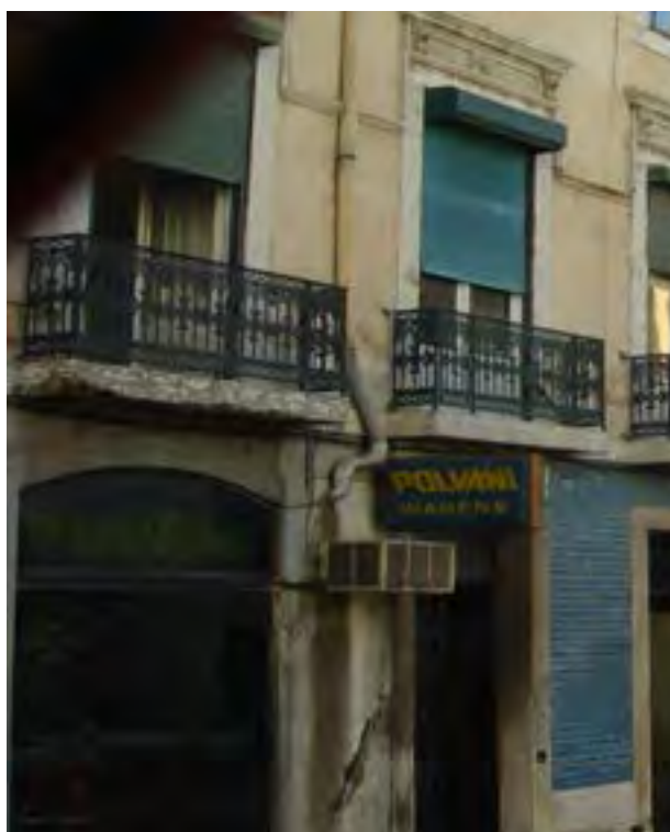
Figura 2. Pormenor de fachada (Reaes Pinto)
