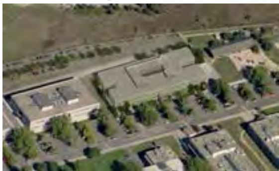
Figura 1. Visão aérea do projeto de Renovação do edifício Hovione R&D Building S, imagem 3D.
