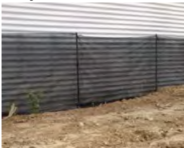
Figura 17. Vedação de protecção
