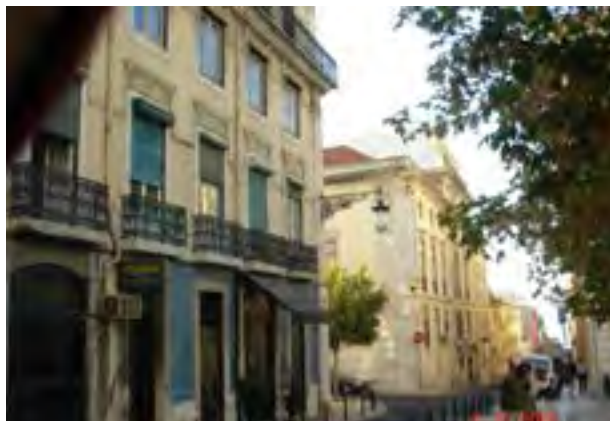
Figura 1. Fachada degradada num edifício tradicional pombalino (Reaes Pinto)
