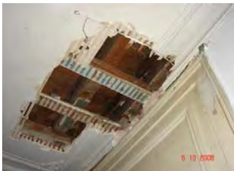
Figura 4. Tecto estucado degradado (Reaes Pinto)
