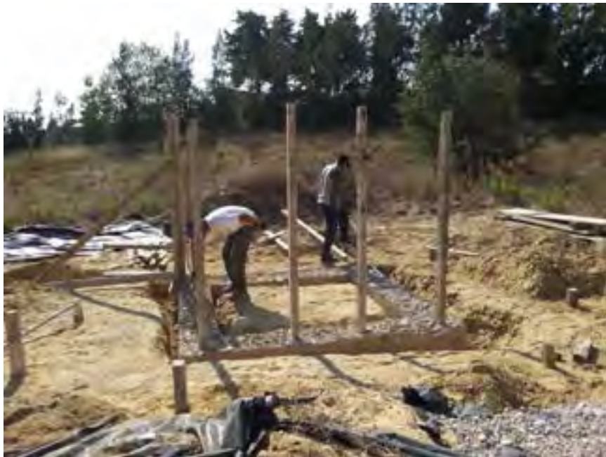
Figura 4. Protótipo 3 - Construção das fundações, colocação da estrutura interna de contraventamento e dos cimbres para alinhamento lateral.
