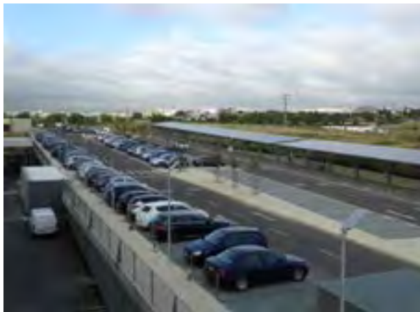
Figura 11. Estacionamento coberto com painéis fotovoltaicos.
