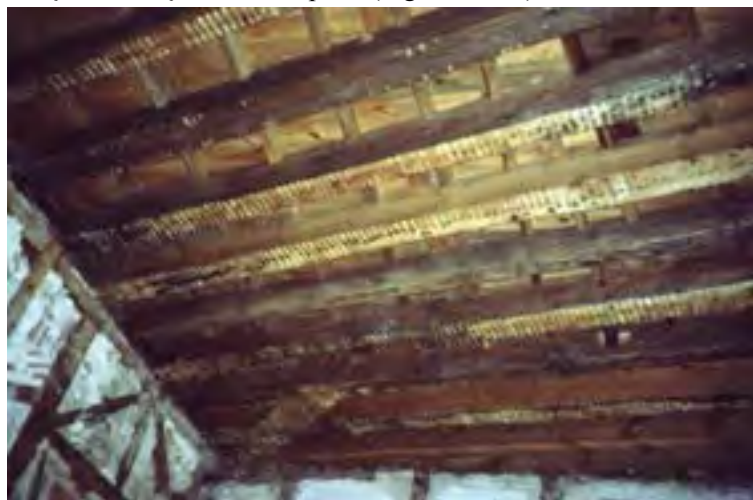
Figura 3. Elementos estruturais de pavimentos tradicionais (Reaes Pinto)
