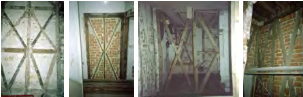
Figuras 5. Paredes tradicionais. Fases de reabilitação: fechamento de vãos e construções de novas paredes resistentes segundo os princípios da construção pombalina. (Reaes Pinto)
