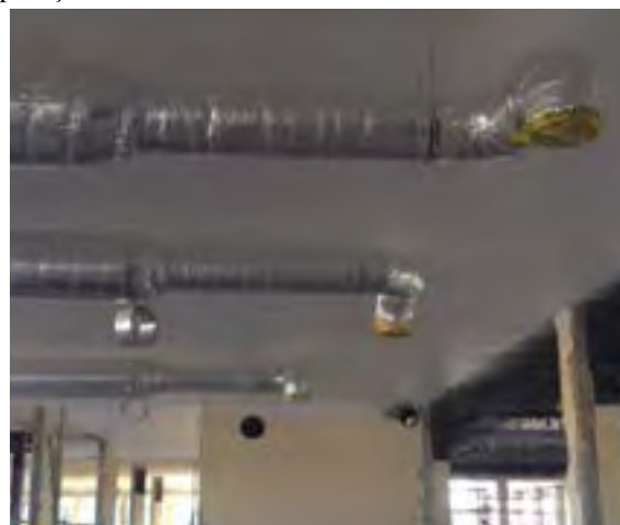
Figura 18. Protecção das condutas de AVAC durante a obra.
