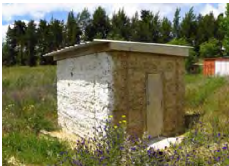
Figura 7. Protótipo 3 - Detalhe da construção da cobertura e vão de porta
