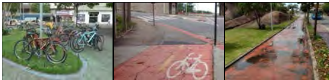
Figura 4. À esquerda, exemplo de poucos estacionamentos para bicicletas; ao centro, pavimentação inadequada com descontinuidade da via; e à direita, drenagem ineficiente. Fonte: autores.
