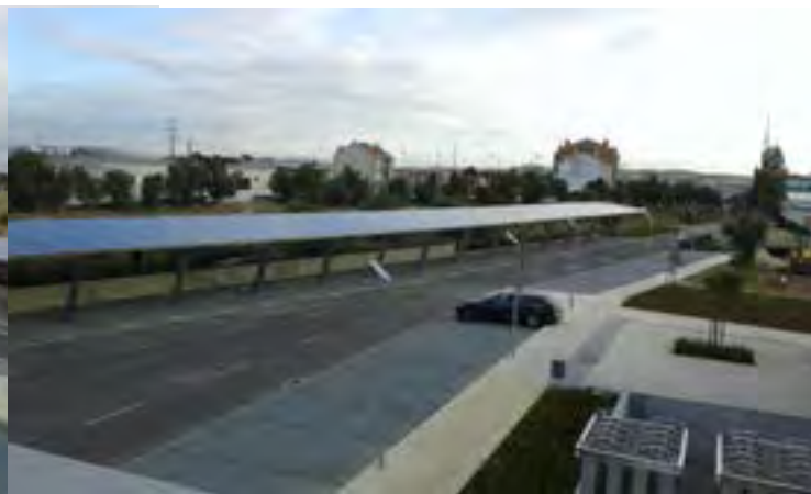
Figura 12. Pormenor da cobertura do estacionamento.
