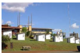
Fig. 7 Vista da fachada Norte do Canteiro Experimental com os 10 protótipos monitorados por meio de registros automáticos, construídos em escala real, na Escola de Engenharia de São Carlos, Campus da USP
