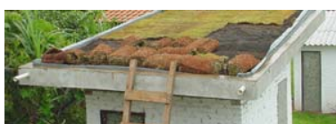
Fig. 2 Substrato, terra vegetal e grama esmeralda, aplicado sobre o elemento drenante Macdrain 2L. A figura mostra a colocação do substrato (terra vegetal com “tapetes de grama” sobre a geomanta de escoamento da água MacDrain 2L, da Maccaferri, empresa parceira na investigação das coberturas verdes leves (CVLs)
