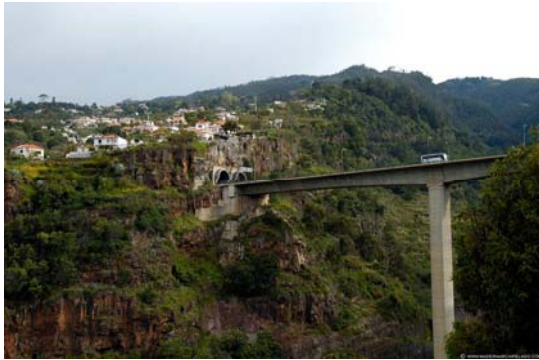
Fig. 2 Via Rápida (viaduto e túnel)
