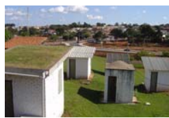
Fig. 8 Vista geral dos protótipos construídos em alvenaria de tijolos cerâmicos maciços, com diferentes coberturas para análise do comportamento térmico
