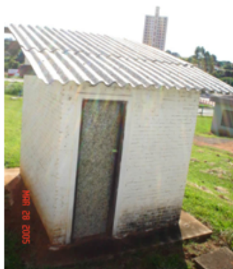
Fig. 3 Protótipo com telha reciclada Tetra Pak
