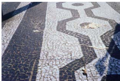
Foto 8 Piso inadequado pelo tipo de material
