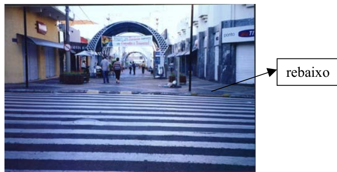
Foto 16 Início do Calçadão – guia rebaixada na lateral
