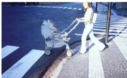
Foto 6 Guia inadequada na Av. Rodrigues Alves – travessia de carrinho de bebê
