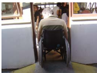
Fig.38 Rampa íngreme Acesso principal do refeitório é estreito e a rampa é muito inclinada.
