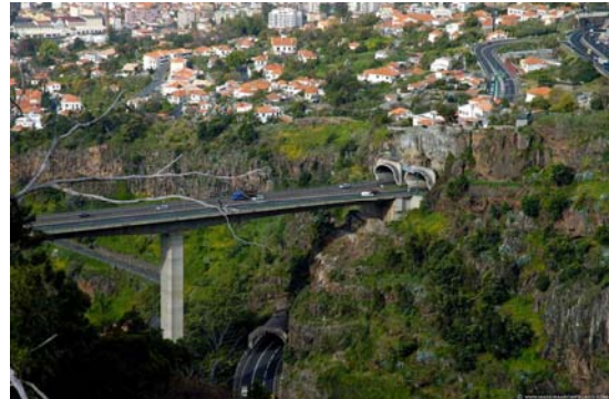
Fig. 3 Via Rápida (viaduto e túnel)
