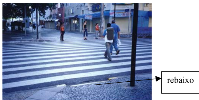
Foto 17 Calçadão – guia rebaixada na lateral
