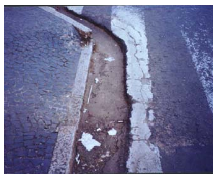
Foto 2 Detalhe do rebaixamento da guia com degrau na sarjeta
