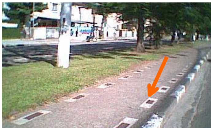
Fig. 10 Ciclovia da Av. Afonso Pena
