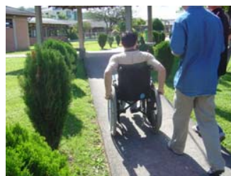
Fig.37 Caminho estreito Caminho estreito impede a passagem de um cadeirante e um transeunte simultaneamente.
