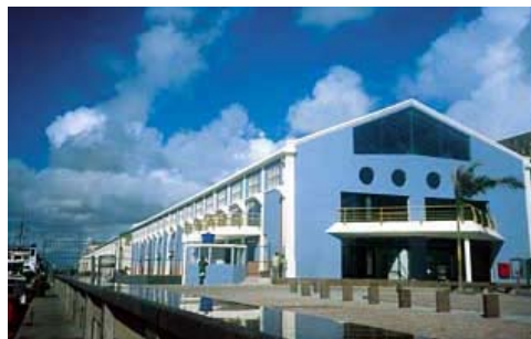
Fig. 2 Terminal Marítimo de Passageiros
