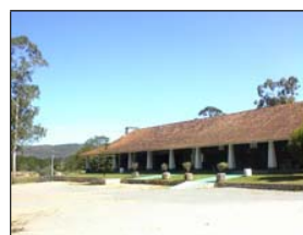
Fig. 13: Edificação Refeitório do Parque Florestal do Rio Vermelho
