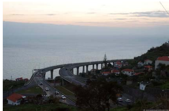
Fig. 5 Via Rápida (viaduto)
