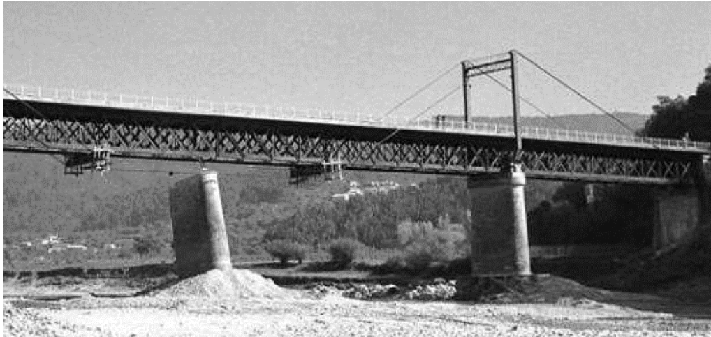
Figura 3.4 - Ponte de Penacova suportada por cabos externos
