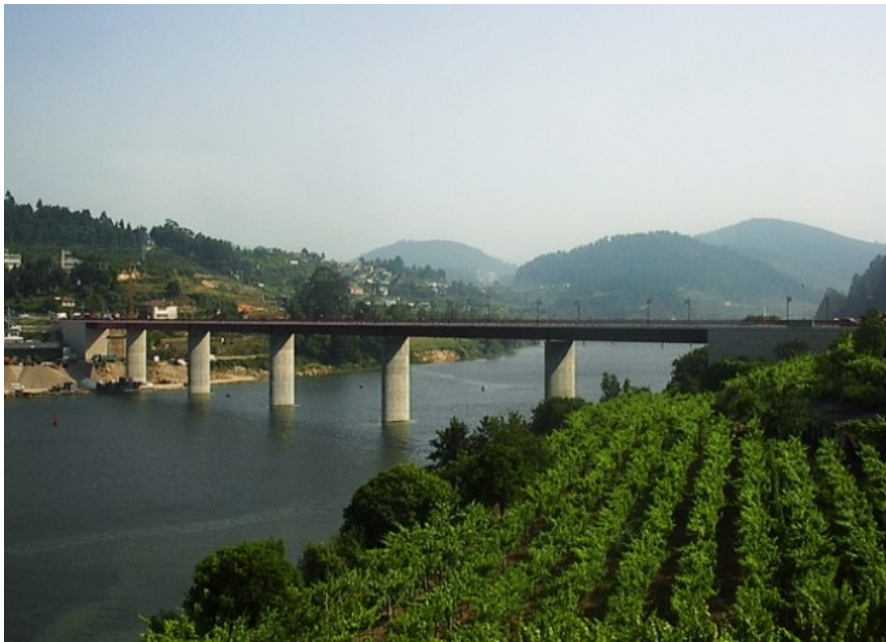
Figura 3.1 - Ponte Hintze Ribeiro (Estrutura Intacta)
