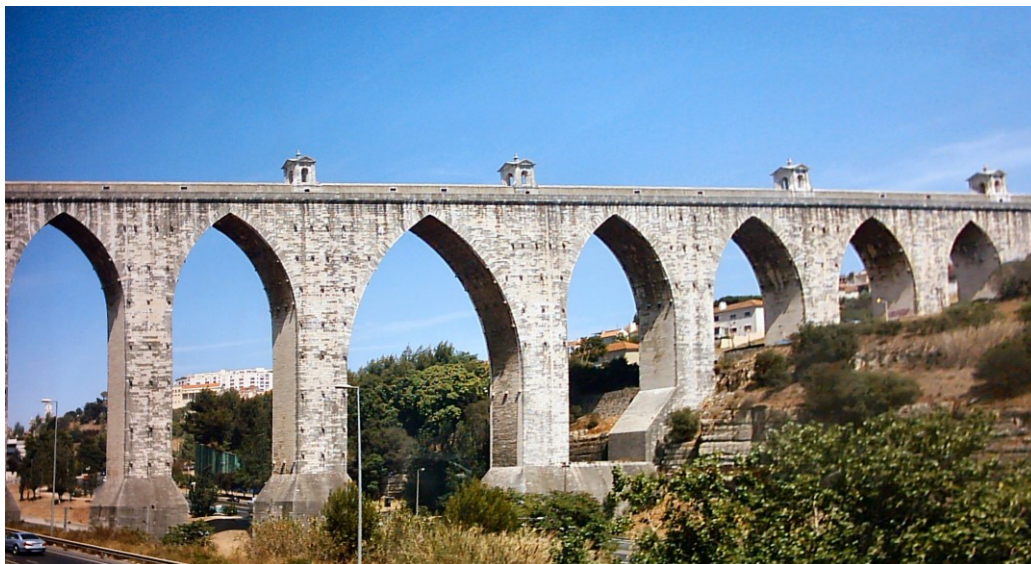
Figura 2.1 - Aqueduto das Águas Livres (Lisboa)
