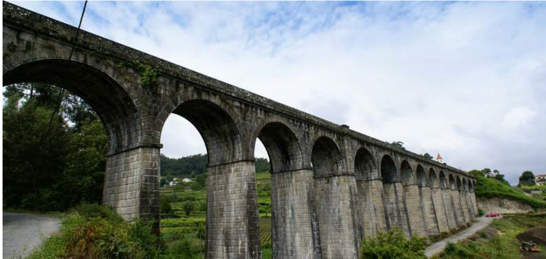
Figura 2.2 - Viaduto Ferroviário de Durrães
