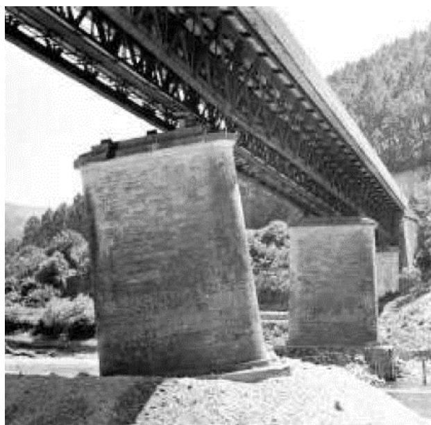
Figura 3.3 - Ponte de Penacova, 1975 (adaptado de EP-Estradas de Portugal (2012))
