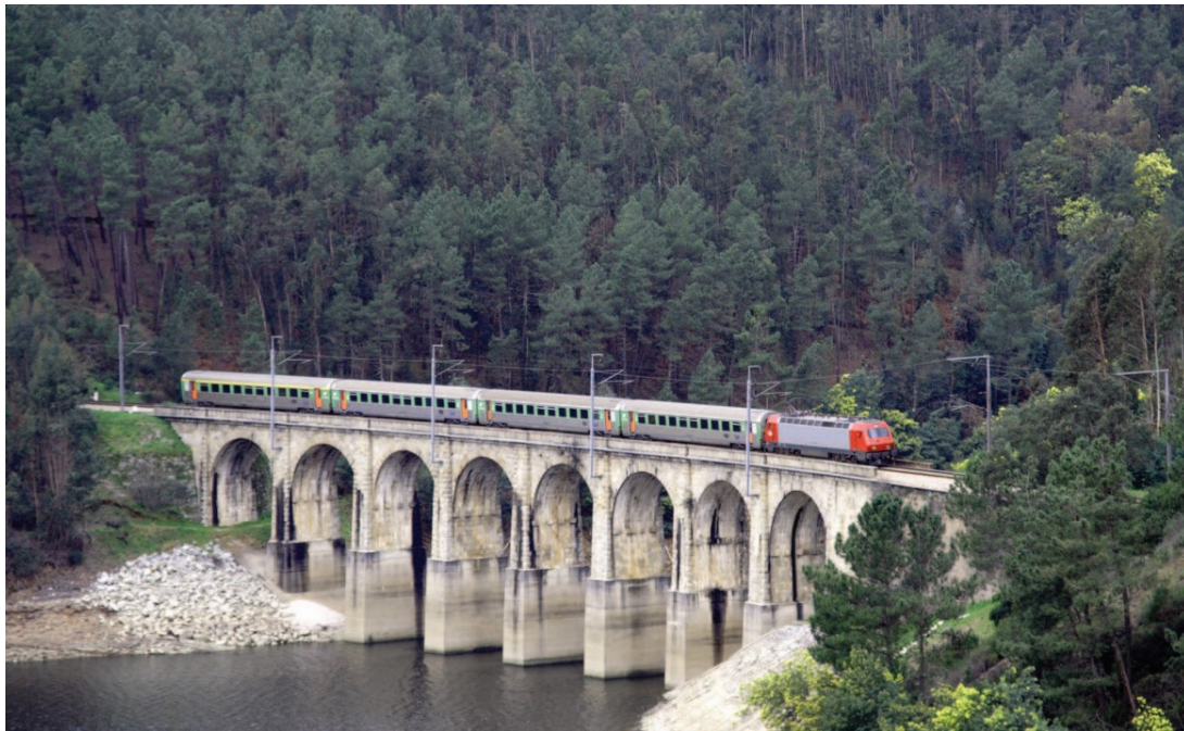
Figura 2.3 - Ponte Ferroviária de Coval
