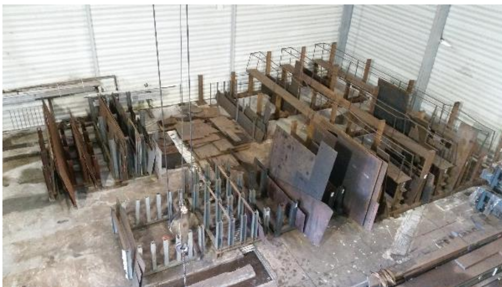
Figura 61 - Estado do fosso atual
