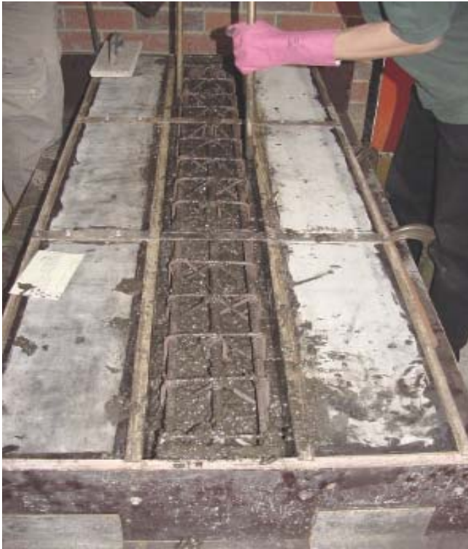
Fig. 8 – Betonagem de pilar com betão geopolimérico à base de cinzas volantes [ 20 ]
