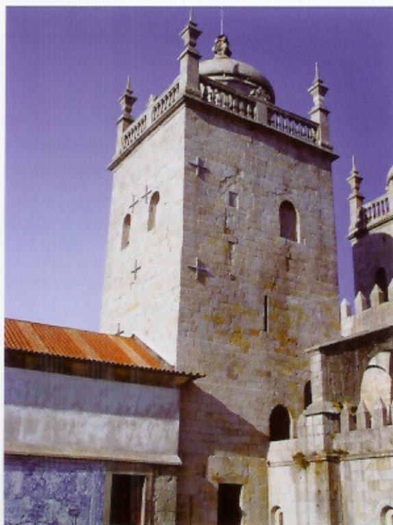
7. Aspecto da torre sul após conclusão dos trabalhos
