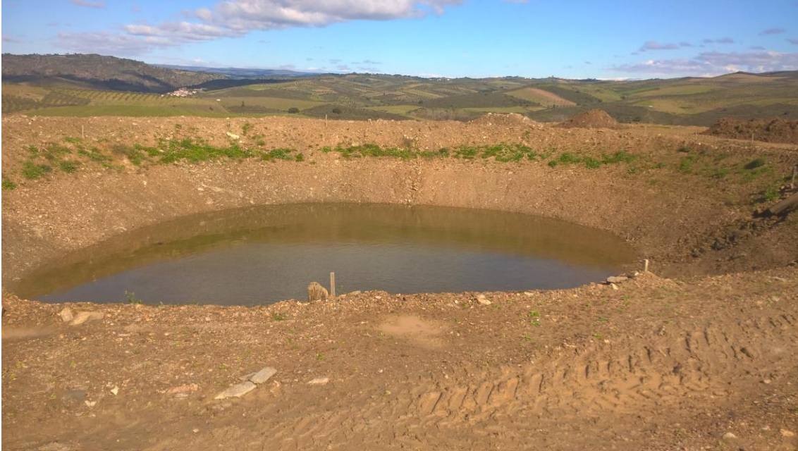
Figura 8.27 - lago que faz de reservatório com a capacidade de 1500 m 3 ou 1500 000 litros de água. Foto do autor.
