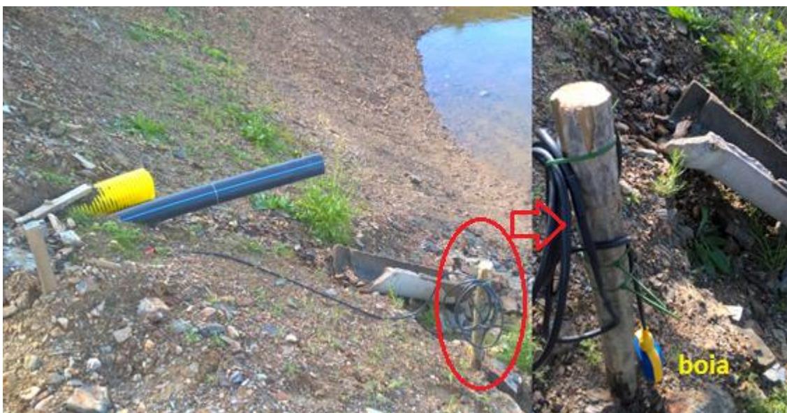
Figura 8.29 - saída do tubo de água no lago e boia ou controle de nível. Foto do autor.
