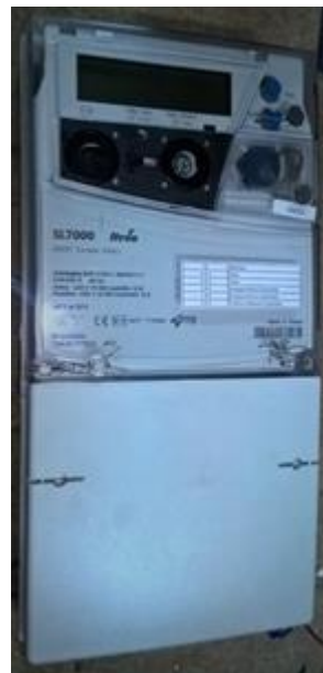
Figura 7.17 - contador bidirecional Itron SL7000. Foto do autor.
