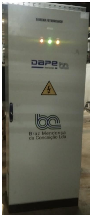
Figura 7.26 - quadro geral da instalação FV. Foto cedida pela DAPE.
