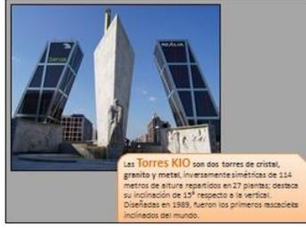
Las **Torres KIO** son dos torres de cristal, granito y metal, inversamente simétricas de 114 metros de altura repartidos en 27 plantas; destaca su inclinación de 15° respecto a la vertical. Diseñadas en 1989, fueron los primeros rascacielos inclinados del mundo.
