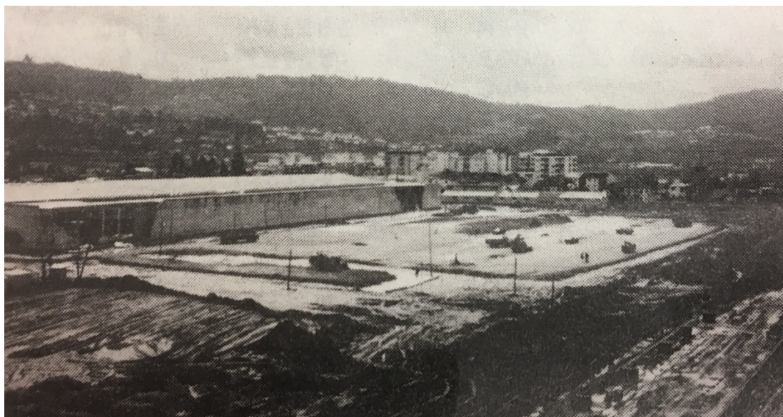
Figura 56: Construção do Hipermercado Feira-Nova e da Av. Padre Júlio Fragata – 19 de Junho de 1989. Fonte:(ASPA, 1989b)
