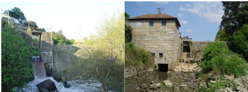
Fotografia 4. Dique da Central Elétrica da Empresa Industrial de Pevidém. Fotografia 5. Aproveitamento hidroelétrico do Carvalho do Moinho e dique adjacente.
