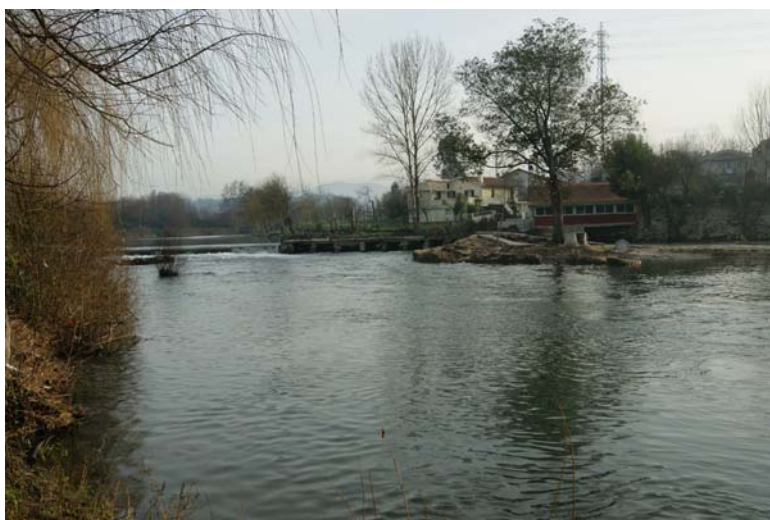
Fotografia 3. Dique no rio Ave, junto ao lugar de Ponte Nova.
