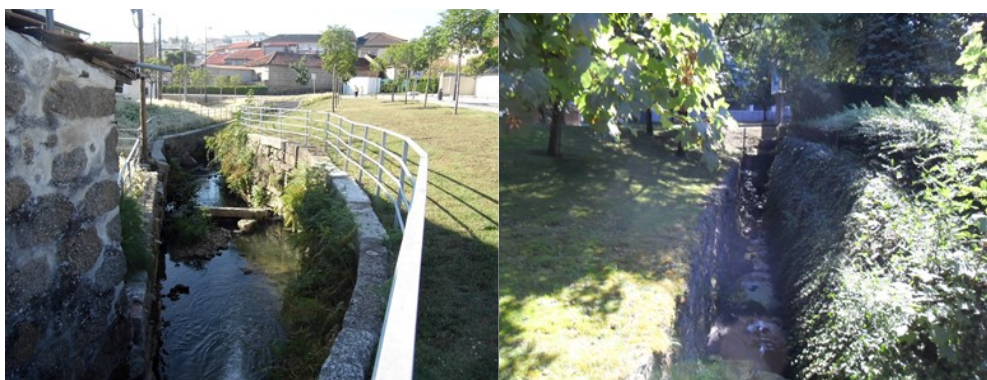
Fotografias 11 e 12. Margens com muros na ribeira de Couros.
