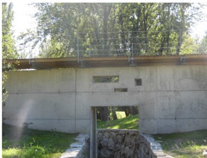
Fotografia 13. Ponte na ribeira de Couros.
