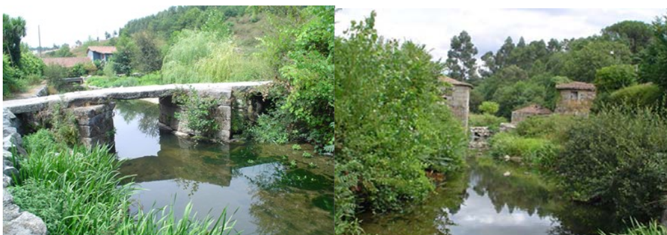
Fotografia 6. Ponte de pedra a montante do lugar de Selho. Fotografia 7. Construções que estrangulam o curso de água.
