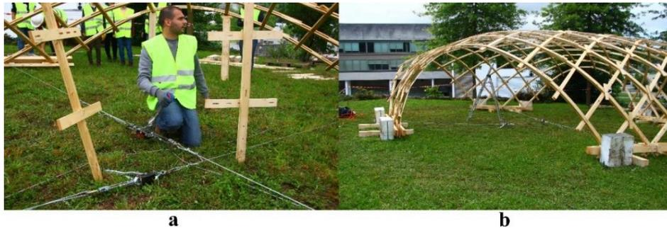
Figura 13: Aplicação de cargas com o sistema de cabos e alavancas (a) e aplicação de blocos de betão como apoios da estrutura (b).
