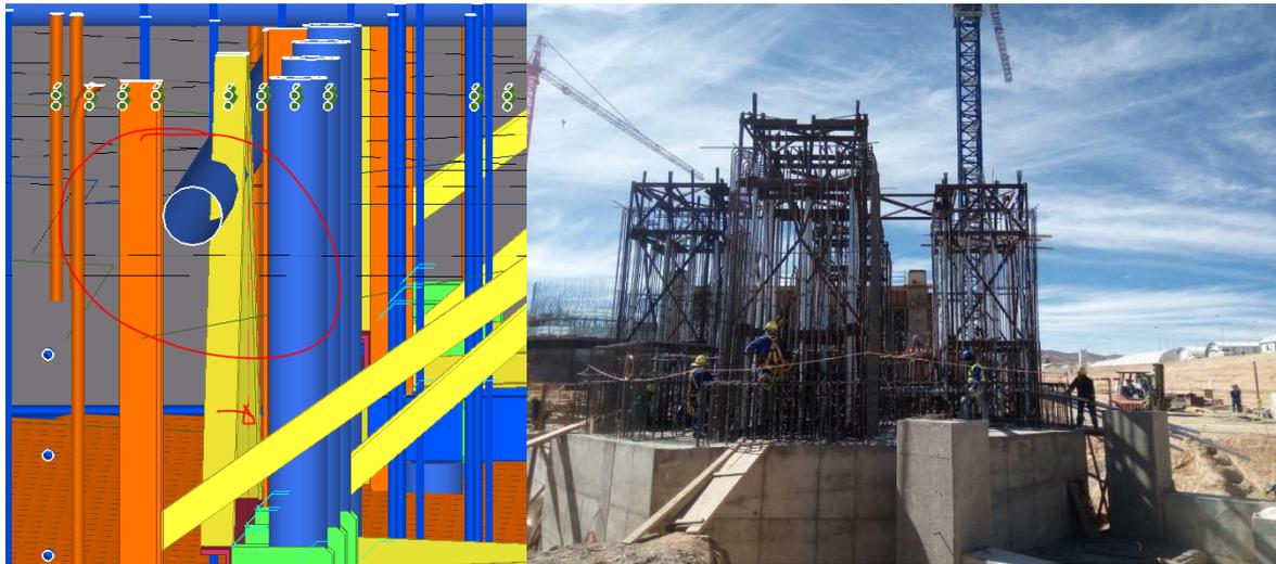
Figura 7: a) Colisão detetada em fase de projeto b) obra.
