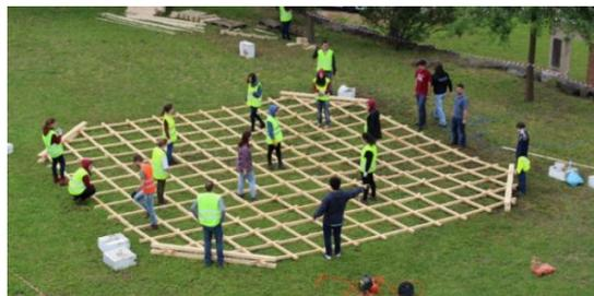
Figura 11: Construção da malha plana.
