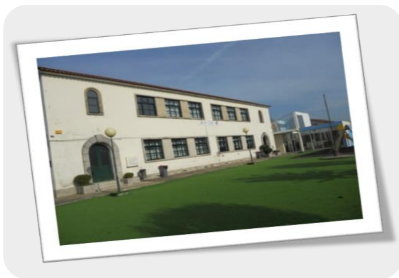
Ilustração 1 - Edifício da Escola
