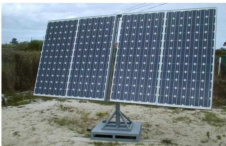
Figura 2 – Unidade de fixação e orientação dos painéis solares fotovoltaicos.
