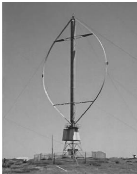
Figura 2.1 - Turbina Eólica Darrieus [14].
